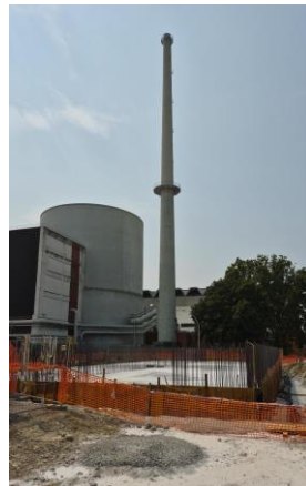
Realizzazione delle fondamenta e del solaio
