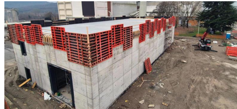
Completamento delle opere civili
