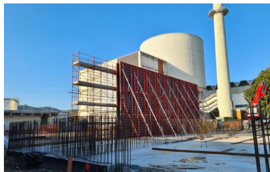
Realizzazione delle pareti esterne ed interna
