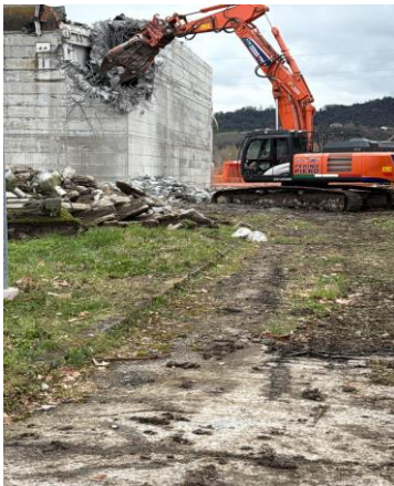
Demolizione del Deposito esistente
