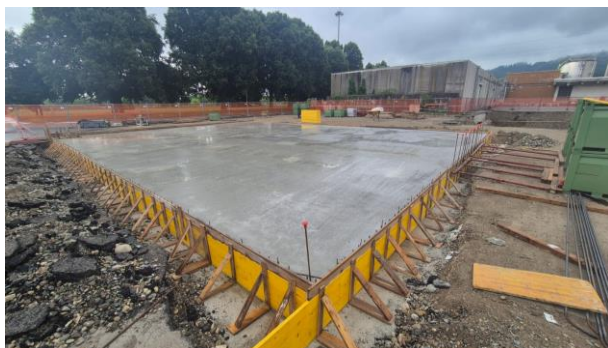
Realizzazione della Baia di Deferrizzazione
