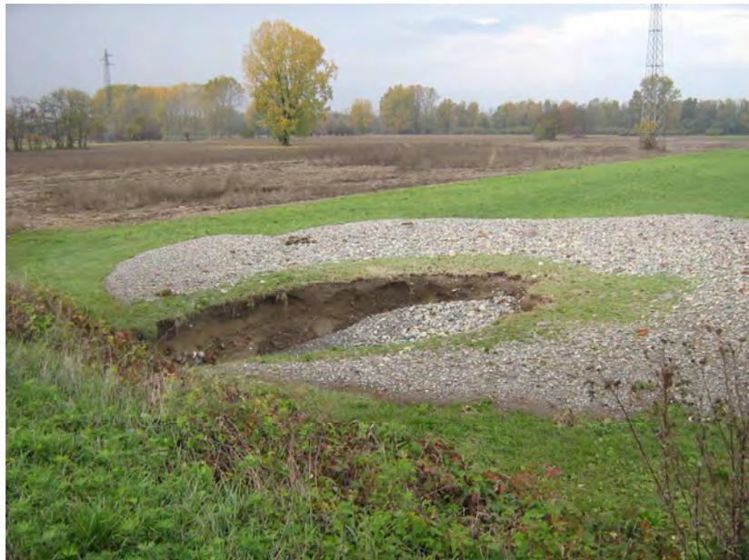
*Comuni di Capriata d'Orba-Predosa: evidenti segni di erosione, deposizione e sifonamento lungo il rilevato della SP. n. 179 per l'esondazione del T. Orba.*
