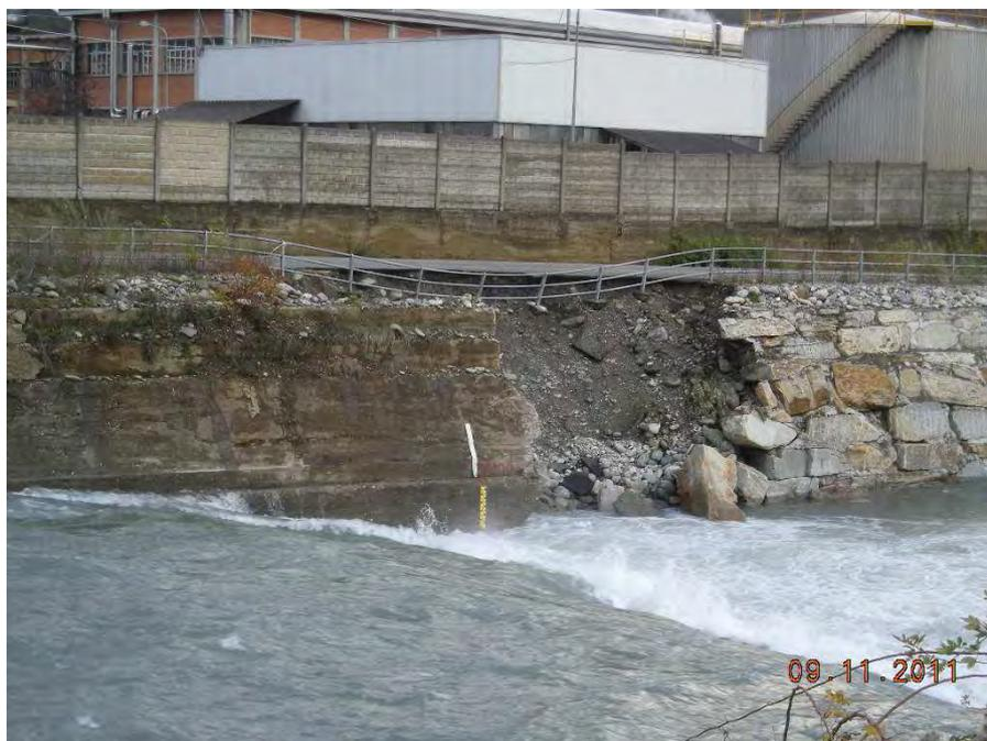
*Comune di Villar Perosa: erosione di sponda con asportazione del muro ad opera del Torrente Chisone*
