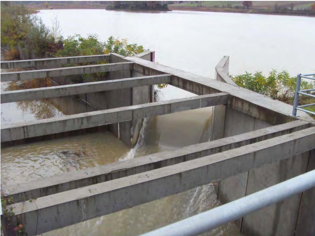
*foto 5 Scarico di mezzofondo e sfioratore di superficie*
