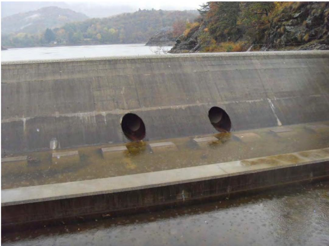
*foto 1 Scarichi di fondo e soglia dello sfioratore di superficie visti da valle*
