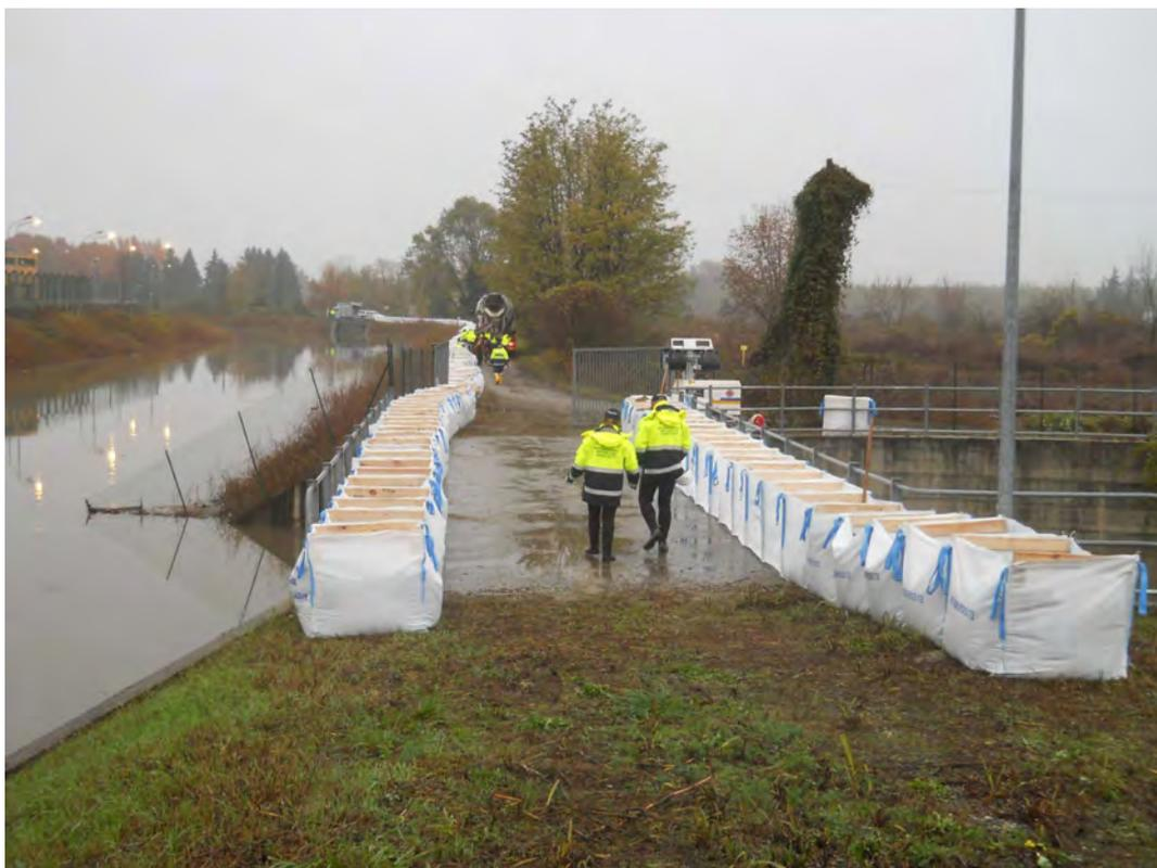
Fig. 7: Vista della barriera *Big-bag* in vicinanza della stazione di pompaggio
