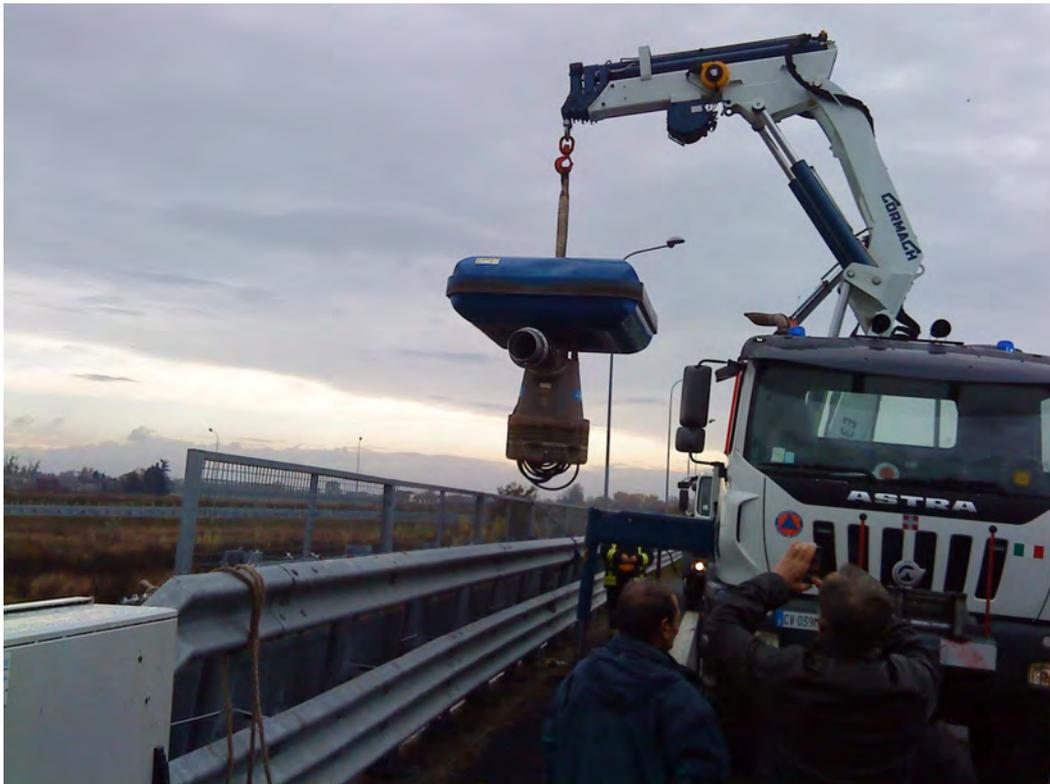
Fig. 4: Movimentazione e posa elettropompa
