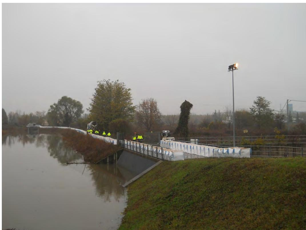
Fig. 8: Sviluppo della barriera temporanea in sponda sinistra del canale Roggione
