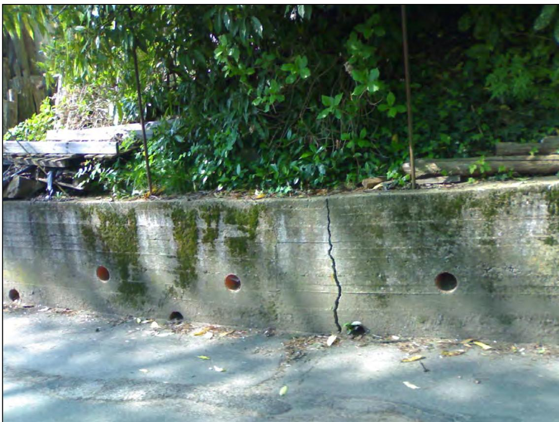
Grignasco, fraz. Ara , muro di controripa fessurato e ruotato
