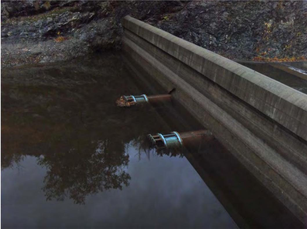
*foto 2 Scarichi di fondo e soglia dello sfioratore di superficie visti da monte*
