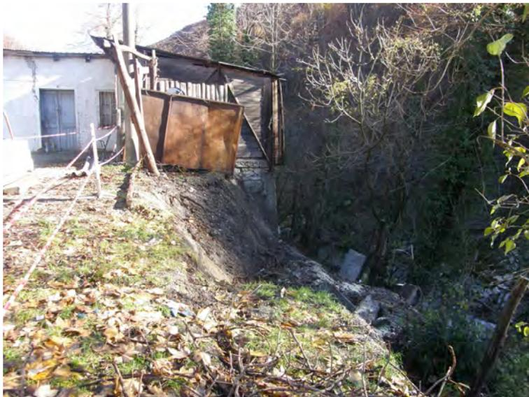
*Comune di Druogno: piazzale in sinistra, Melezzo. Frana, visibile la superficie di distacco e l'accumulo, con porzioni di muro di sostegno distrutto. In primo piano, blocco fessurato e ribassato*
