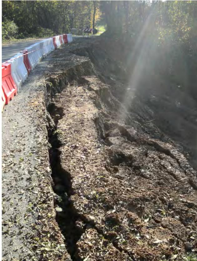
*Comune di Vidracco: A tergo del coronamento sono presenti porzioni di terreno instabili e talora già ribassate rispetto al p.c., delimitate a tergo da fratture di trazione.*
