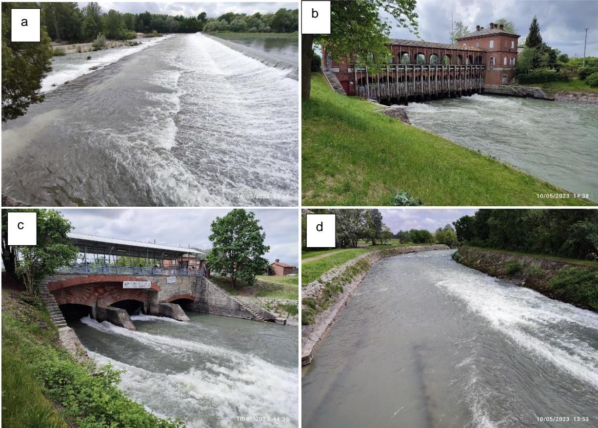
Figura 5-15: traversa in alveo (a), derivazione Canale Farini (b), presa (c) e canale scaricatore (d) e localizzazione (sopra)
