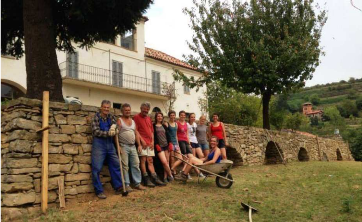
Muro di contenimento del terrazzo che circonda Monteoliveto, Cortemilia – lavoro di recupero ultimato, settembre 2014
