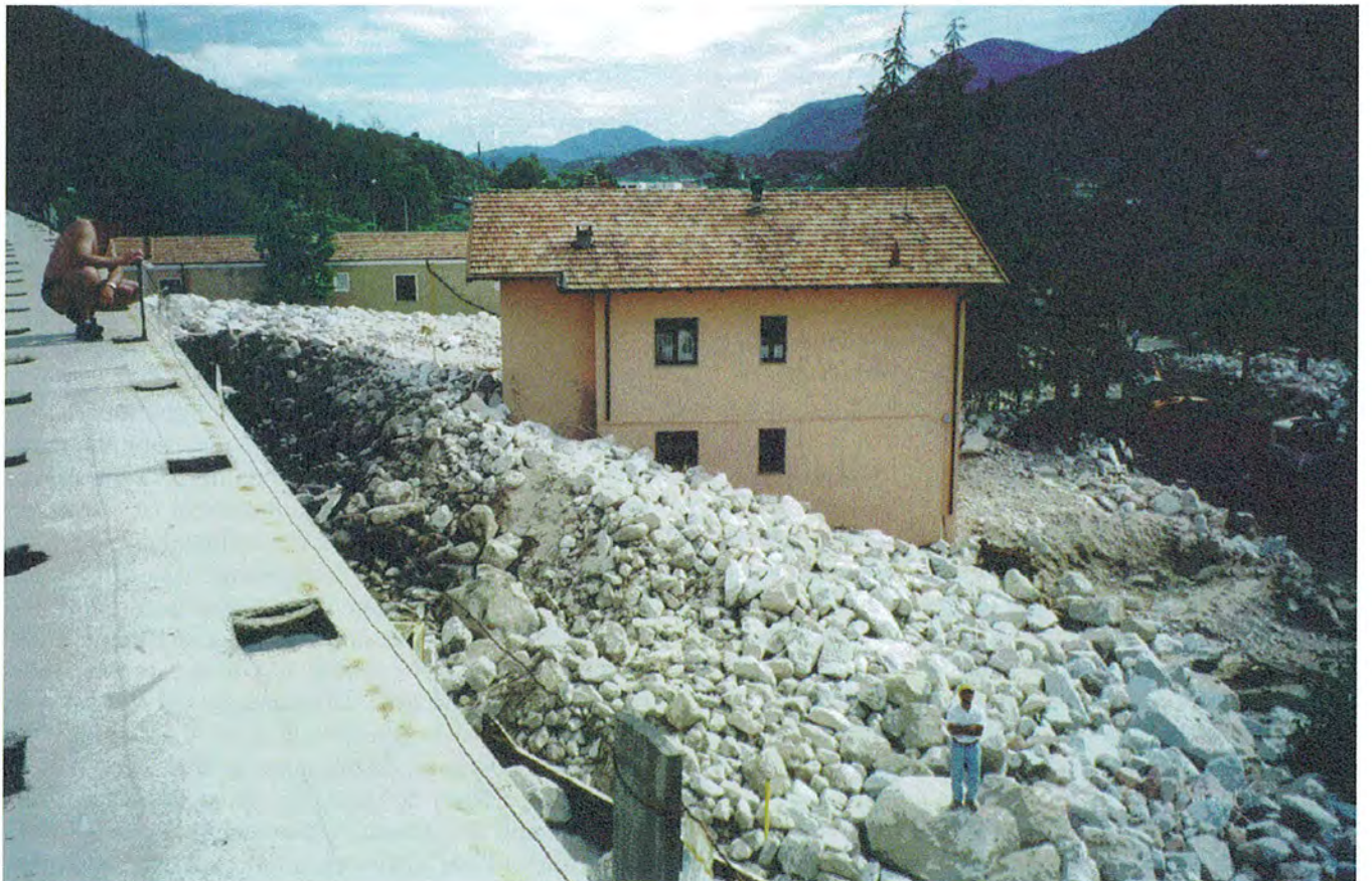
Fig. 10. Omegna, Rio Inferno. Edifici ubicati a valle della circonvallazione di Omegna, completamente circondati dai detriti.
