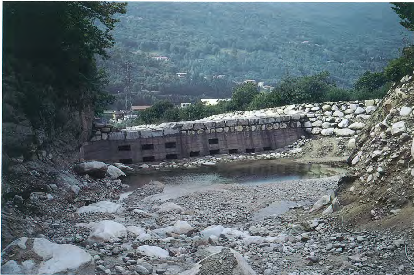
Fig. 15. Omegna, Rio Inferno. Briglia di tipo selettivo con vasca di accumulo (capacità 15.000 m 3 circa), realizzata in apice di conoide (q. 315 m circa).
