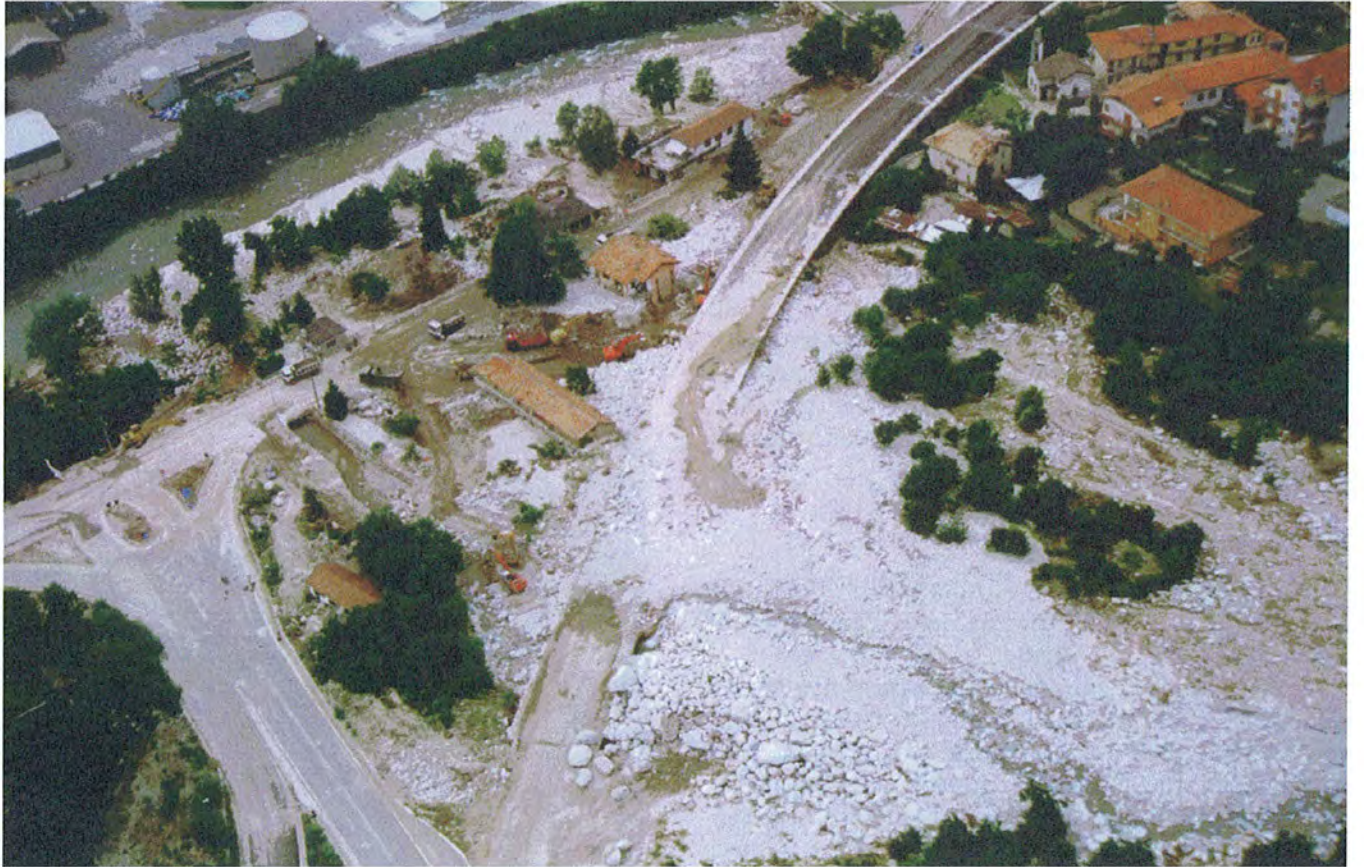
Fig. 9. Omegna, Rio Inferno. Visione aerea del conoide. In alto a destra l'abitato di Brughiere; al centro la circonvallazione di Omegna e gli edifici coinvolti.
