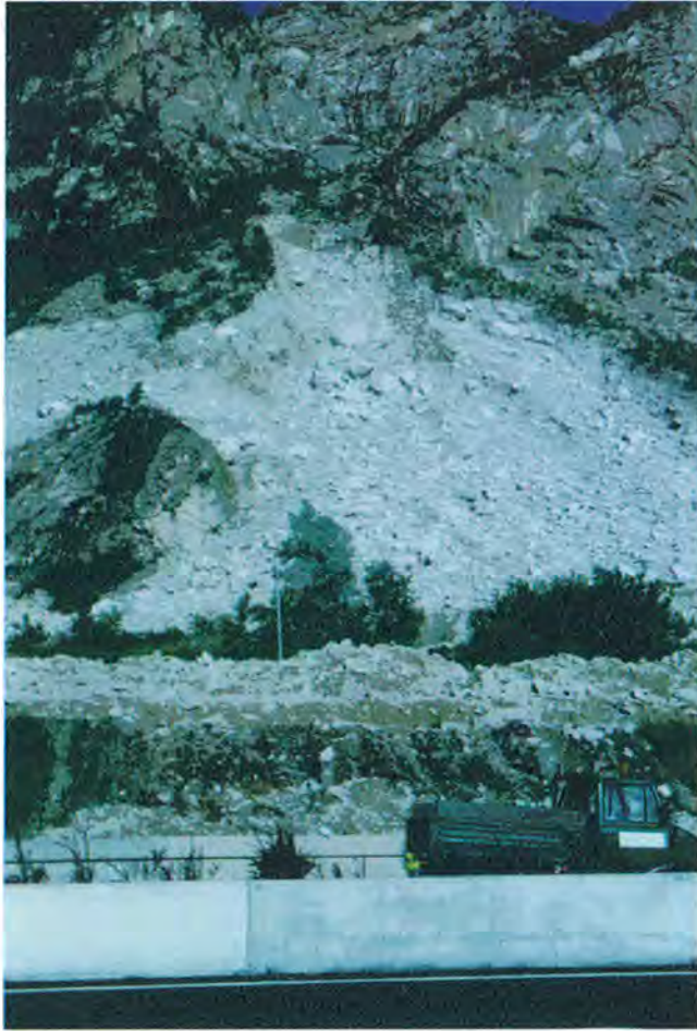
Fig. 3. Baveno, località Cava "Locatelli". Il macereto di blocchi residuo delle attività di coltivazione del secolo scorso è franato parzialmente lasciando un'ampia corona instabile. Il materiale, unitamente ad altri apporti, ha invaso la corsia sud dell'autostrada A26 Voltri-Sempione, causandone l'interruzione temporanea.
