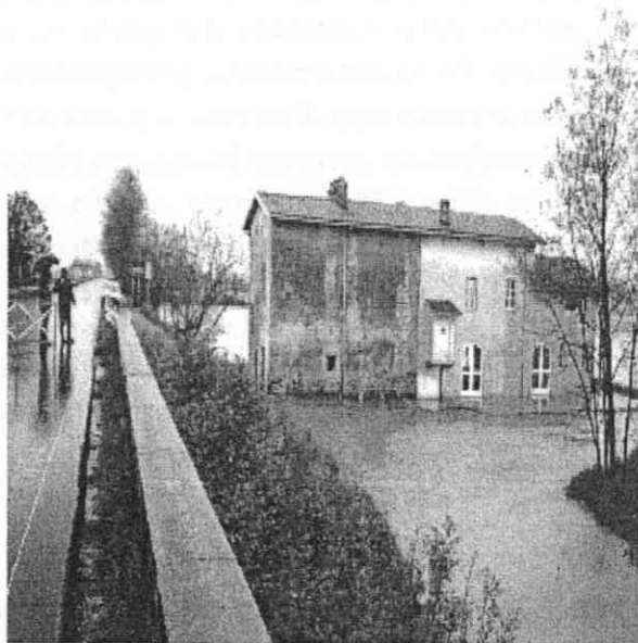
Figura 43: Saluzzo: edificio situato in località Pesci Vivi, adibito in passato a Casa Cantoniera Provinciale, allagato a causa dell'esondazione del fiume Po.
