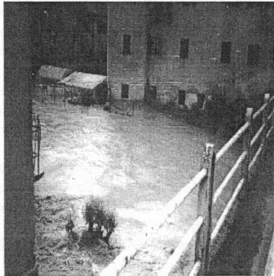
Figura 46: Savigliano: allagato un edificio di civile abitazione in sponda sinistra a monte del ponte di via O. Moreno sul torrente Mellea (ore 18.00 circa del giorno 4).
