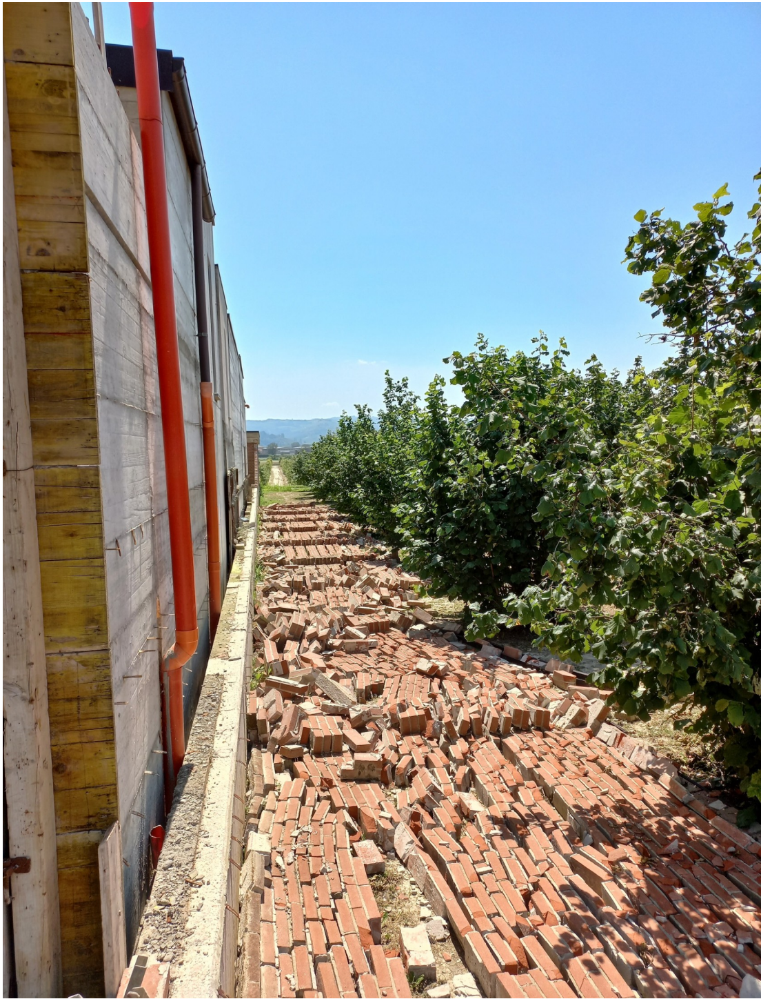
Figura 8. Muro perimetrale del cimitero
