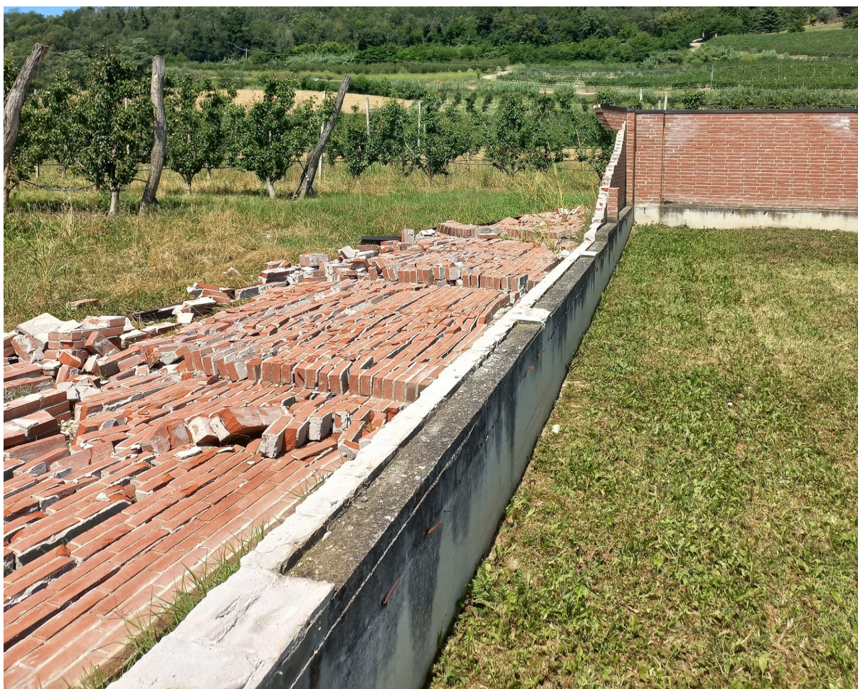
Figura 7. Muro perimetrale del cimitero
