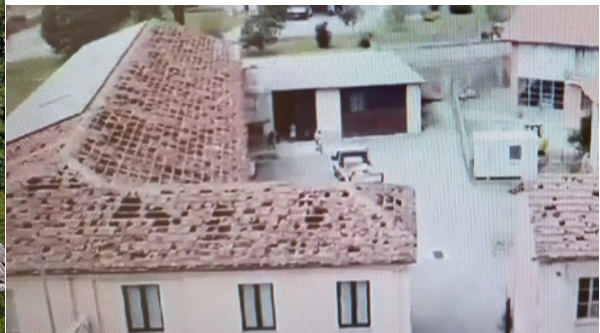
Figura 5. Tetti di alcuni edifici di Cortemilia (CN) completamente distrutti dalla grandine (a sx fonte La voce di Alba, a DS ripresa con drone, tiny.airplane)
