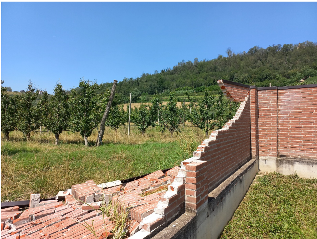
Figura 9. Muro perimetrale del cimitero
