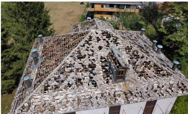
Figura 5. Tetti di alcuni edifici di Cortemilia (CN) completamente distrutti dalla grandine (a sx fonte La voce di Alba, a DS ripresa con drone, tiny.airplane)
