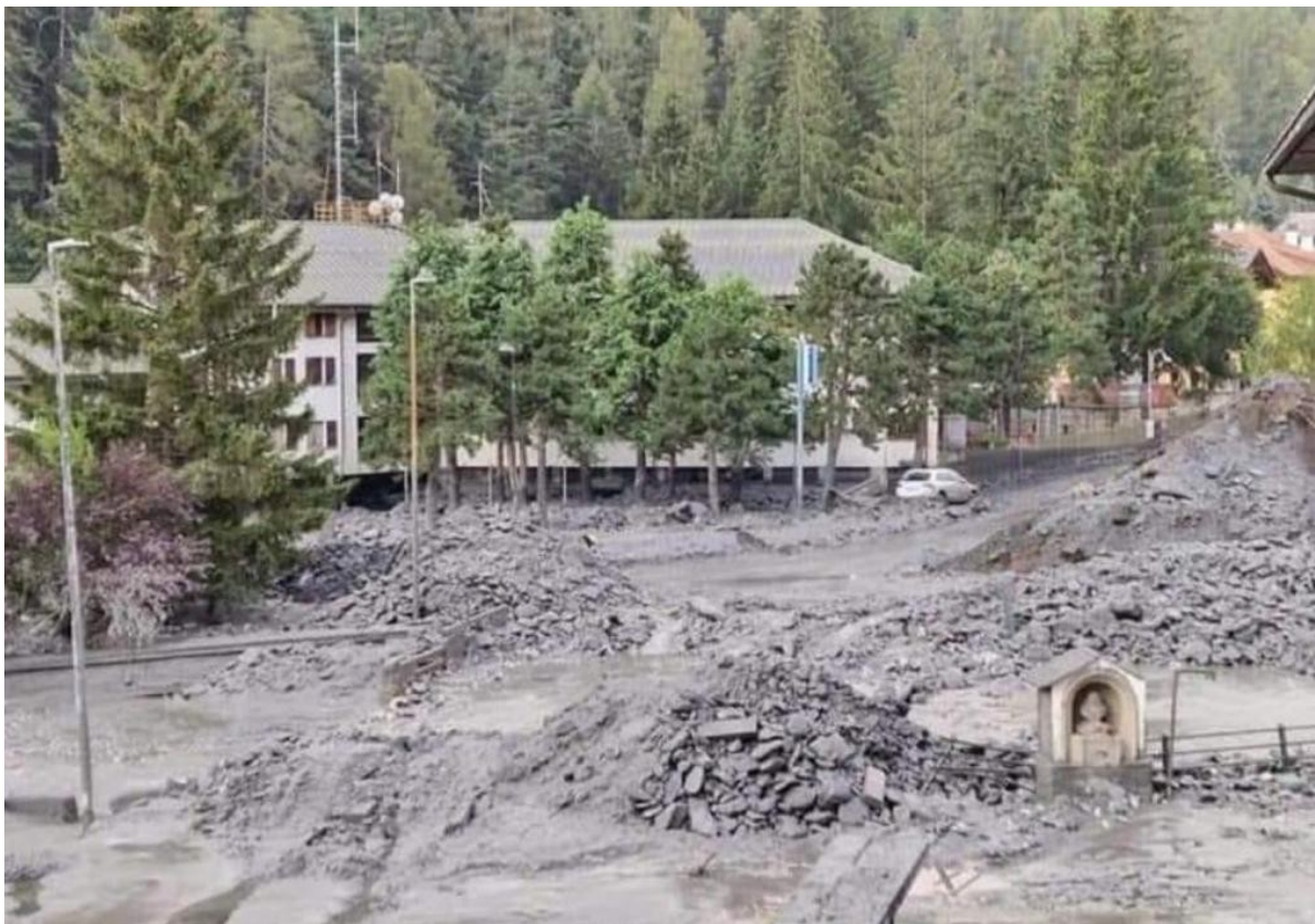
Pilone votivo di Santa Barbara prima e dopo la colata detritica. (in alto immagine presa da Google Earth, in basso foto concessa dal signor Novellini).
