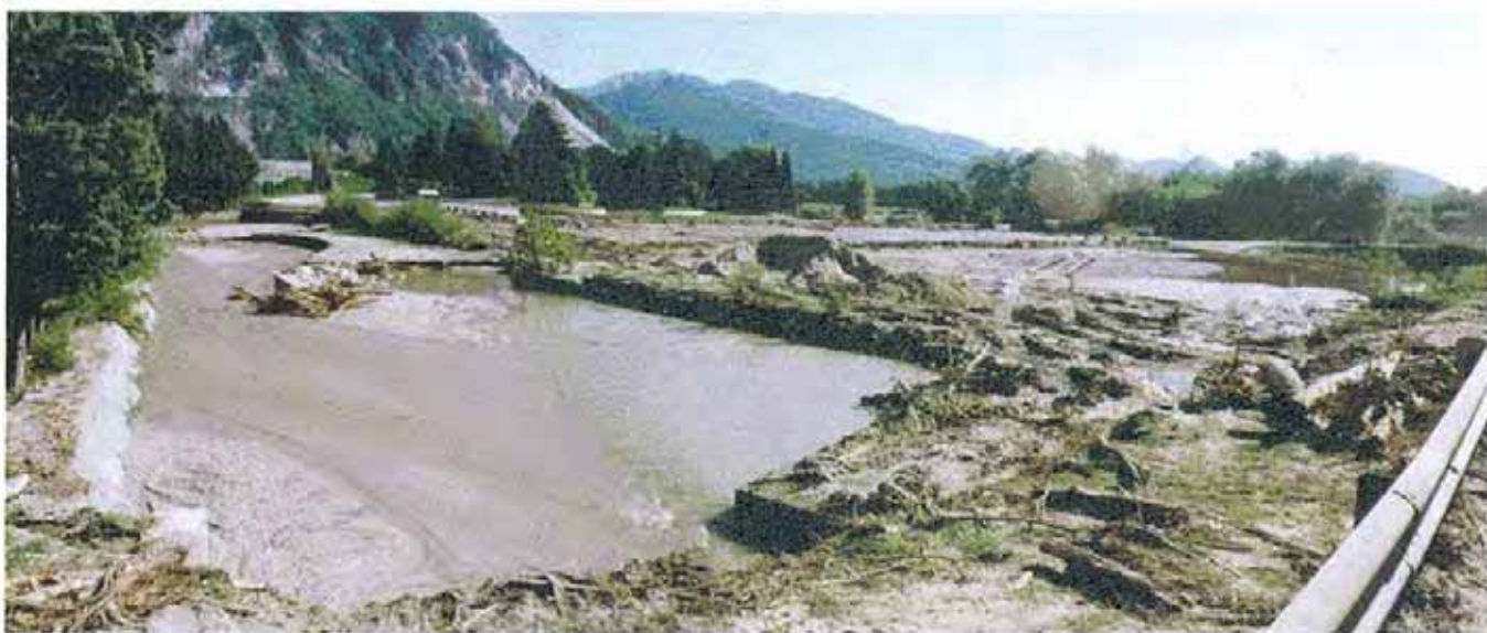
Fig. 4. Gravellona Toce, Ripresa dalla SS n. 33 del Sempione verso la sponda destra del t. Stronetta. In quest'area si sono depositi i materiali fini in sospensione e parte dell'ingente carico vegetale trasportato dal rio Frassino, causando l'interruzione della viabilità e il colmamento della vasca di sedimentazione.
