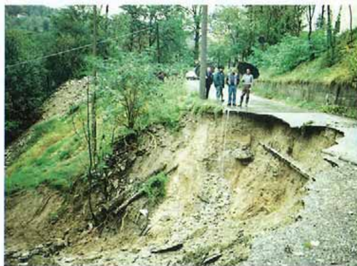
Fig. 14. Boves, Frazione S. Giacomo, Strada per località Buscajè. Frana rotazionale coinvolgente essenzialmente terreni di riporto. Il dissesto ha causato l'asportazione di un tratto di sede stradale e il danneggiamento di una cappella.
