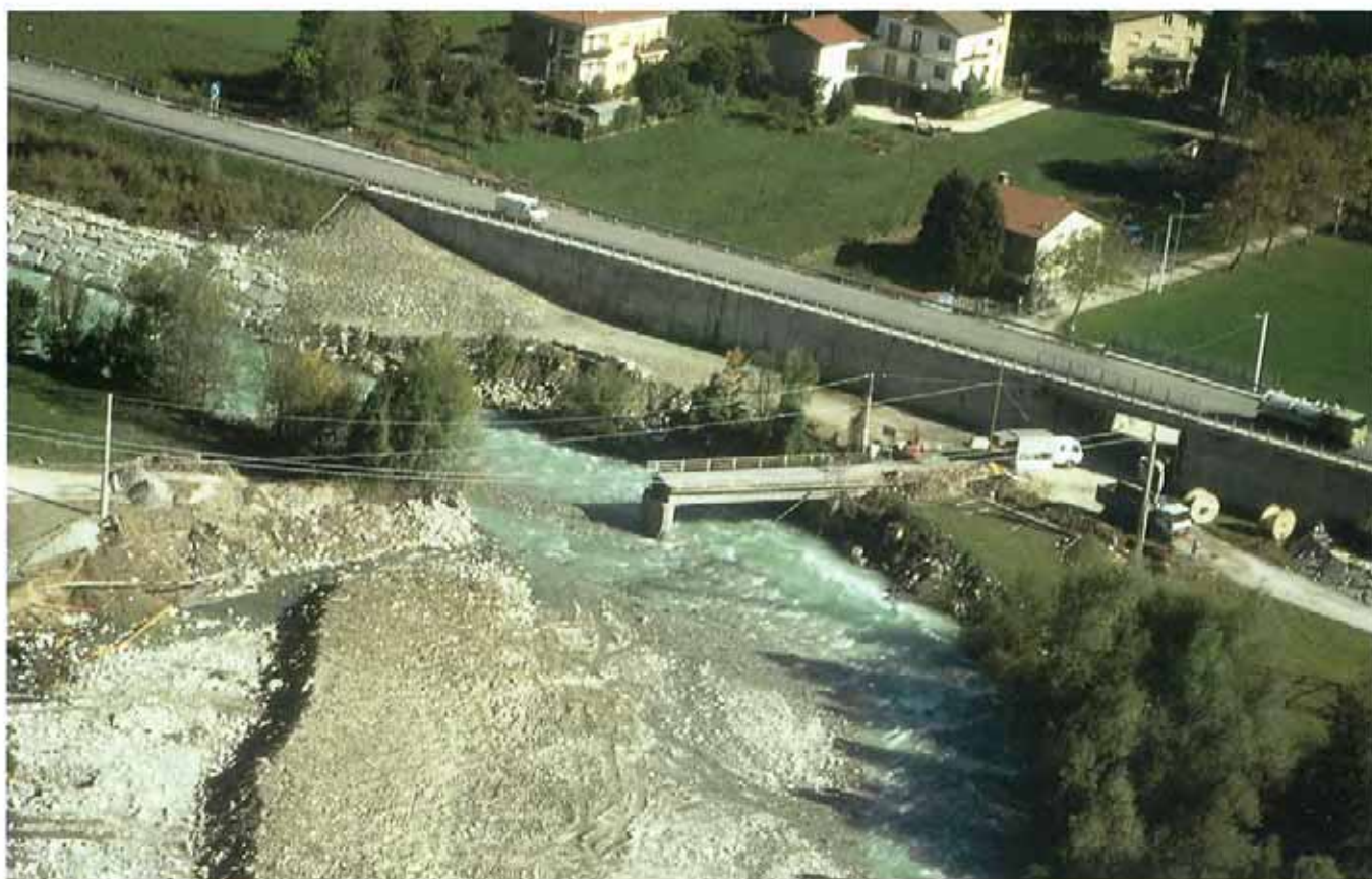
Fig. 9. T. Vermenagna, Robilante concentrico. Ponte per Istituto Climatico crollato a causa della sezione di deflusso insufficiente.
