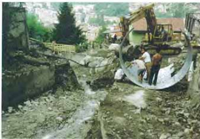
Fig. 12. Omegna, Rio S. Rocco. Lavori di pronto intervento per il ripristino dell'attraversamento distrutto (Via Nobili). Sullo sfondo, passerella provvisoria in legno realizzata dalla Protezione Civile.
