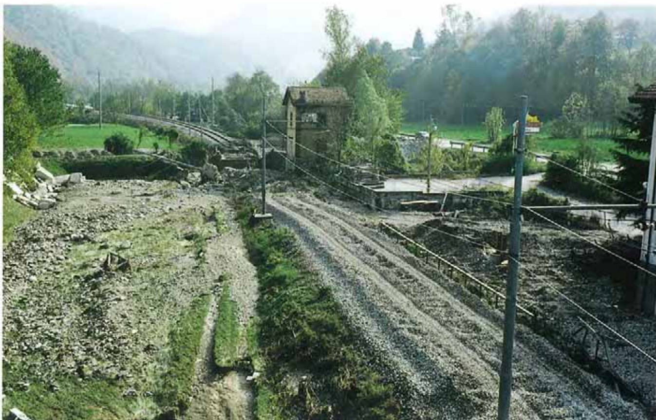
Fig. 7. Comune di Robilante. Vista generale da valle verso monte della linea Cuneo-Nizza, presso il bivio della S.S. n. 20 per Tetto Pettavino, gravemente danneggiata. Il corso d'acqua ha scavato un nuovo canale di deflusso fra ferrovia e S.S., scalzando i binari per un lungo tratto.
