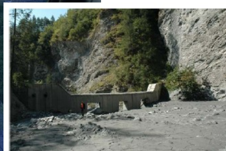
Fig. 14: Vista verso valle della grande briglia fenestrata (quota 1400 m s.l.m. ca.), dopo l'evento dell'agosto 2009.
