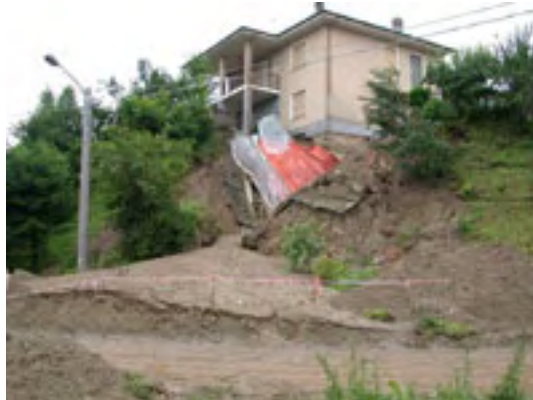
Località Crotte - L'innescò di un earth flow ha causato l'interruzione della provinciale 81 per Strambino e ha parzialmente messo a giorno le fondazioni di un'abitazione
