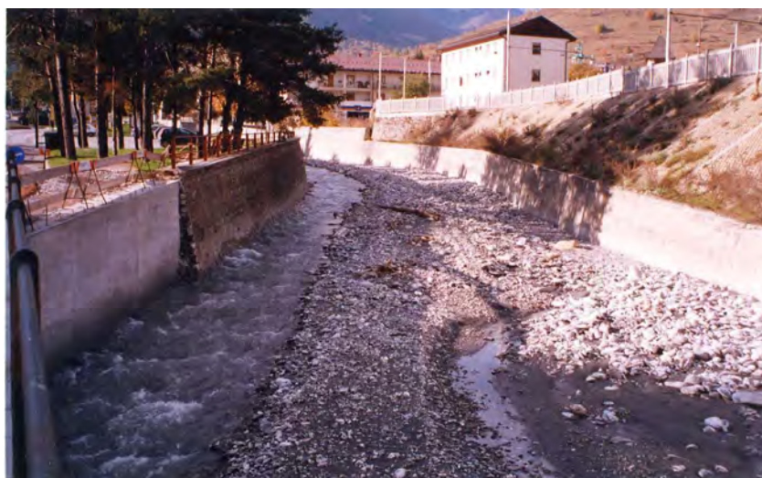
FOTO 70 - Rio Frejus a Bardonecchia: alluvionamento del tratto prossimo alla confluenza nella Dora di Melezet.
