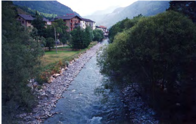
FOTO 17a- Ripa a Cesana T.se ponte S.S. n. 24: vista tratto fluviale a monte dell'attraversamento.
