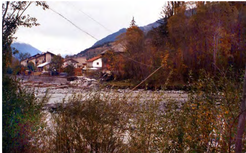
FOTO 54 - Dora Riparia a Oulx: opera di difesa spondale realizzata durante la piena del giugno 2000 e rinforzata successivamente.
