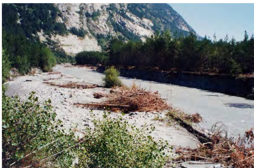
FOTO 38a- Dora Riparia ad Oulx: vista dell'alveo immediatamente a monte della confluenza della Dora di Bardonecchia. Il tratto d'asta presenta una forte erosione di entrambe le sponde.
