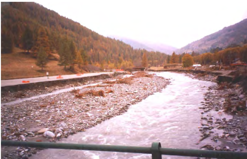
FOTO 120 - Pragalato - Vista T. Chisone a monte del ponte
