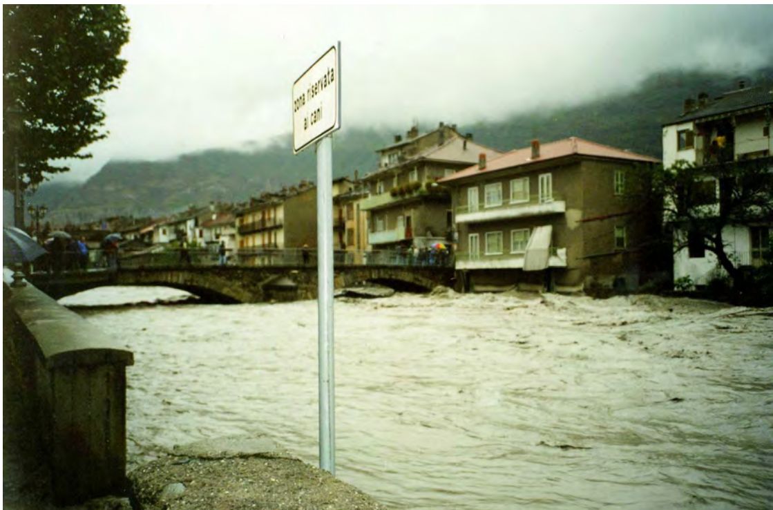
FOTO 25 - Vista da valle del ponte Vecchio sulla Dora Riparia a Bussoleno.
