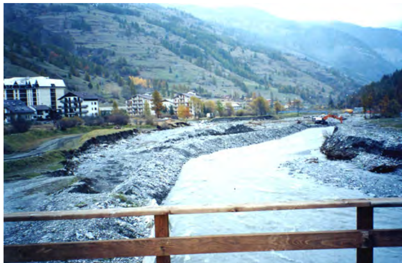
FOTO 124 - Pragalato - Vista T. Chisone a valle del ponte
