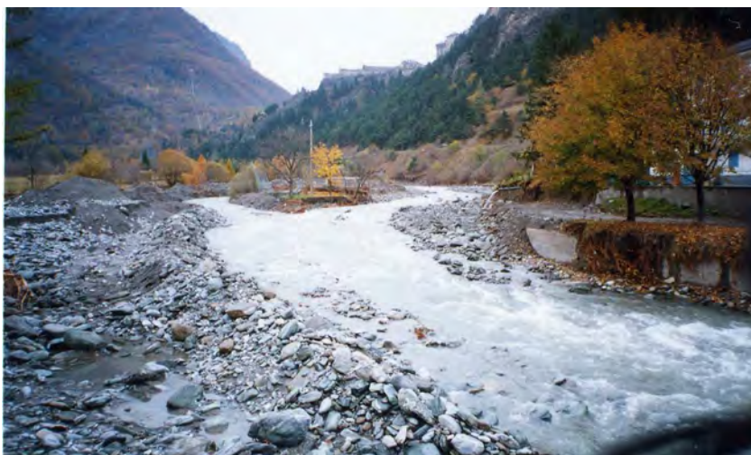
FOTO 21 - T.Chisone in località Chambons (Fenestrelle): tratto d'alveo in erosione a monte del ponte della strada comunale per Depot.
