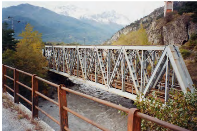
FOTO 68 - Oulx - Ponte ferroviario sulla Dora
