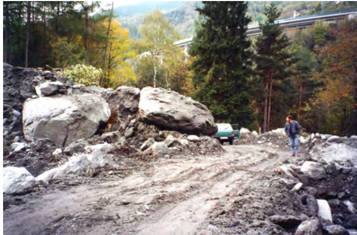
FOTO 59 - Exilles - Rio Combal, particolare attraversamento strada comunale
