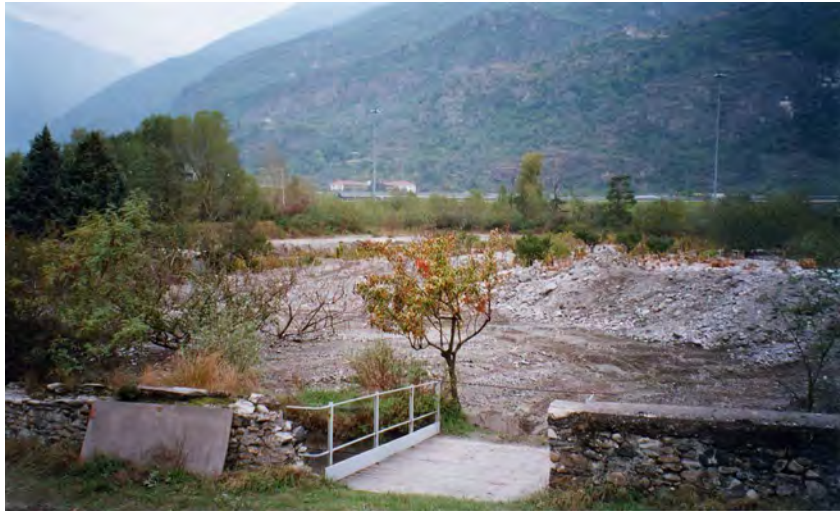
FOTO 21 - Rio Corrente - Sponda sx del Rio a valle SS 24
