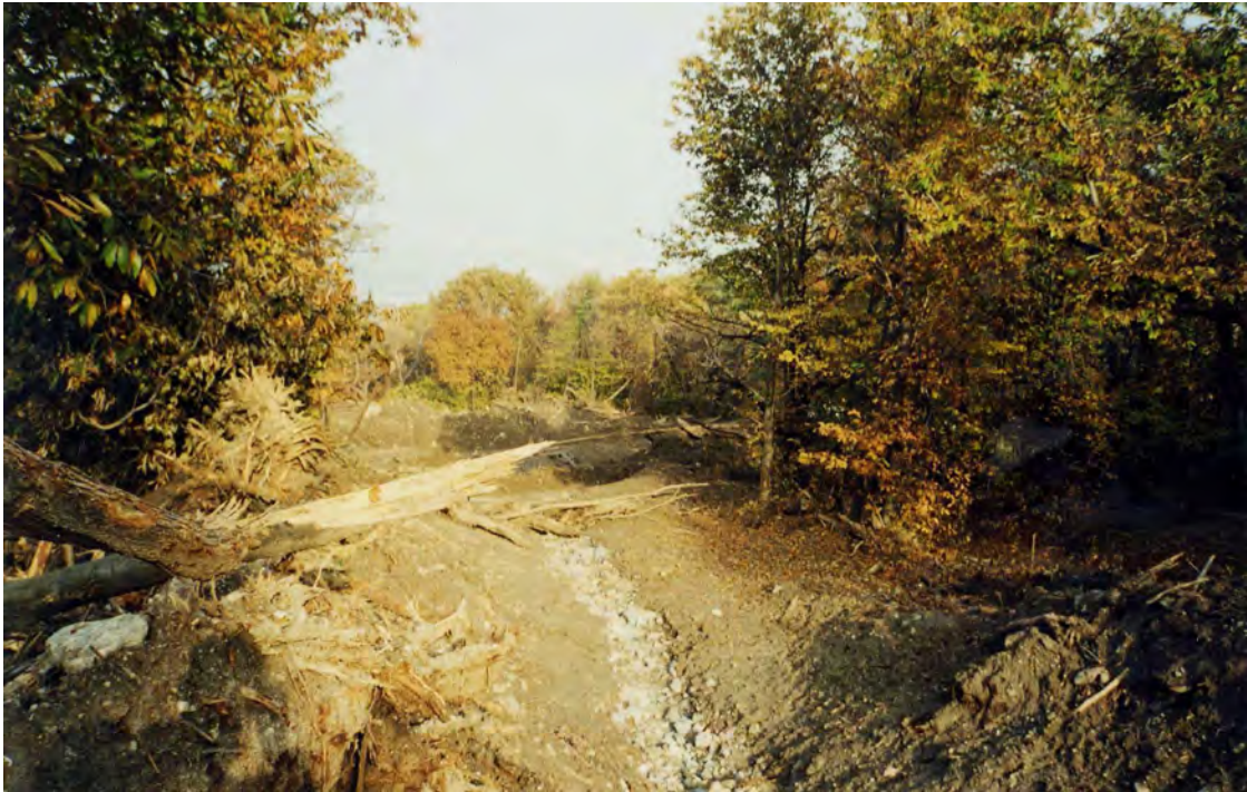
FOTO 22 - Rio Pissaglio a valle di località Baroni, verso valle (Bussoleno).
