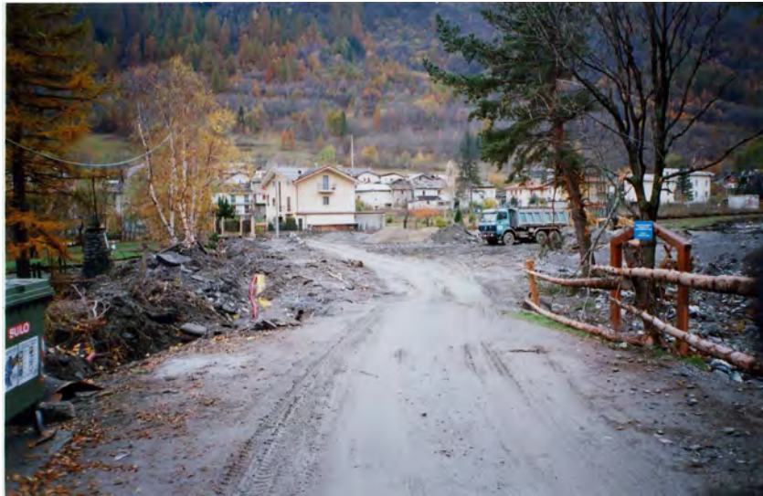
FOTO 23 - T.Chisone in località Chambons (Fenestrelle): aggiramento ponte strada comunale per Depot.
