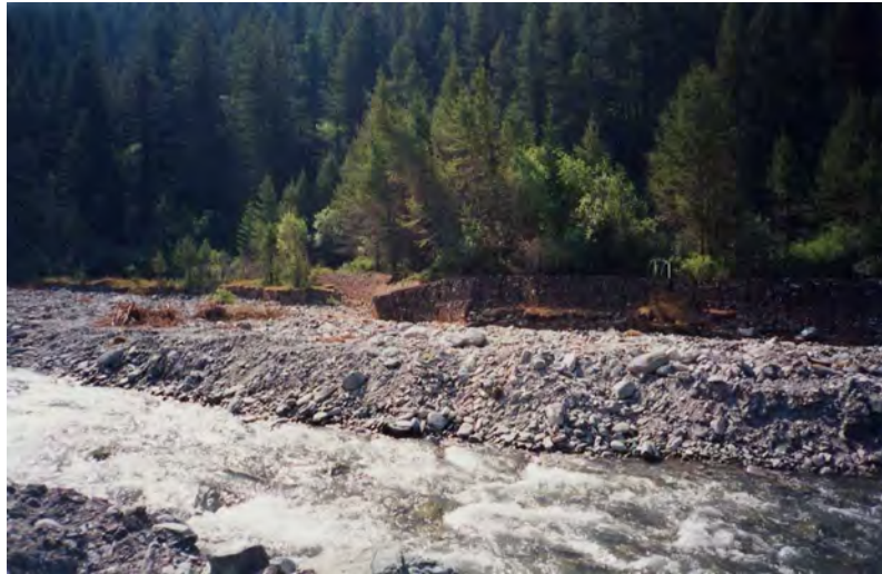
FOTO 5a- Ripa a Rollieres: gabbionata in sponda sinistra a protezione area colonia estiva; parziale cedimento della difesa nel settore di monte.
