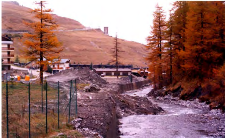
FOTO 107 - Borgata di Sestriere - Deposito T. Chisonetto
