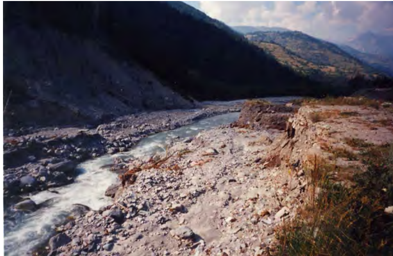
FOTO 23a- Dora Riparia presso Mollieres: tratto d'asta a sezione ristretta soggetta a marcata erosione spondale.
