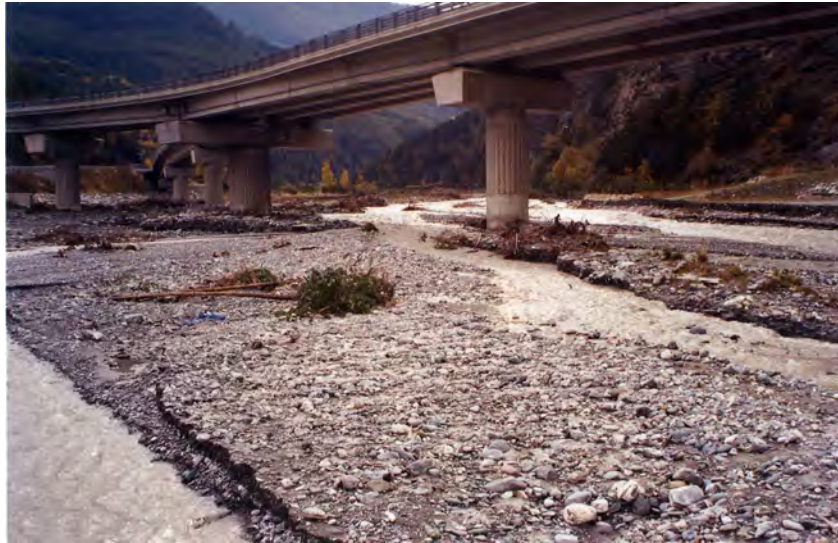
FOTO 53 - Dora Riparia al viadotto della superstrada per Cesana (Oulx): vista asta fluviale (verso monte).
