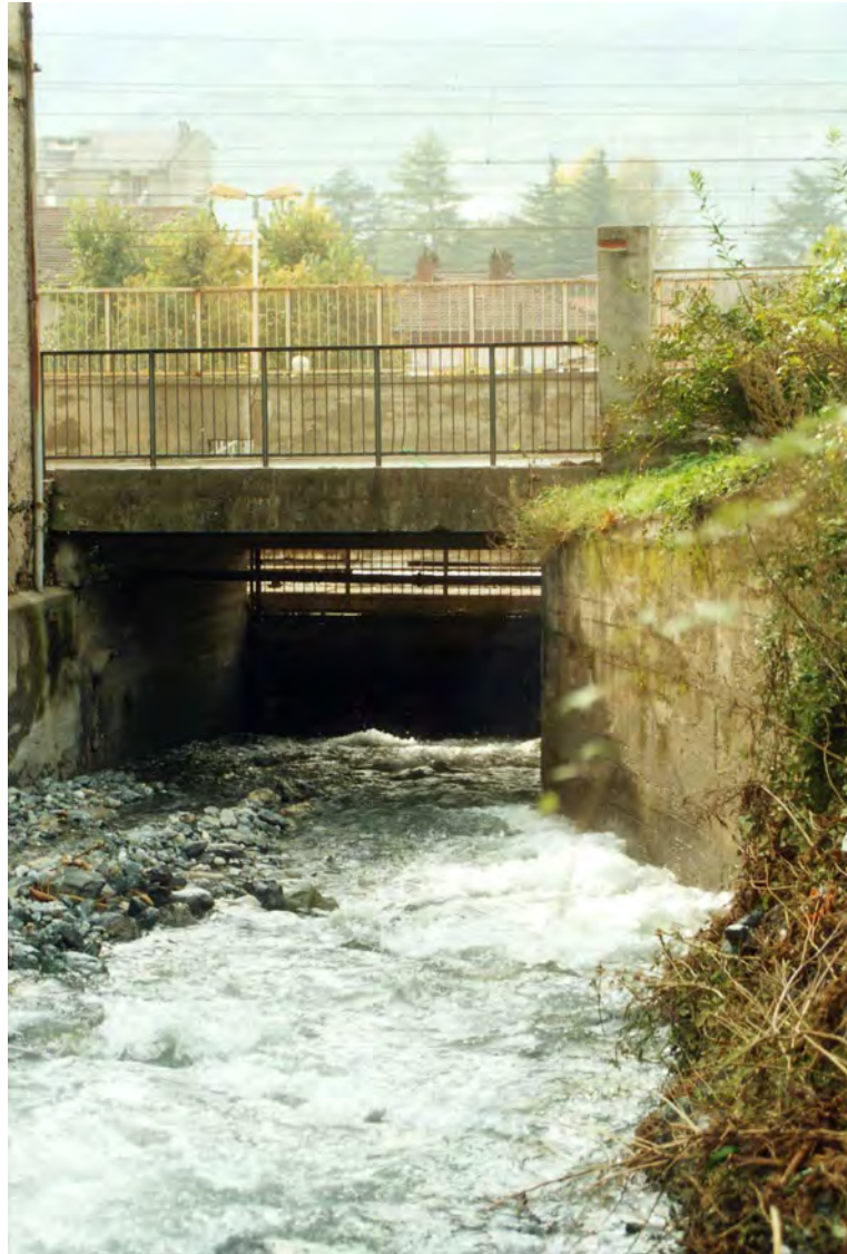
FOTO 31 - Sezione di imbocco del manufatto di attraversamento della ferrovia Susa-Bussoleno, sul T.Moletta presso la stazione di Bussoleno.
