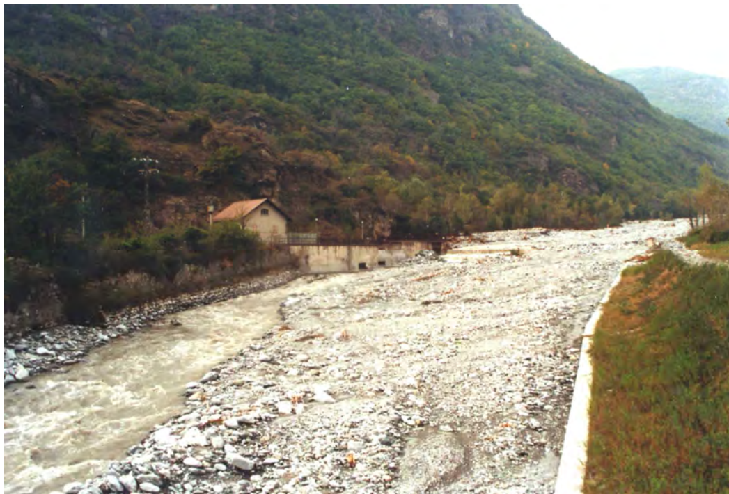
FOTO 7 - Tratto sovralluvionato del T.Cenischia, a monte del ponte della S.P. Venaus-Novalesa.
