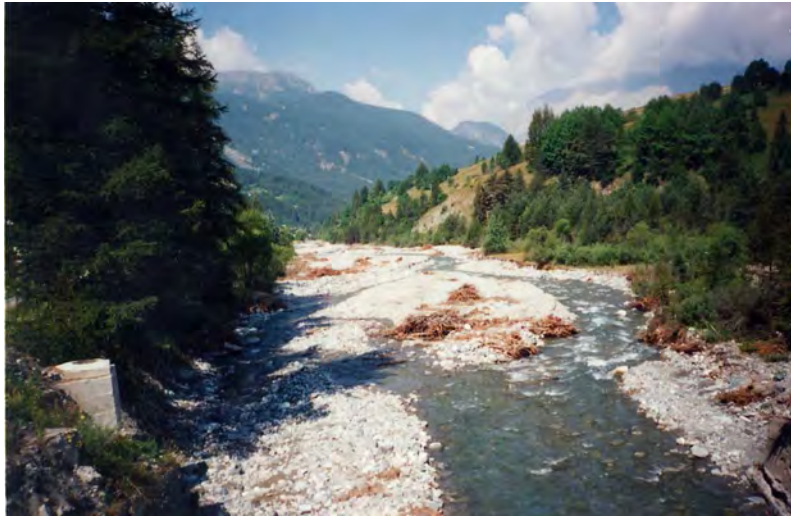
FOTO 9a- Ripa a Rollieres, località ponte Blaize: vista tratto d'asta alluvionato a valle dell'attraversamento.
