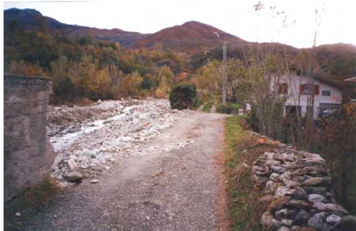
FOTO 1002 -Rio Pissaglio presso Località Roncaglie: breccia in muro argine in sponda sinistra preesistente all'evento del 16-17 ottobre.
