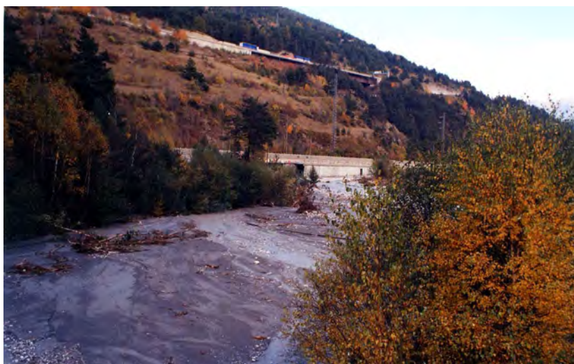
FOTO 67 - Dora di Bardonecchia - ponte strada bianca per Beulard a valle di Royeres: aggiramento opera di attraversamento; vista del canale abbandonato (verso valle).
