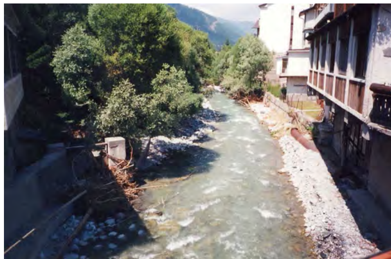
FOTO 16a- Ripa a Cesana T.se, ponte nel centro abitato: vista a valle dell'attraversamento.
