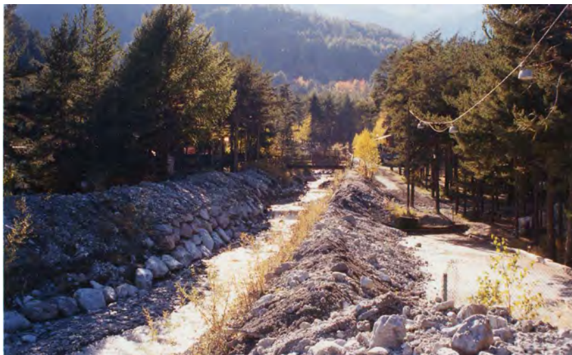
FOTO 62 - Rio Champeiron a Beaulard: tratto d'asta incanalato tra argini presso area campeggio.
