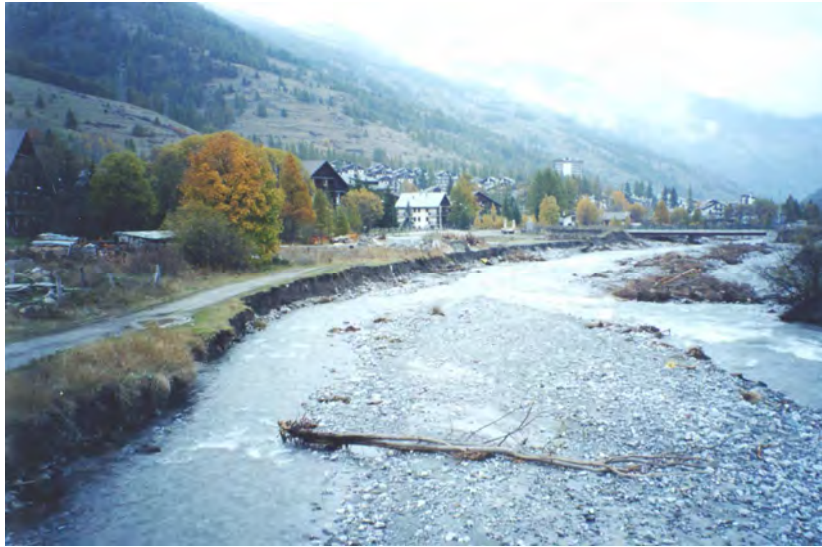
FOTO 119 - Pragalato - Vista T. Chisone a valle del ponte
