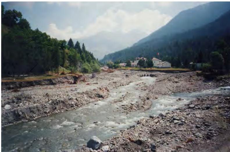
FOTO 10a- Ripa a Bousson, confluenza T.Thuras: marcata erosione spondale; in sponda destra forte arretramento della sponda e distruzione area turistica attrezzata.
