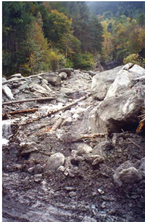
FOTO 60 - Exilles - Rio Combal, vista verso monte da attraversamento strada comunale
