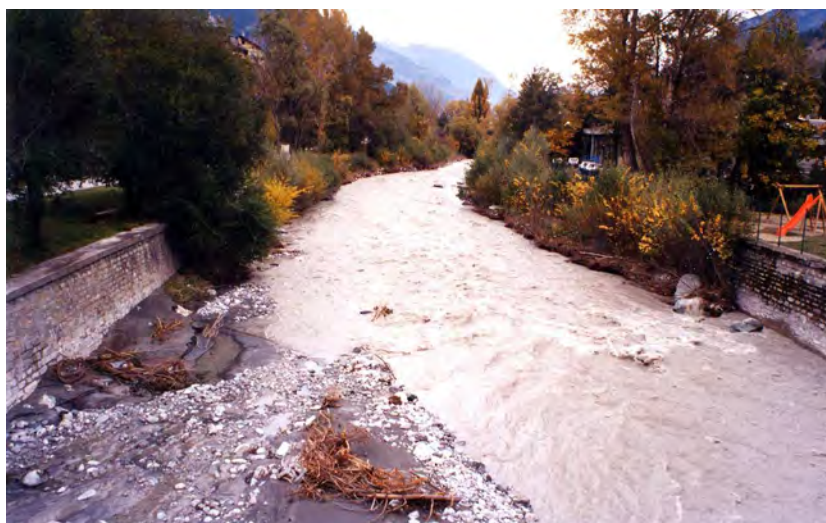
FOTO 56 - Dora Riparia a Oulx: asta fluviale a valle del ponte a monte dell'abitato.
