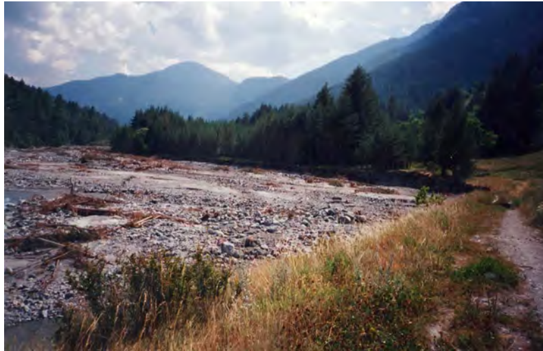
FOTO 21a - Dora Riparia nei pressi di Fenils: ampia erosione in sponda sinistra; asportato tratto strada bianca.
