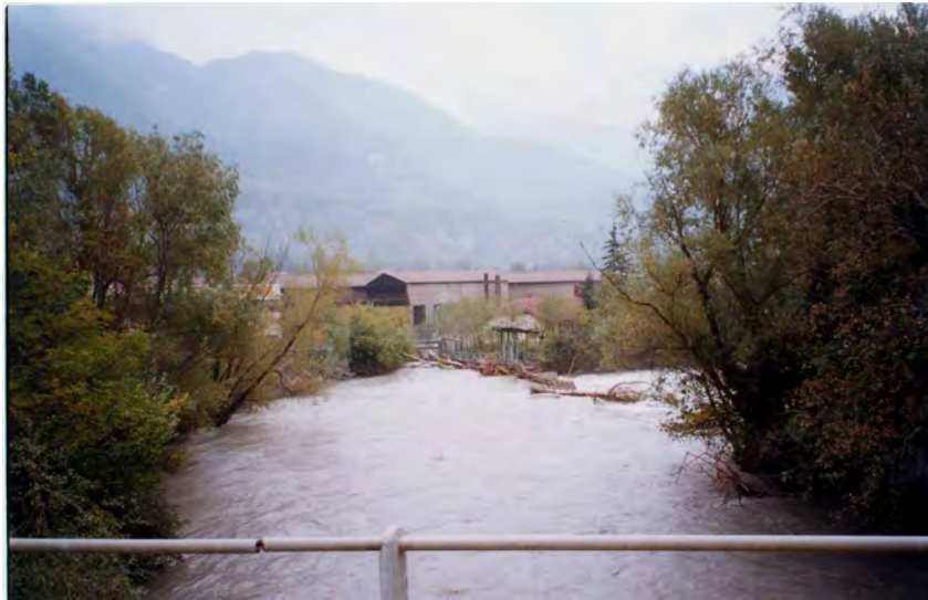
FOTO 10 - Bussoleno - ponte a monte dell'abitato, lato verso valle (traversa)
