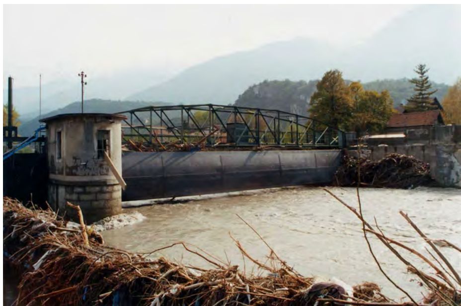
FOTO 9 - L'alveo del T.Cenischia, a Susa, a monte dell'attraversamento della S.S. 25.
