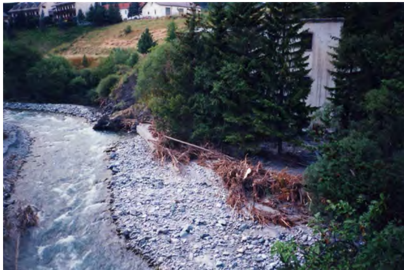
FOTO 18a- Dora Riapria a Cesana presso cappella N.D. del Rosario: alluvionamento edificio in sponda sinistra.
