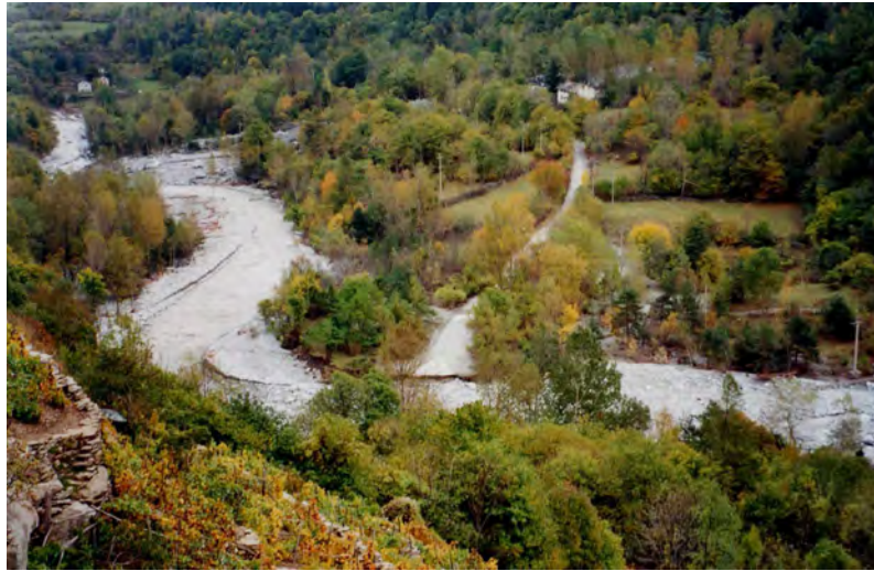
FOTO 49 - Exilles - ponte sulla Dora crollato, a valle del capoluogo
