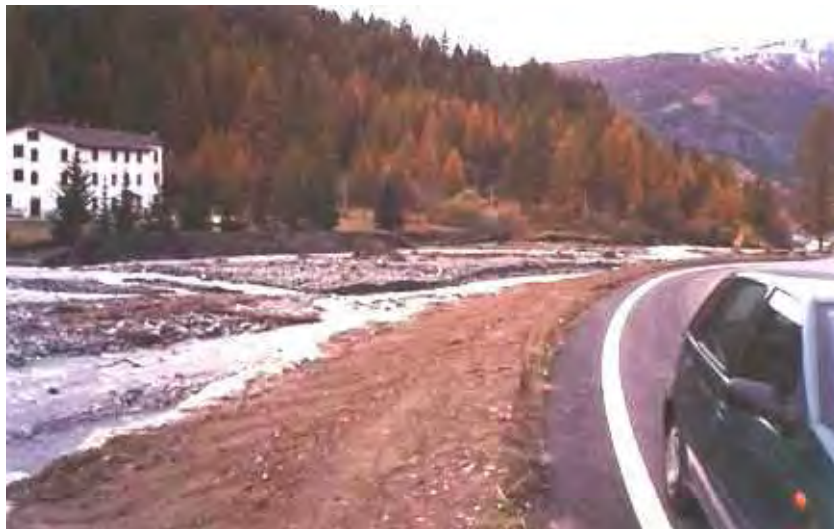
FOTO 32 - T.Ripa presso località Rollieres (Sauze di Cesana): tratto di gabbionata in sinistra idrografica distrutto (brecciatura dell'opera già iniziata con la piena del giugno 2000).
