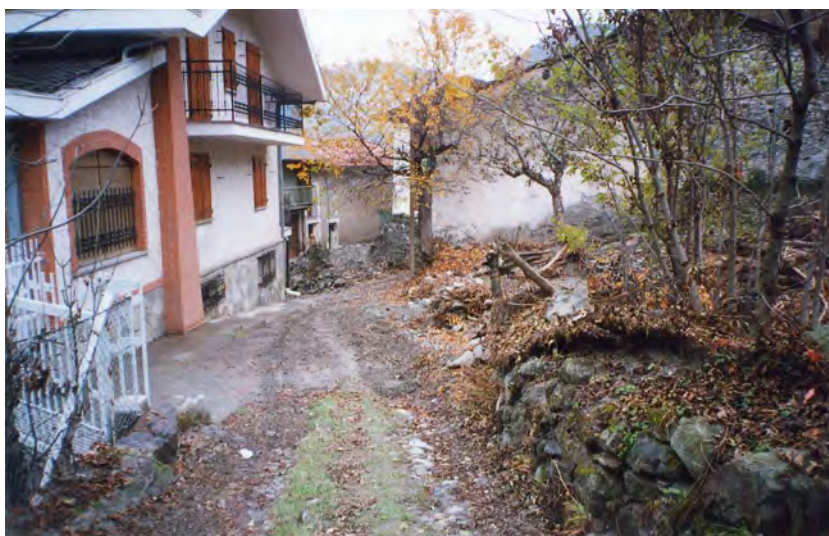
FOTO 27 - Località Granges (Fenestrelle): alluvionamento dell'abitato per attivazione della conoide del rio Corbiera.
