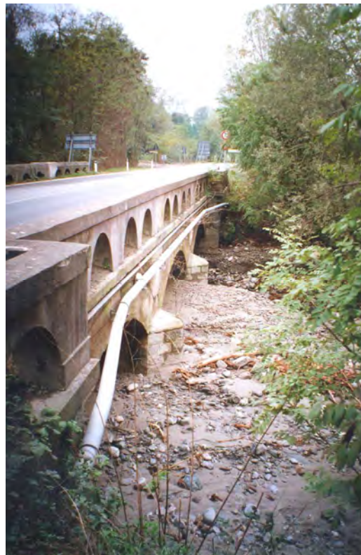
FOTO 1 - Rio Pissaglio - Vista lato valle ponte SS 24
