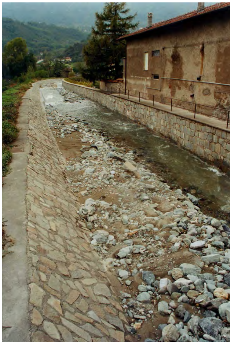
FOTO 17 - Depositi nel tratto canalizzato, pensile, del T.Gendola a valle della S.S. 25 (Susa).
