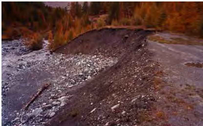
FOTO 36 - T.Ripa presso Pont Terrible (Sauze di Cesana): erosione spondale in destra, a valle dell'attraversamento.
