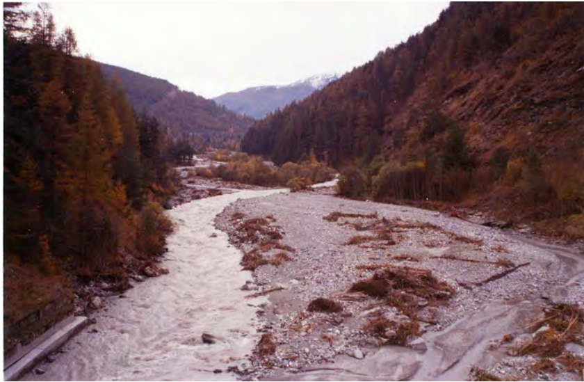
FOTO 51 - Dora Riparia al ponte della strada per località Desertes (Cesana): vista a monte dell'attraversamento.
