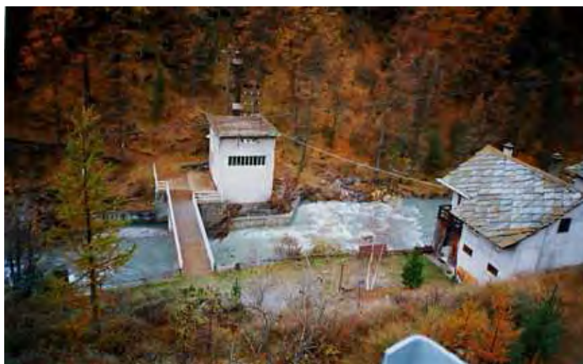
FOTO 7 - T.Chisone in località Mulino Gorgia (Usseaux): impianto di sollevamento SKF in sponda destra.
