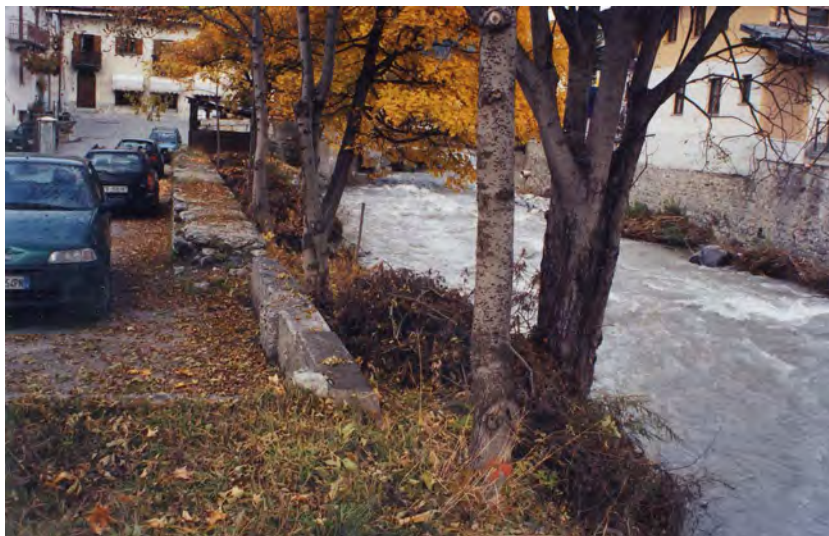
FOTO 42 - T.Ripa a Cesana: vista del tratto fluviale e dell'area in sponda destra a franco minimo.
