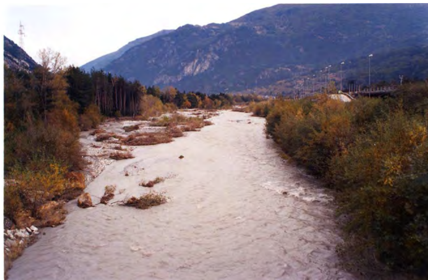
FOTO 58 - Dora di Bardonecchia ad Oulx - ponte stradale da Oulx a loc. Beaume: vista tratto d'alveo a valle dell'attraversamento.
