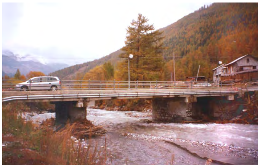
FOTO 126 - Prigelato - Vista del ponte sul T. Chisone da valle
