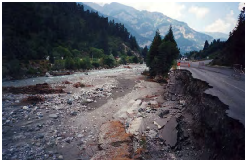
FOTO 12a- Ripa a monte di Cesana presso campeggio: tratto fluviale a marcata erosione di sponda; in destra distruzione per scalzo al piede tratto di muro a difesa strada provinciale. In sponda sinistra vista argine a protezione campeggio.
