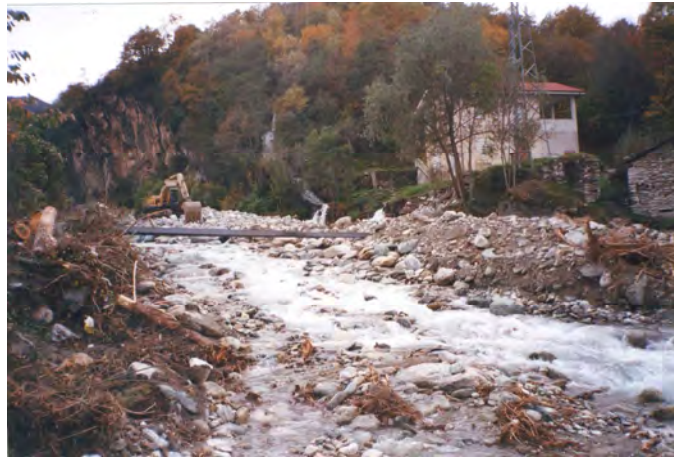
FOTO 1001 -Rio Gerardo presso Località Comba: tratto asta con forte erosione spondale.
