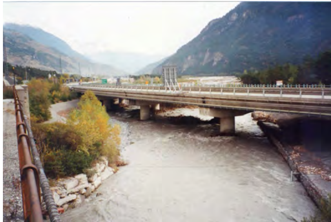
FOTO 69 - Oulx - Viadotto autostradale sulla Dora
