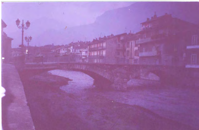
FOTO 3 - Bussoleno - Ponte in centro sulla Dora Riaparia visto da valle
