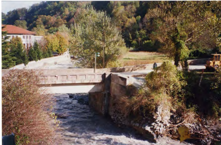
FOTO 44 - Chiomonte - Ponte sulla Dora SP per frazione Ramat da monte sponda sx
