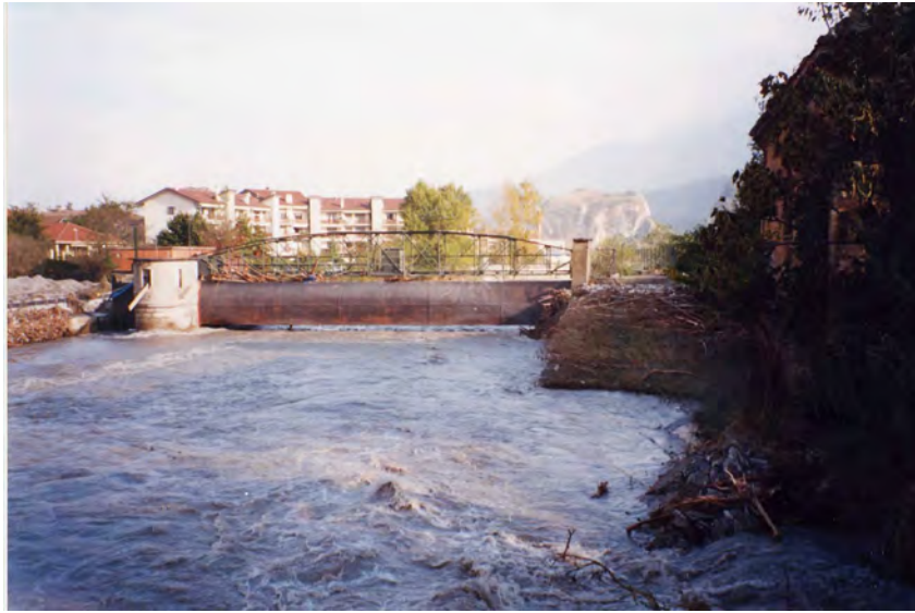
FOTO 34 - Susa - Traversa a valle del ponte degli Alpini
