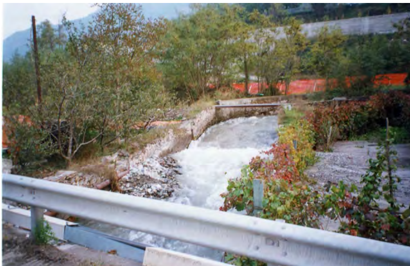
FOTO 20 - Rio Corrente - Vista verso monte ponte SS 24
