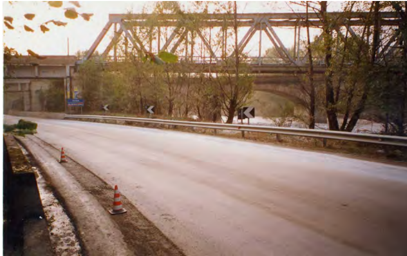
FOTO 17 - Viadotto FFSS sulla Dora Riparia a monte di Bussoleno
