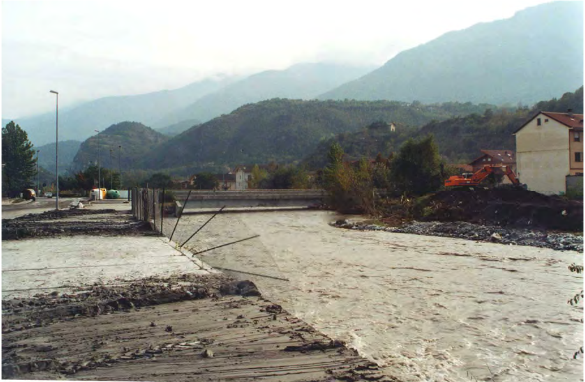
FOTO 12 - Particolare della traversa di derivazione, in sponda sinistra della Dora Riparia a Susa.
