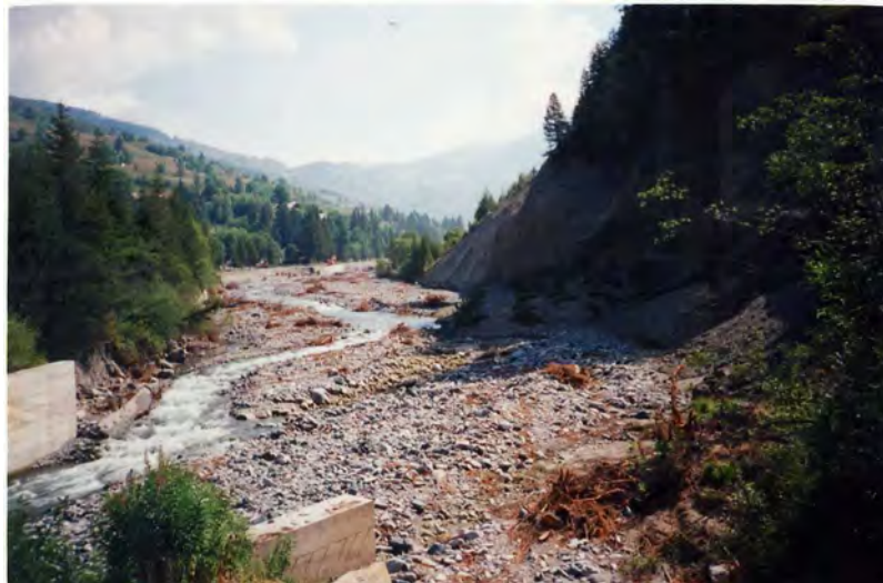
FOTO 8a- Ripa a Rollieres, località ponte Blaize: vista tratto d'asta alluvionato a monte dell'attraversamento.
