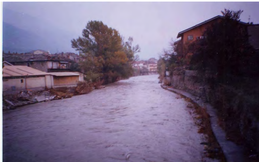
FOTO 5 - Bussoleno - Ponte in ferro sulla Dora Riparia, vista verso valle
