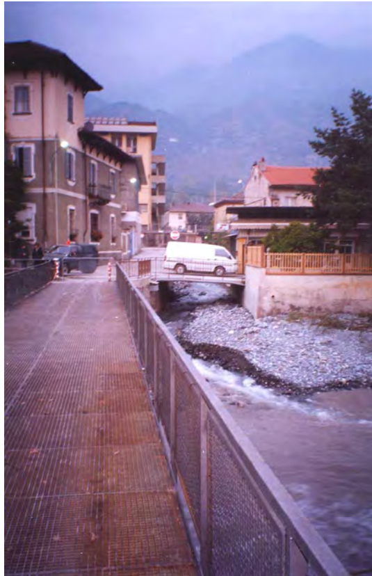
FOTO 5 bis - Bussoleno - Ponte in ferro sulla Dora Riparia, vista foce Moletta in sponda dx
