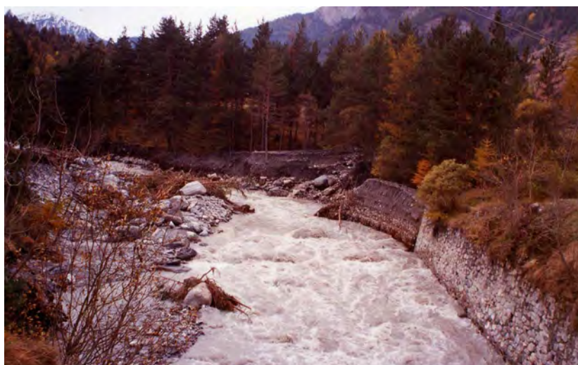
FOTO 48 - Dora Riparia presso Fenils (Cesana): alluvionamento della confluenza del Rio Fenils.
