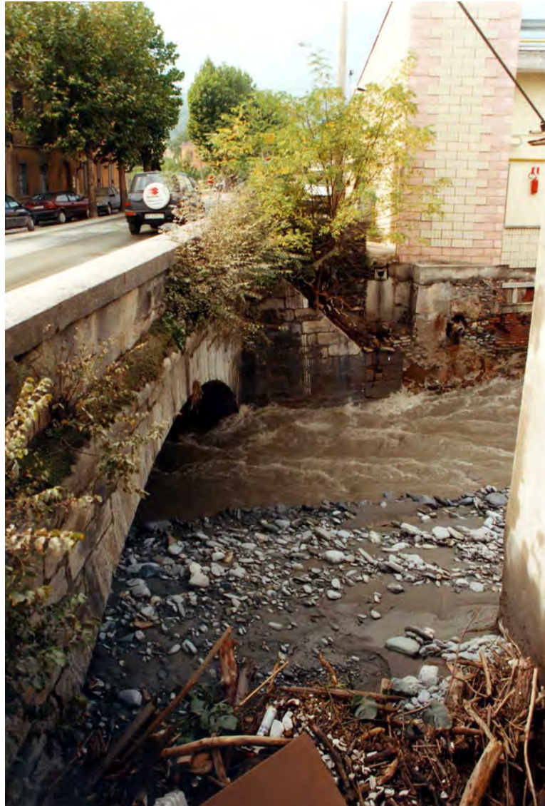
FOTO 14 - Particolare del ponte sul T.Cenischia lungo la S.S. 25 a Susa (da monte, sponda sx.).
