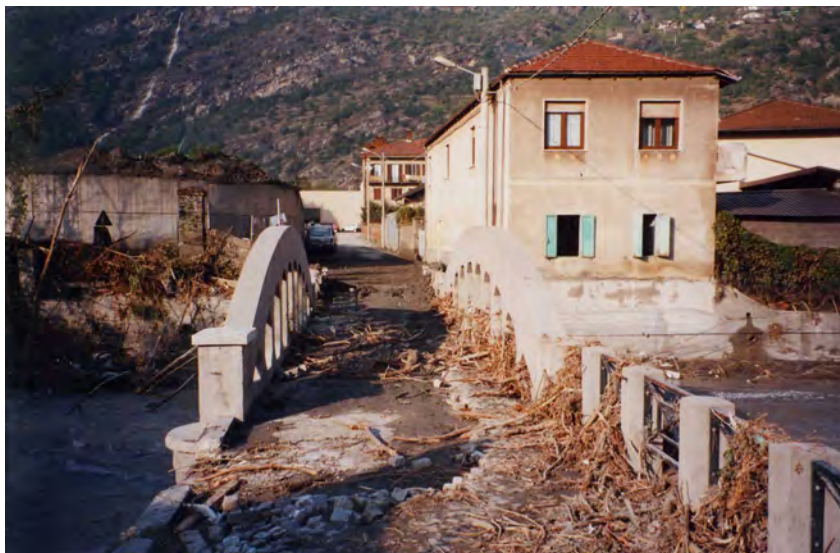
FOTO 31 - Susa - Ponte Alpini sulla Dora dalla sponda dx
