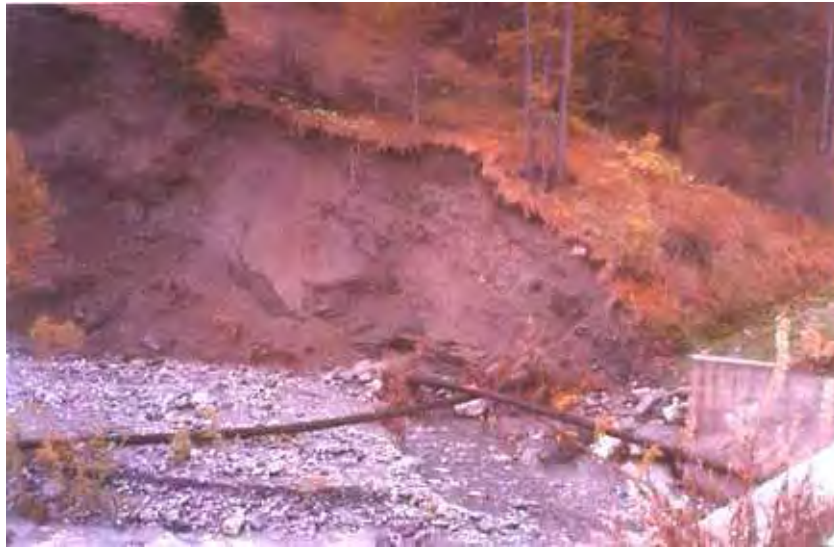
FOTO 31 - T.Ripa a ponte Blaize (Sauze di Cesana): erosione spondale e frana immediatamente a contatto con la spalla sinistra dell'attraversamento (lato a monte).
