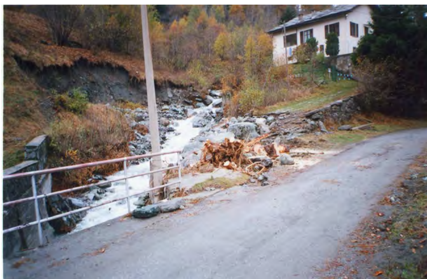
FOTO 19 - Fenestrelle: erosione spondale lungo il Rio di Cristove (affluente in destra) presso centrale SKF.
