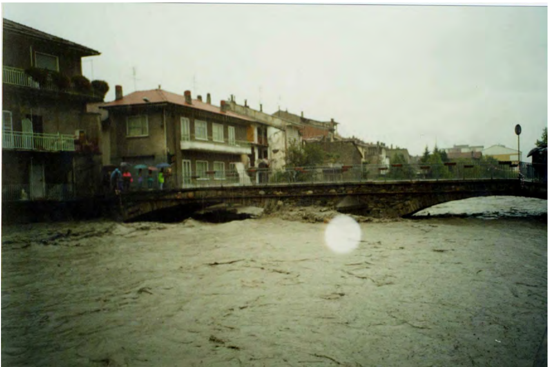
FOTO 27 - Vista del ponte Vecchio sulla Dora Riparia a Bussoleno (da monte).
