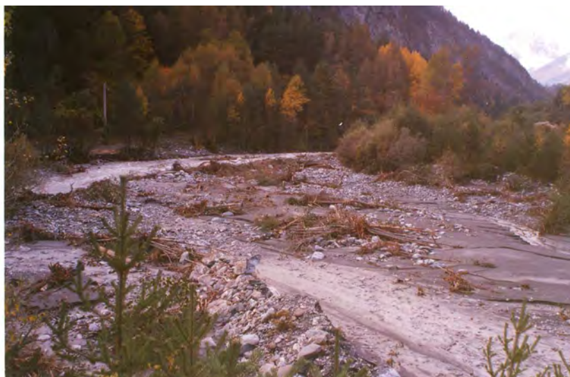
FOTO 68 - Dora di Bardonecchia - ponte strada bianca per Beulard a valle di Royeres: aggiramento opera di attraversamento; vista del canale abbandonato (verso monte).
