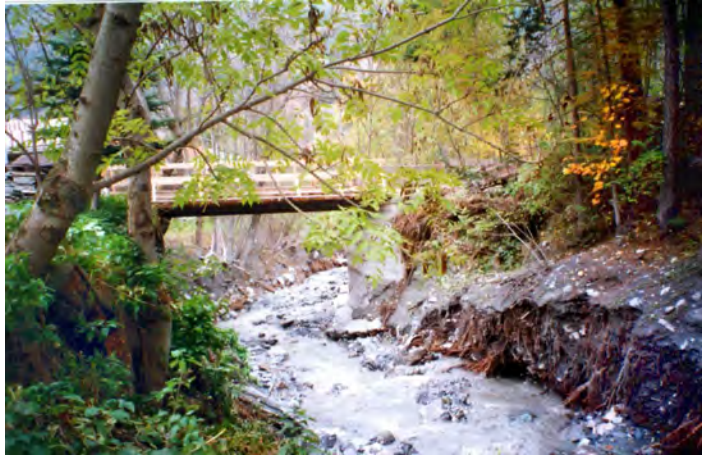
FOTO 93 - Rio Fenils - Ponte comunale nell'abitato di Fenils, visto da monte
