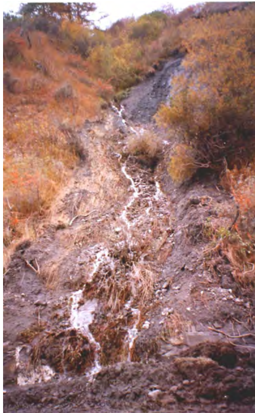
FOTO 128 - Pragalato - Vista Rio Grand Puy sulla SS 23
