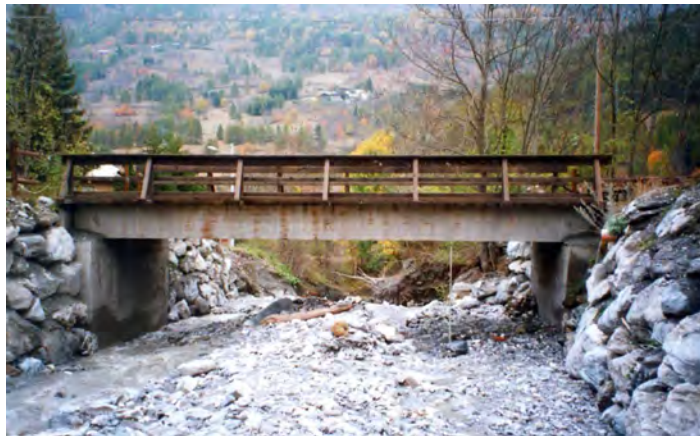
FOTO 90 - Rio Fenils - Ponte per frazione Vernin. Visto da monte
