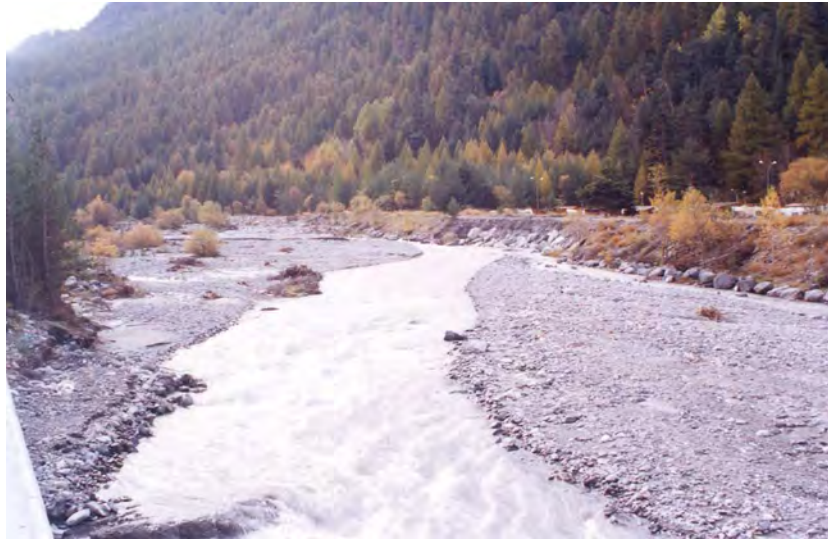
FOTO 41 - T.Ripa a Cesana: argine a protezione del campeggio (l'opera è stata rialzata dopo l'evento del giugno 2000).
