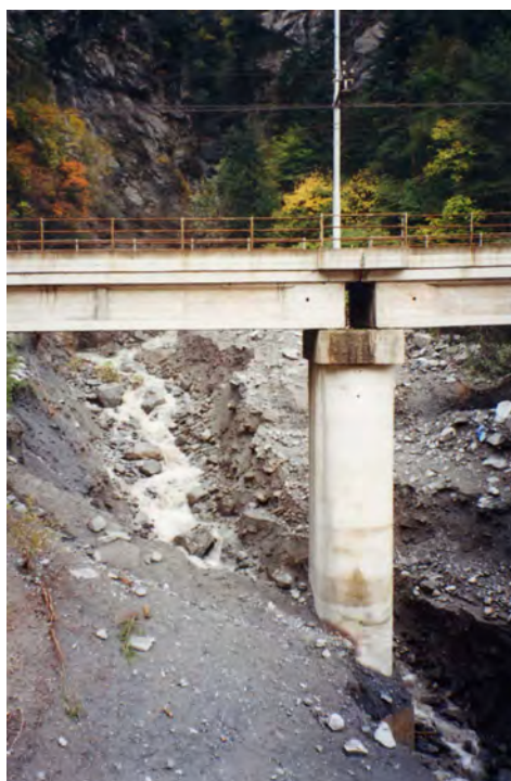
FOTO 54 - Exilles - pila di monte del viadotto FS sul Rivo Comba Bosco
