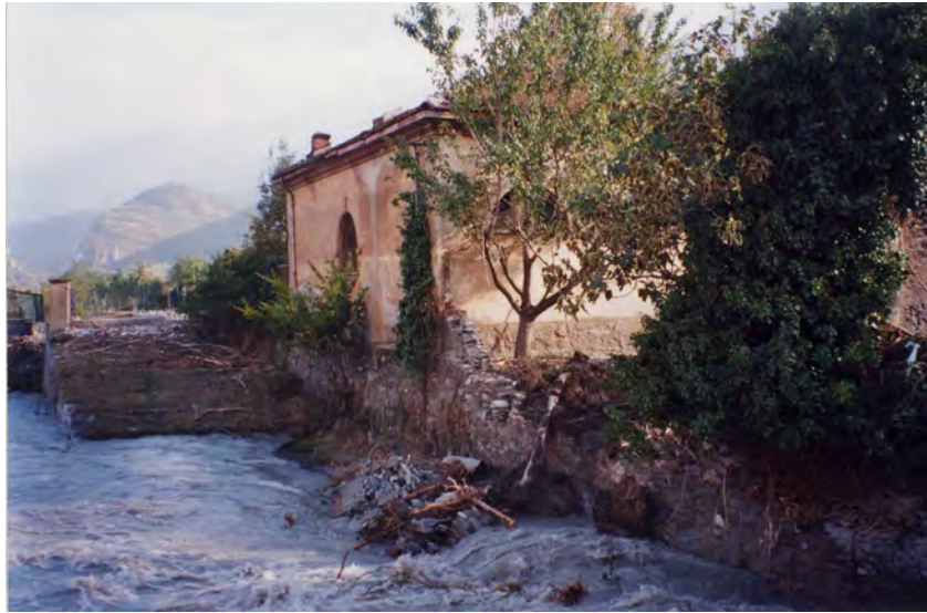
FOTO 32 - Susa - Sponda dx della Dora a valle del ponte degli Alpini
