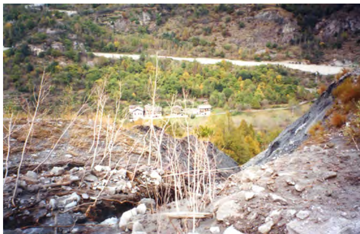
FOTO 58 - Exilles - Rio Combal, vista verso valle da attraversamento strada comunale
