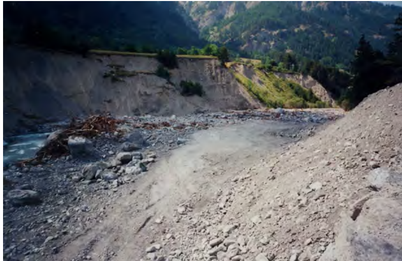
FOTO 19a - Dora Riparia a Cesana T.sea- confluenza Rio del Gran Vallone: vista a valle confluenza. In sponda sinistra lunga fascia soggetta a franamenti.
