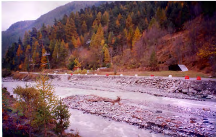
FOTO 101 - Cesana Torinese - Strada comunale per campeggio (in sponda sx T.Ripa) erosa
