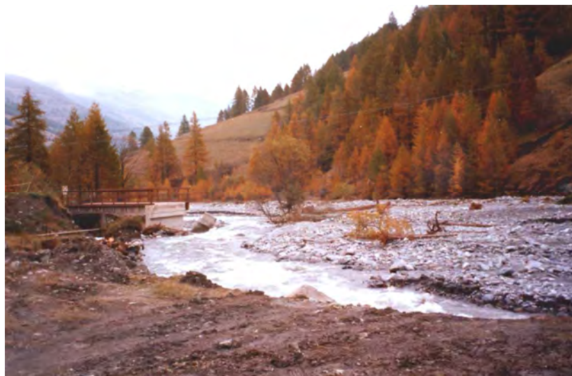
FOTO 114 - Pragelato - Ponte distrutto sul T. Troncea
