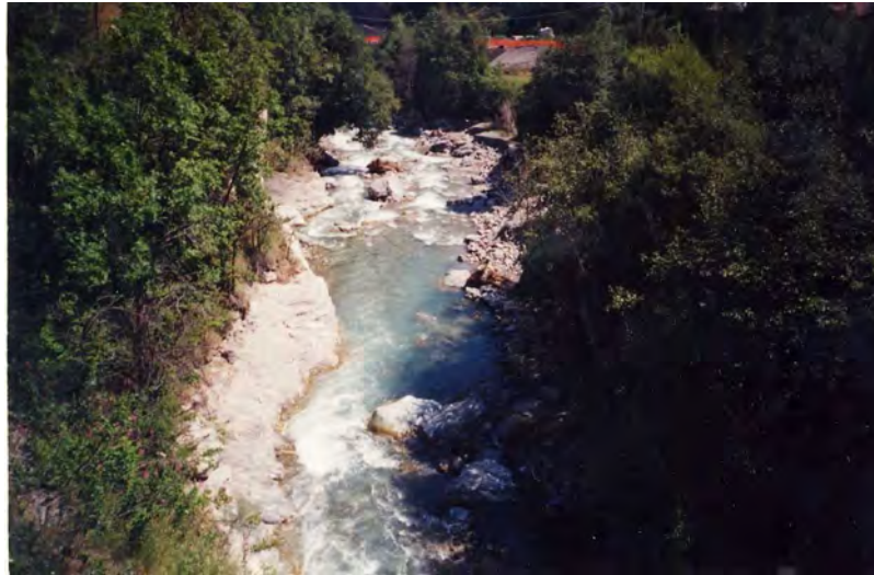
FOTO 31a- Dora Riparia al ponte di Amazas: tratto d'asta inciso in roccia, vista a valle dell'attraversamento.
