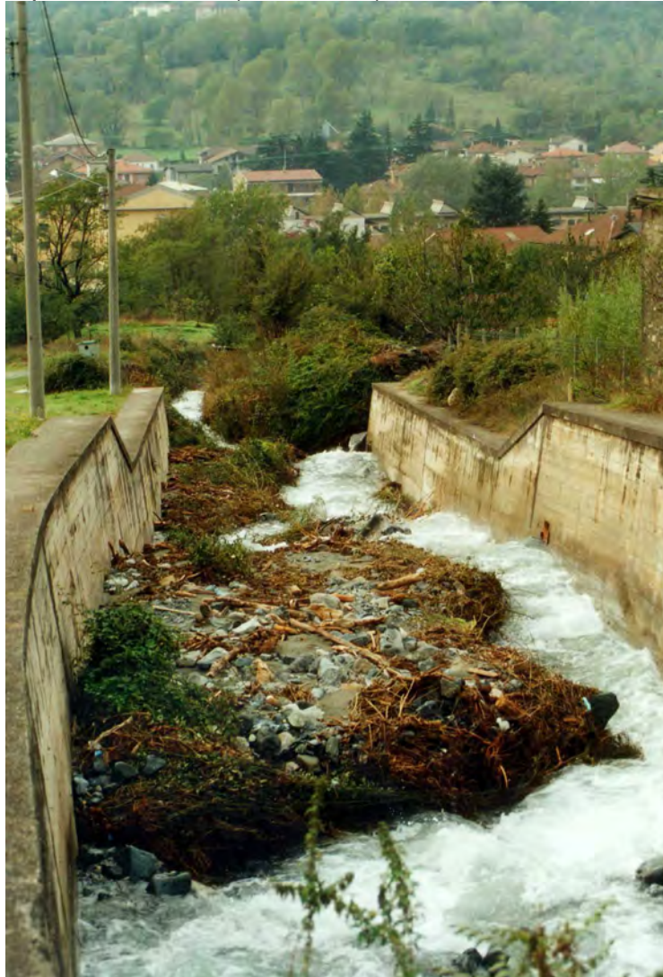
FOTO 30 - Depositi nell'alveo del T.Moletta, a monte di Bussoleno.
