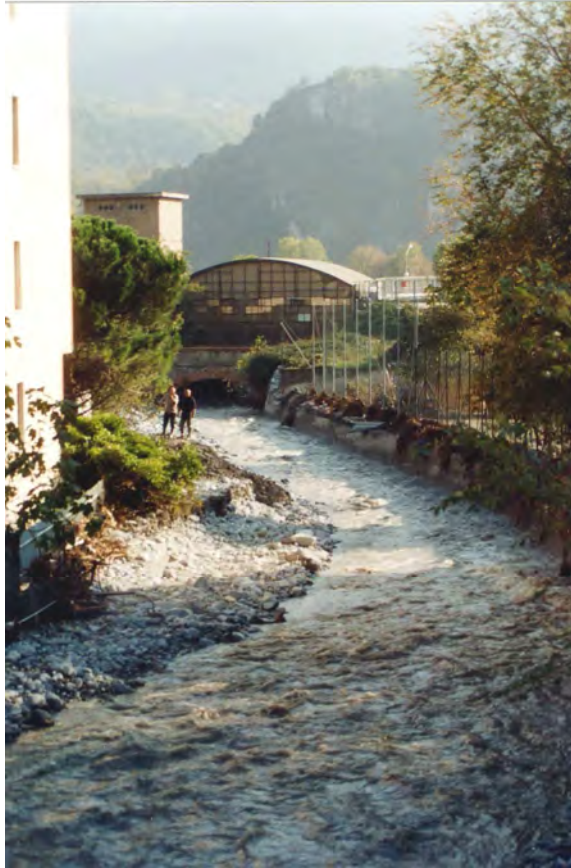
FOTO 8 - Tratto sovralluvionato del T.Cenischia, a monte del ponte stradale di S.Giuseppe (Mompantero).
