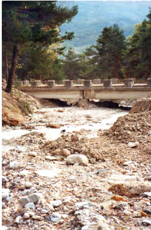
FOTO 74 - Oulx - Ponte SS 24 sul Rio Baume visto da monte
