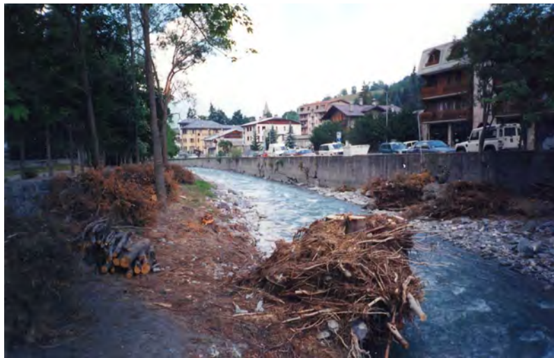
FOTO 14a- Ripa a Cesana T.se: vista tratto asta fluviale a monte del ponte del centro abitato.
