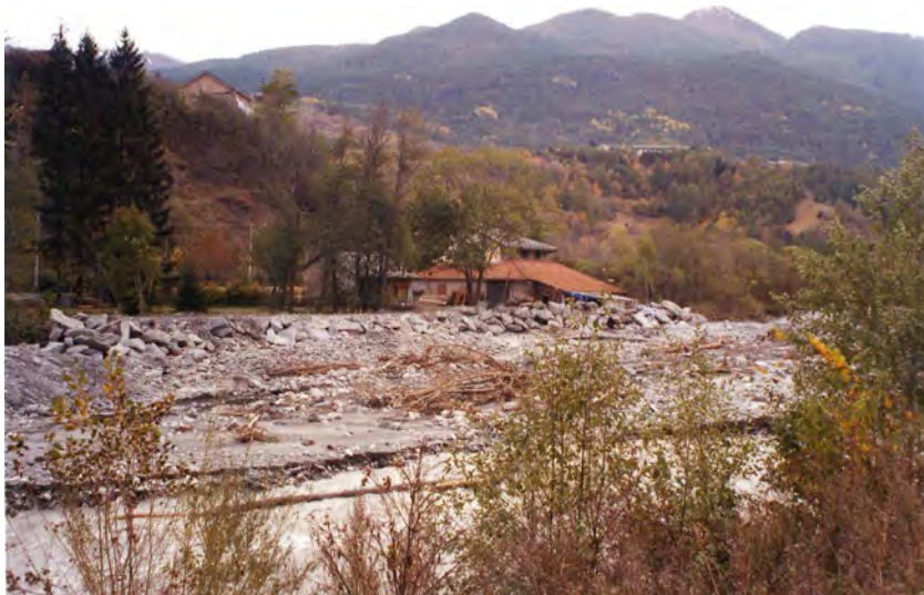
FOTO 55 - Dora Riparia a Oulx: opera di difesa spondale realizzata durante la piena del giugno 2000 e rinforzata successivamente.
