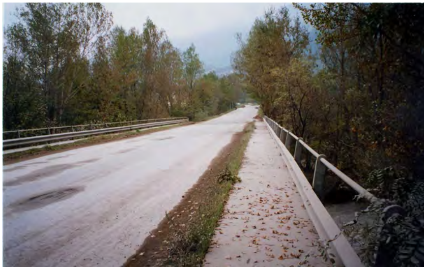
FOTO 9 - Bussoleno - ponte a monte dell'abitato, lato di monte
