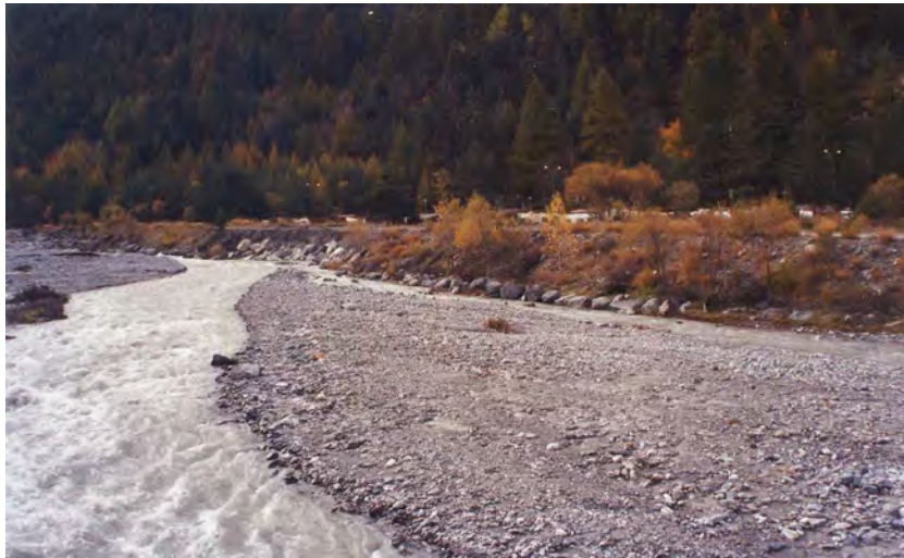
FOTO 40 - T.Ripa a Cesana: argine a protezione del campeggio (l'opera è stata rialzata dopo l'evento del giugno 2000).
