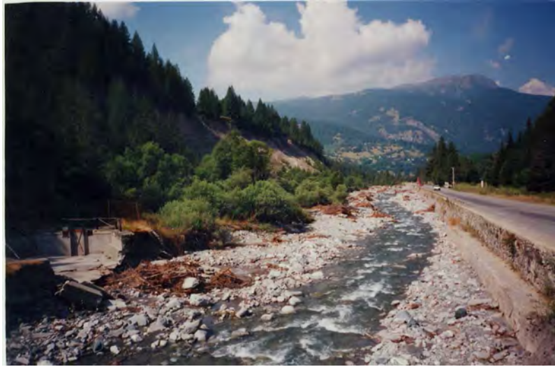
FOTO 7a- Ripa a Rollieres presso ponte di accesso a colonia estiva: vista asta fluviale a valle dell'attraversamento . Erosione spondale in sinistra e distruzione vasca allevamento ittico.
