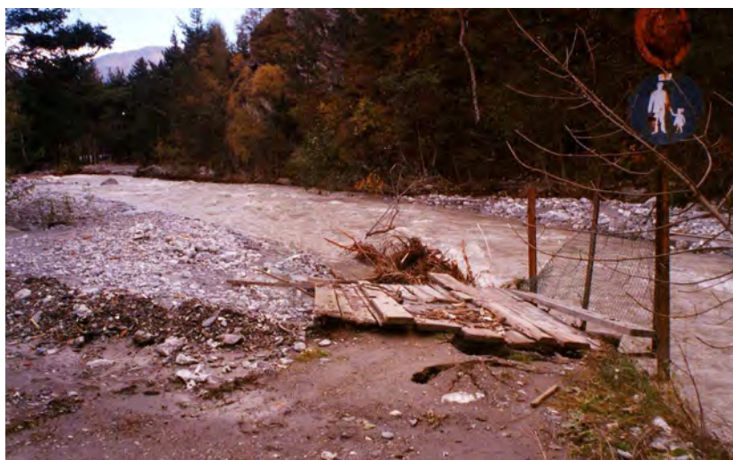
FOTO 69 - Dora di Bardonecchia: passerella carrabile divelta dall'evento del 16 ottobre a valle di Bersac.
