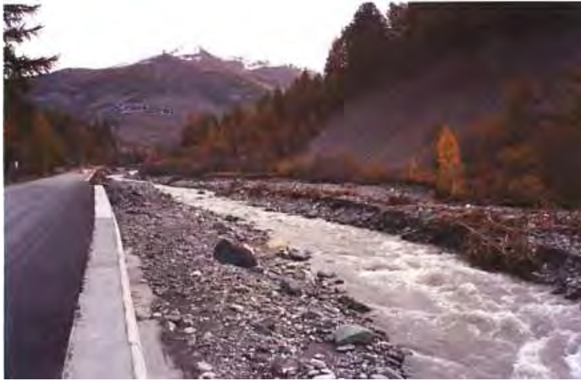
FOTO 39 - T.Ripa in località Rollieres (Sauze di Cesana): vista tratto d'alveo a monte abitato.
