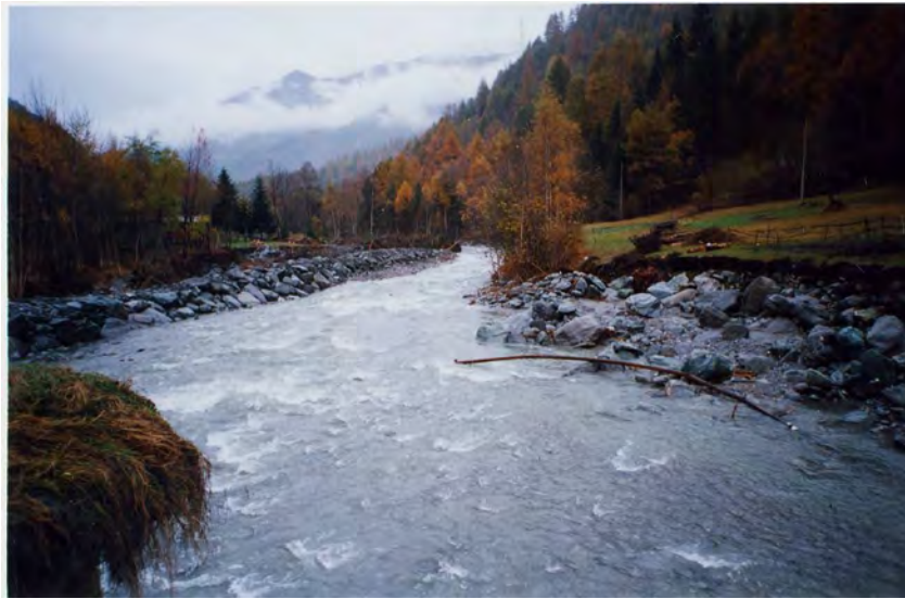
FOTO 13 - T.Chisone a Fenestrelle: tratto con erosione spondale.
