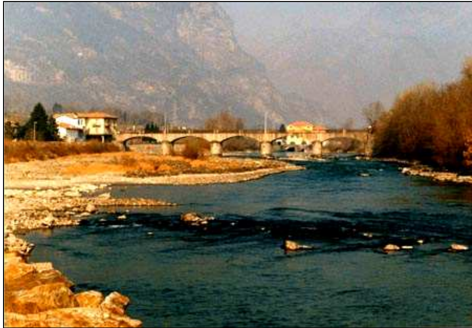
Figura 7: Ponte di Tavagnasco
