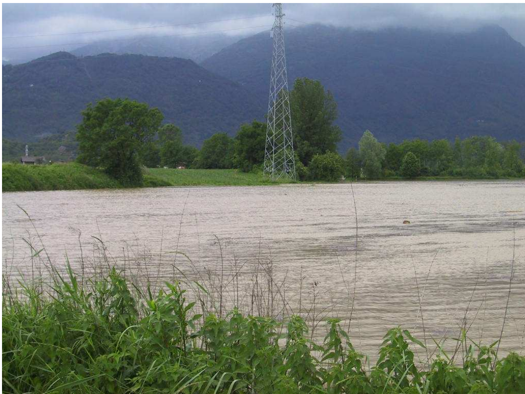
Foto n. 6: Acque della Dora Baltea in piena fuoriuscite a Fiorano
