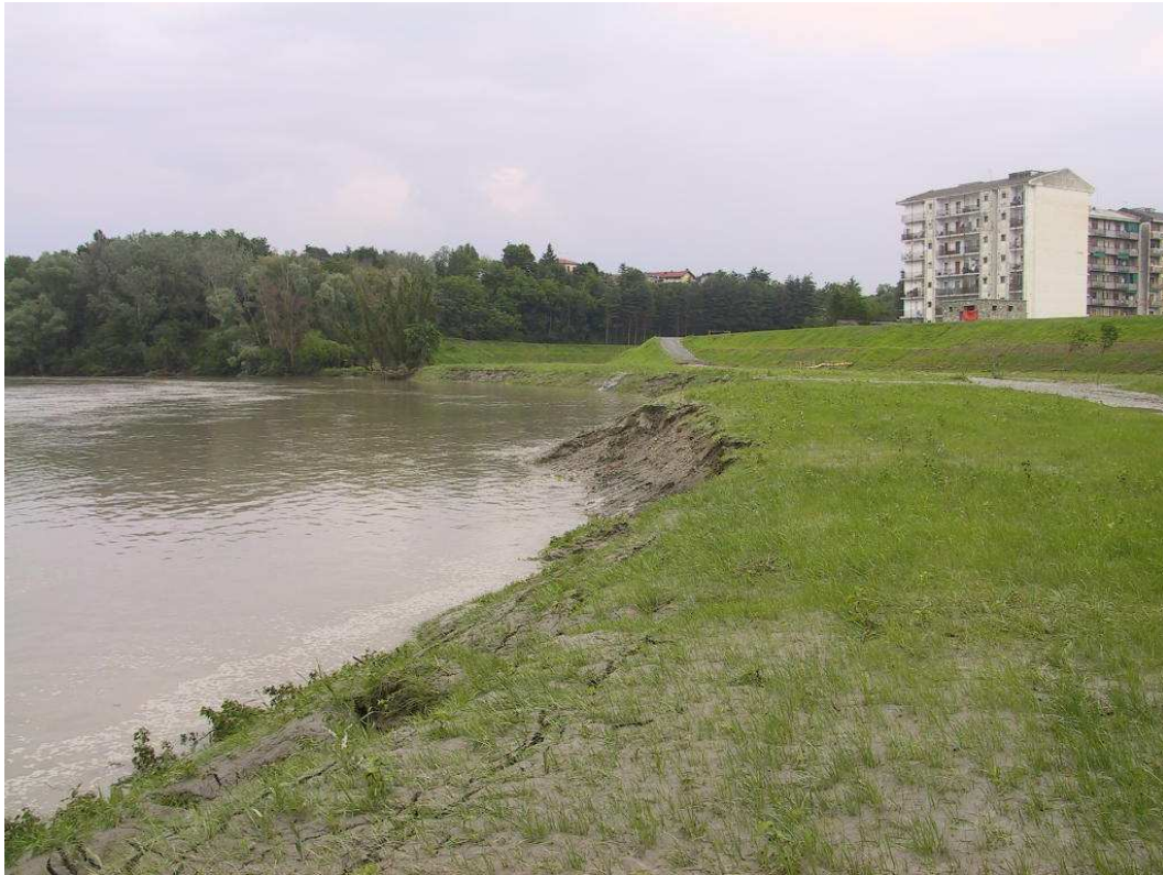
Foto n.15: Nuovo argine di Banchette nella mattina del 6 giugno
