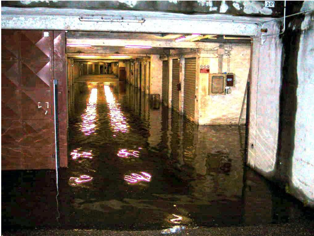
Foto n.9: Allagamento di garage e cantine a Banchette
