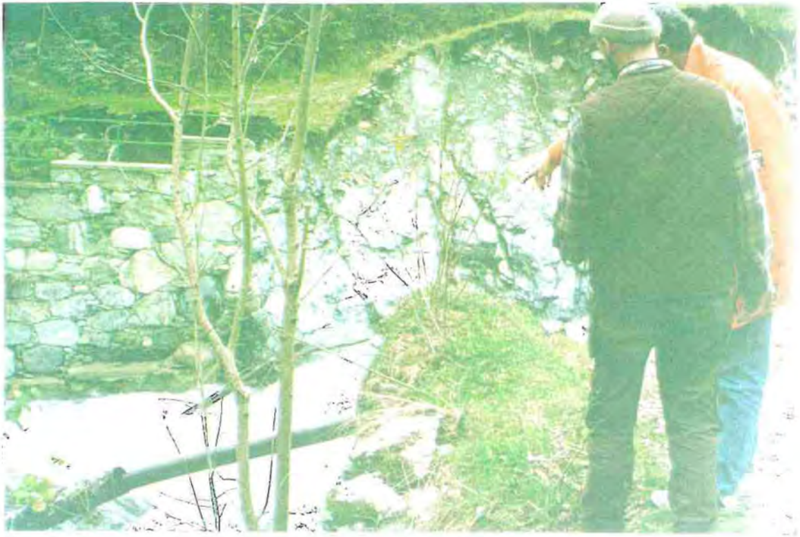
LOCALITA VILLAR CONDOTTE ADDUZIONE E PASSERELLA DI ATTRAVERSAMENTO
