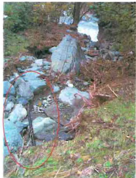
Foto 2, 3, 4: Comune di LEMIE – erosione al piede della fondazione in sponda destra dell'attraversamento. Tratti messi a nudo dall'erosione.
