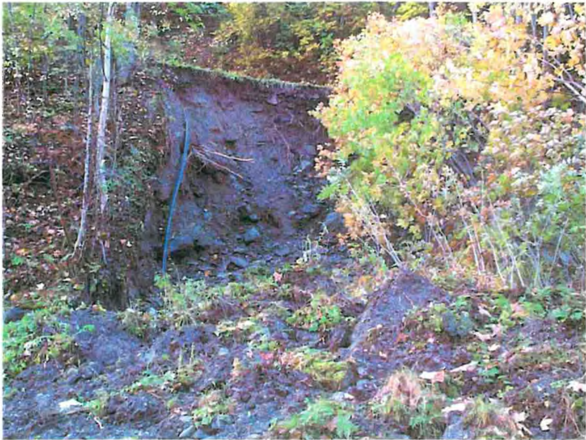
Foto 1: Comune di LEMIE – movimento franoso che ha messo a nudo un tratto della tubazione dell'acquedotto Pian Saletta – Chiot.
