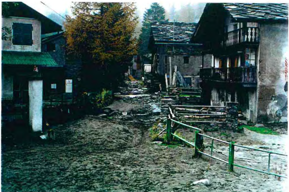
FOTO 4 FRAZIONE CHIALAMBERTETTO FOGNATURA
