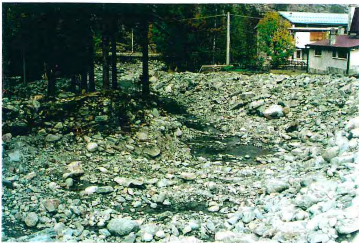
FOTO 1 LOCALITA ALBARON CONDOTTA DI ADDUZIONE ATTRAVERSAMENTO RIO PASCHIETT
