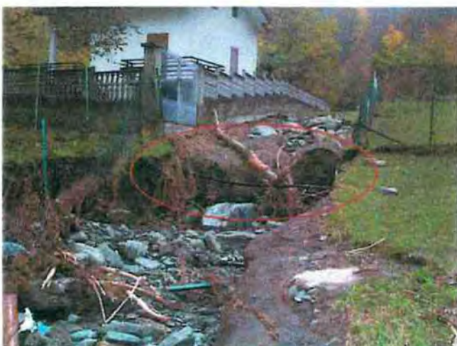
Foto 2, 3, 4: Comune di LEMIE – erosione al piede della fondazione in sponda destra dell'attraversamento. Tratti messi a nudo dall'erosione.
