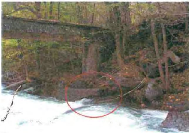
Foto 1: Comune di LEMIE – movimento franoso che ha messo a nudo un tratto della tubazione dell'acquedotto Pian Saletta – Chiot.
