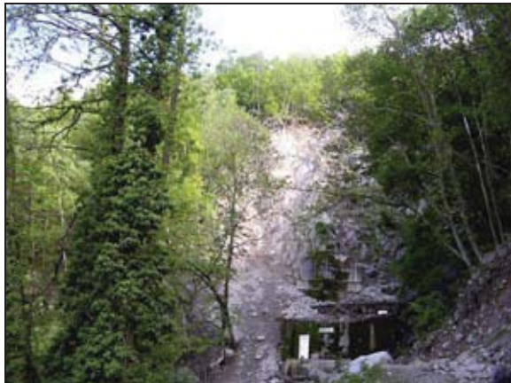
Figura 19 – Vaie, crollo presso presa acquedotto
