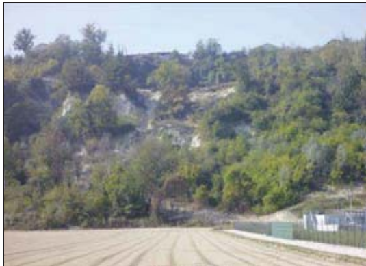
Dettaglio del coronamento dopo l'attivazione 2011
