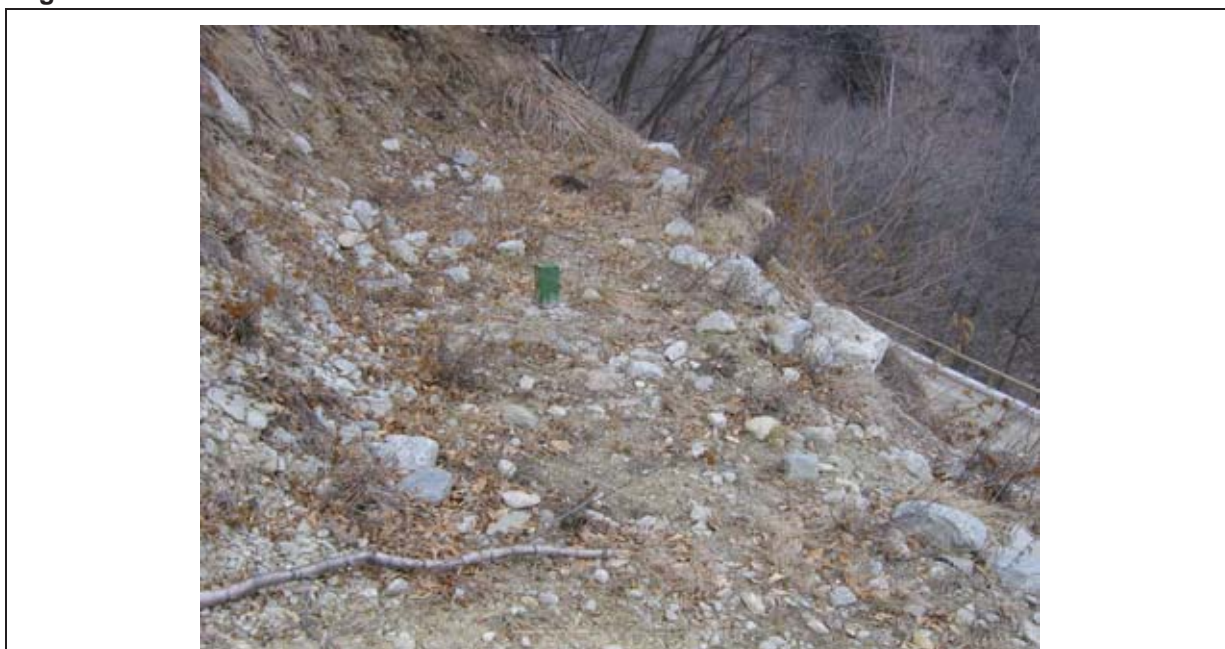
Figura 24– Frana di località Alboni. Inclinometro I1 a monte della strada comunale Alboni.
