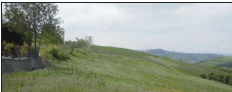
Settore di versante interessato da fenomeni di scivolamento planare presso il concentrico
