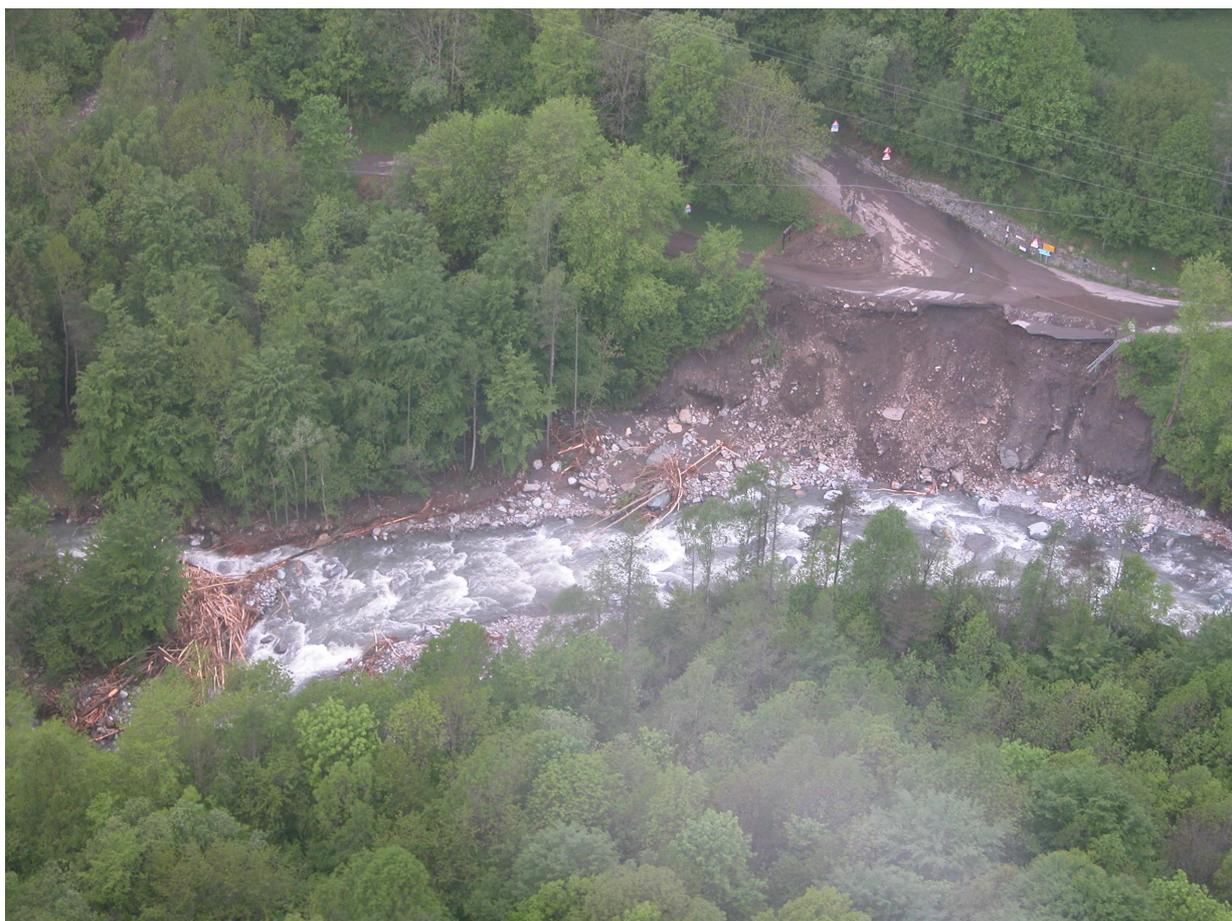
Foto 2.15 – Strada Provinciale 170. Erosione spondale del torrente Massello in corrispondenza del bivio per la diramazione per Salza di Pinerolo
