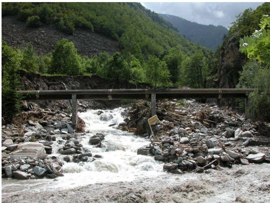
*Foto 2.10 - Comune di Roreto Chisone: accentuata erosione sulla sponda destra idrografica del Rio Borsetto alla confluenza col Torrente Chisone.*
