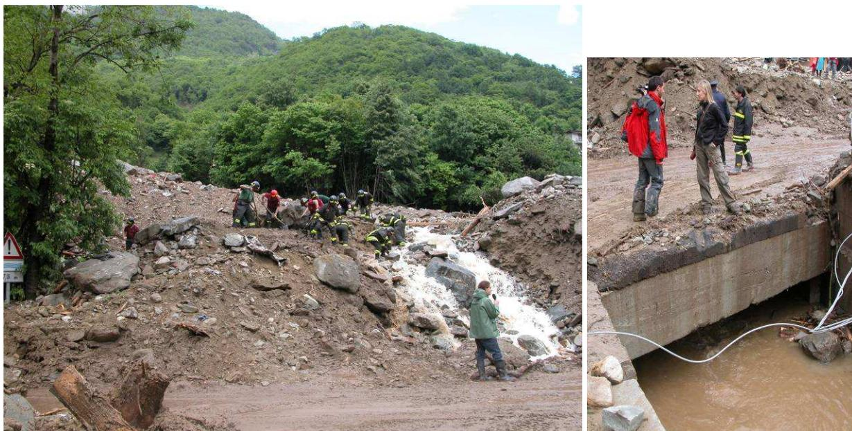
*Foto 2.25 e 2.26 - Comune di Villar Pellice. Vista verso monte del debris flow che ha interessato la frazione di Garin. Lo spessore del materiale detritico accumulato è stimabile in diversi metri, come si può vedere rispetto alla strada. La sezione dell'attraversamento sulla SP 161 (vista da valle ) è visibilmente scarsa.*
