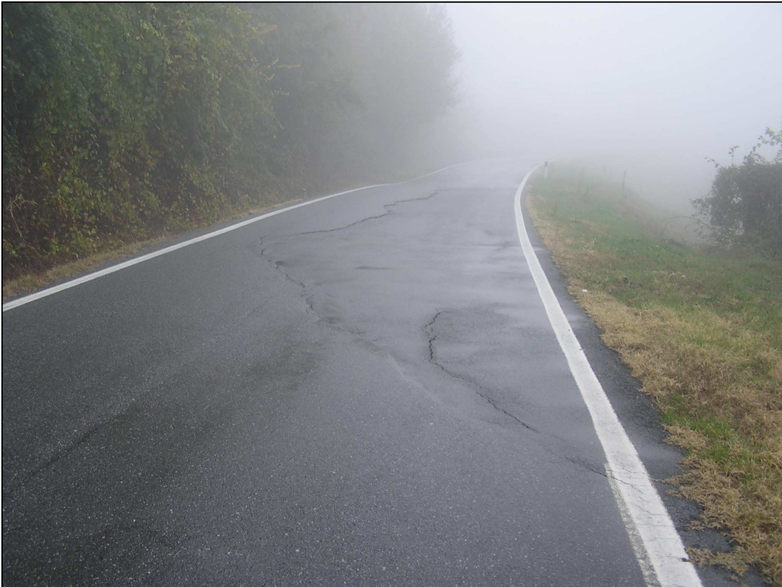
SP n.50 (Guarene: cedimento manto stradale)
