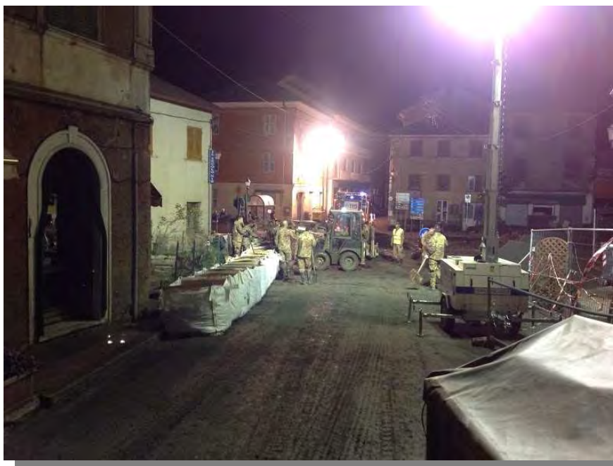
Comune di Montoggio (GE) – Realizzazione barriera antinondazione BIGBAG in p.zza Balilla
