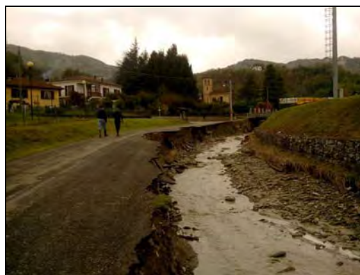
Figura 5 – Garbagna, attraversamento ostruito e danni a sede stradale
