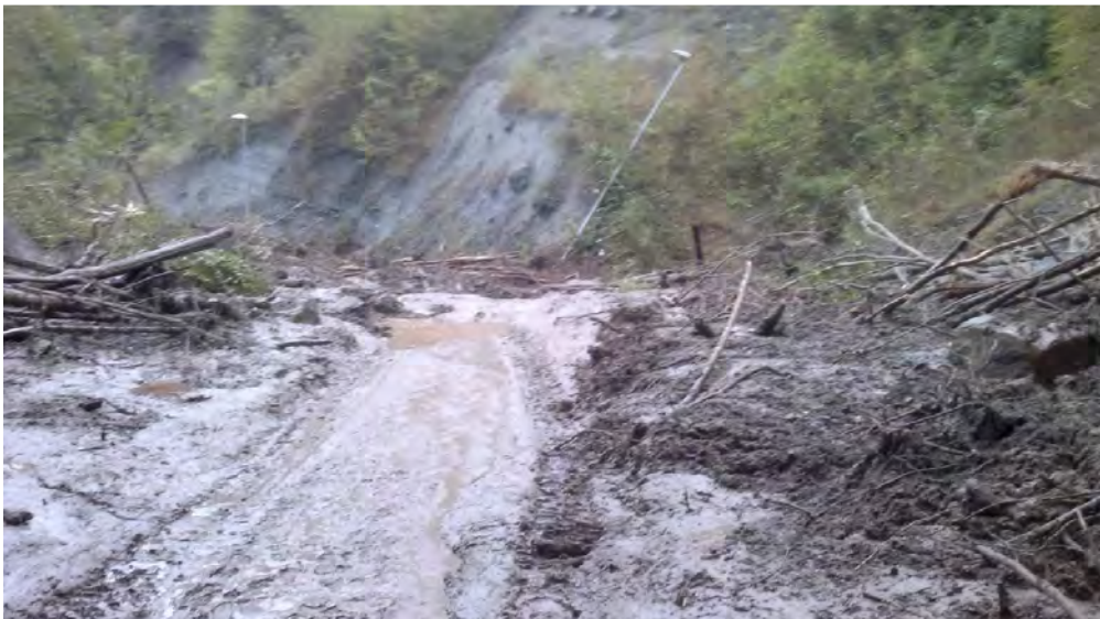
FOTO 18: S.P. n. 120 “della Val Grue” Galleria delle Tane in Comune di Garbagna
