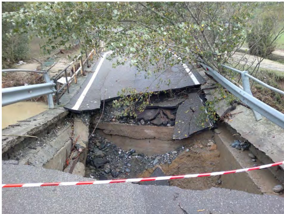
FOTO 1: SP 158 “Della Lomellina” Ponte al km 3+600
