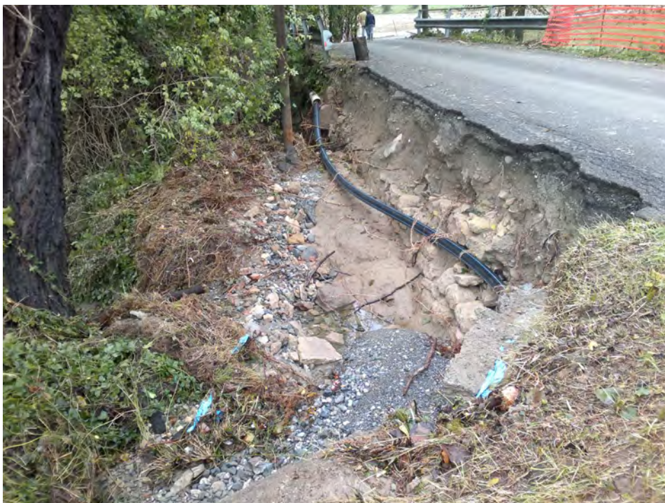
FOTO 10: SP 162 “di Monterotondo” al km 0+300
