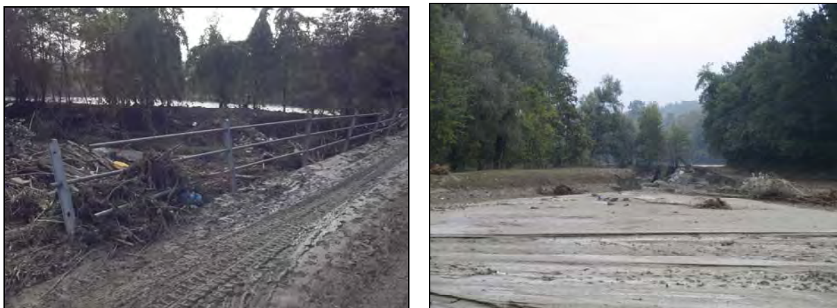
Figura 6 – Sarezzano, T. Grue. Ponte Pianeto e rottura arginale
