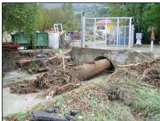
Figura 5 – Garbagna, attraversamento ostruito e danni a sede stradale
