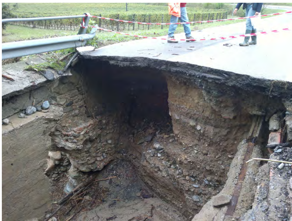
FOTO 2: SP 158 “Della Lomellina” Ponte al km 3+600
