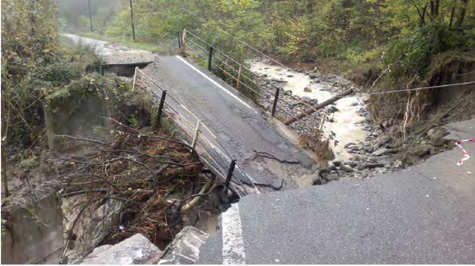
FOTO 13: S.P. n. 123 “di Montebore” al km 1+000
