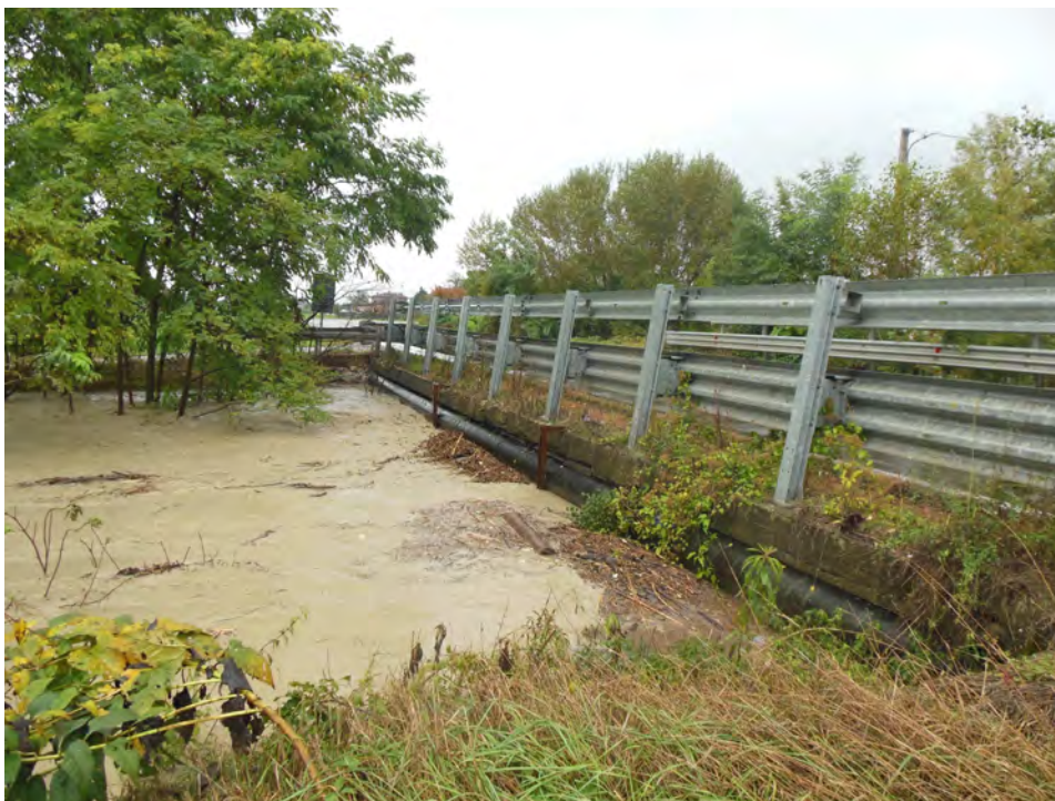
FOTO 20: S.P. n. 99 “Tortona-Rivanazzano” in Comune di Viguzzolo
