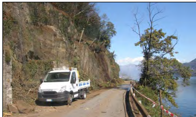
Figura 26 – Cannobio, panoramica della frana (in secondo piano).
