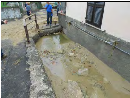
Figura 19 – Stazzano. Danni nel centro abitato. In basso, ostruzione intubamento e zona rio Vargo.
