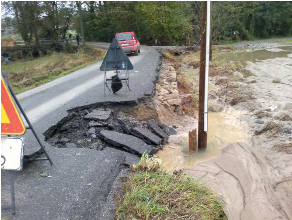
FOTO 9: SP 162 “di Monterotondo” al km 0+400
