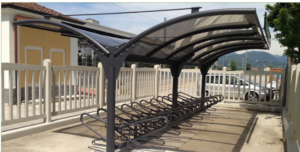
Tettoia a pensilina aperta sui lati
