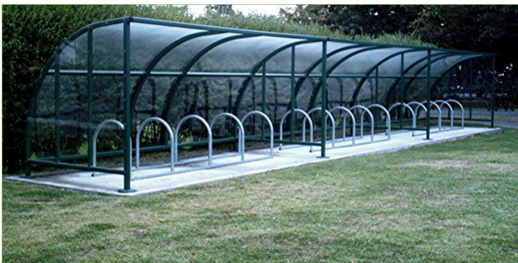
Tettoia con pareti laterali
