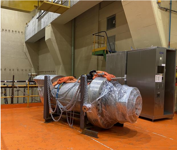
Pompa primaria – Realizzazione smantellamento sistema primario escluso grandi componenti
