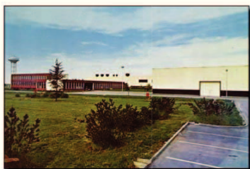
Impianto di Bosco Marengo
