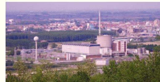
Centrale di Trino
