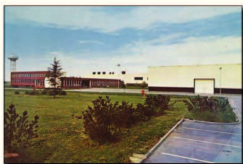
Impianto di Bosco Marengo
