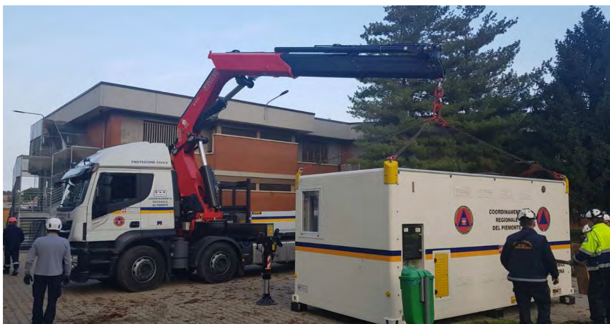
Fasi di montaggio della cucina mobile da campo
