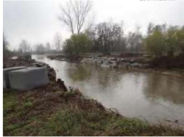
Figura 78. Comune di None: meandro nei pressi di San Ponzio con tracce di sormonto delle acque; a destra le spalle della passerella divelta dalla piena di ottobre 2019.
