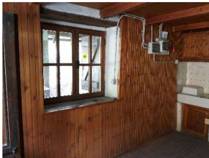
Dopo l'intervento.- Foto A. Meirone
