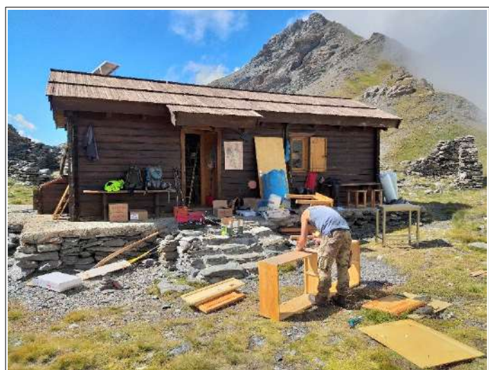
Lavori ignifugazione del bivacco del Colle del Beth. - Foto A. Meirone
