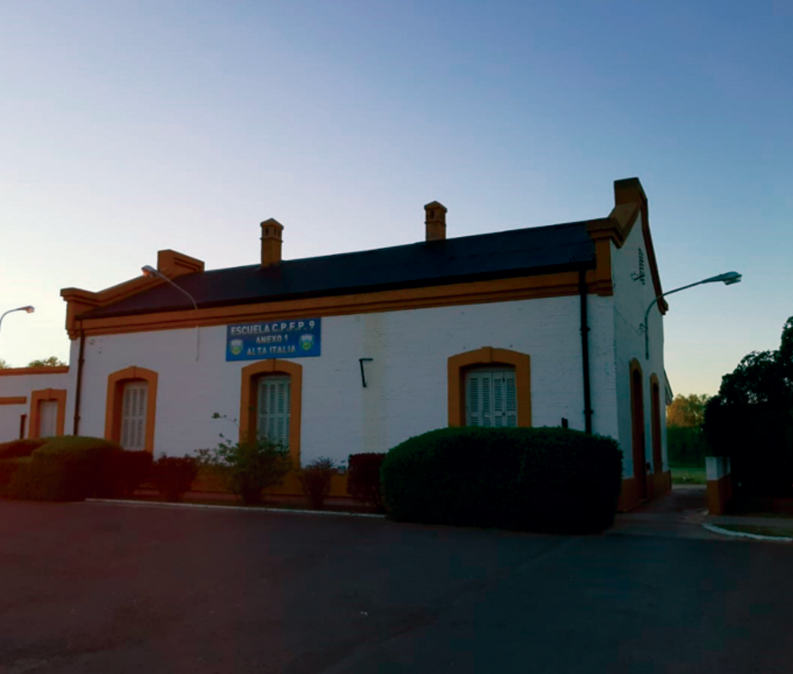
Estación del ferrocarril Sarmiento
