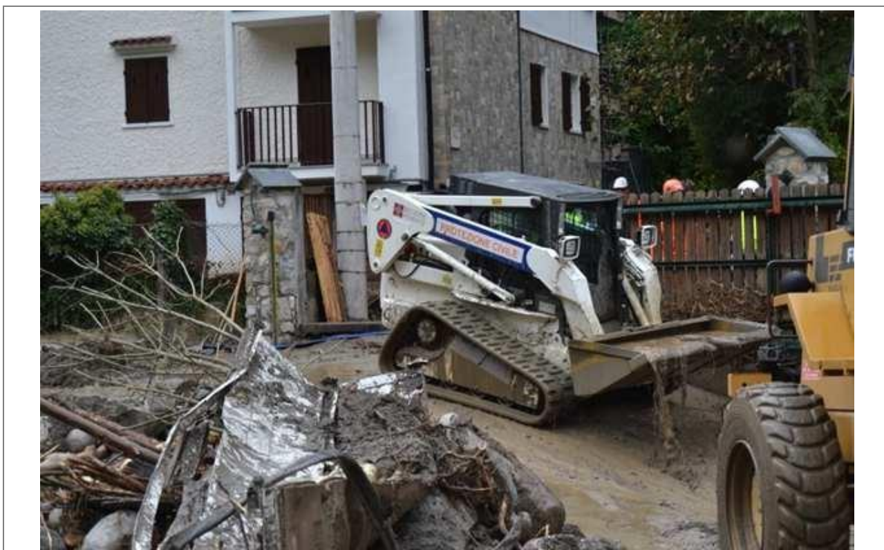
Mezzi della logistica regionale impegnati nelle attività di rimozione detriti a Limone Piemonte (CN)
