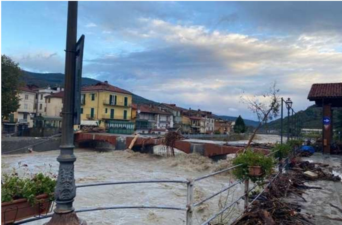
Ponte di Gressio (CN) sul fiume Tanaro
