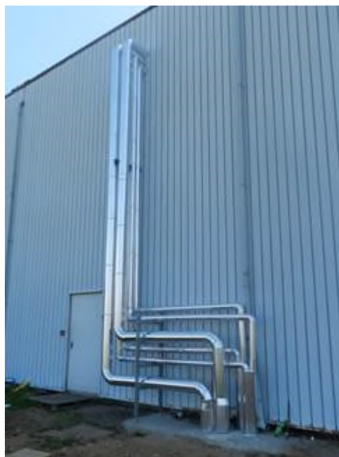
Figura 2-81 – Attività di coibentazione delle tubazioni dei fluidi termomettori
