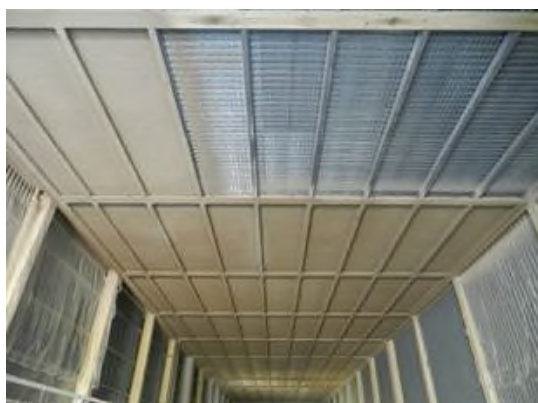
Figura 2-63 – Attività di posa dell'intonaco ignifugo
