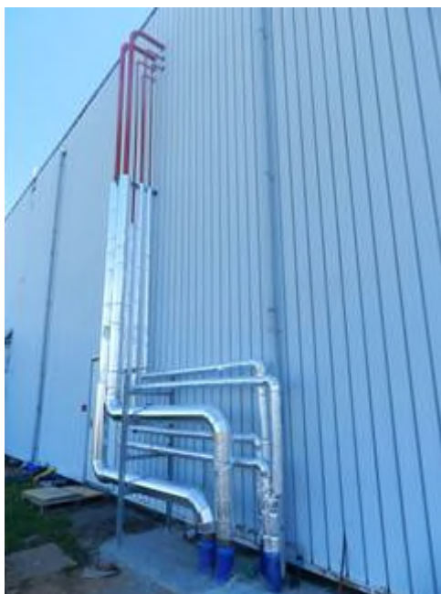
Figura 2-81 – Attività di coibentazione delle tubazioni dei fluidi termomettori
