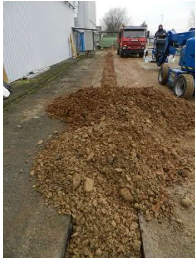
Figura 2-82 – Posa tubazioni interrate del sistema drenaggi
