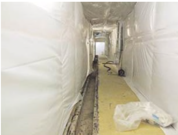
Figura 2-52 – Scarifica cunicolo corridoio A214
