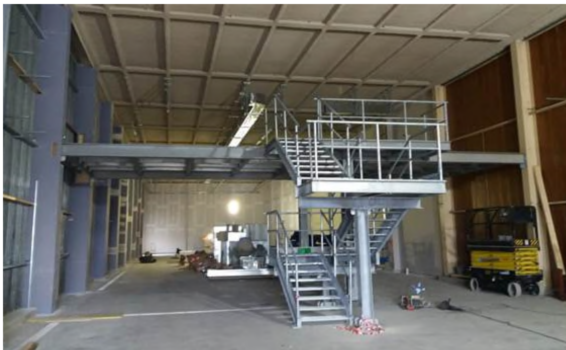
Figura 2-72 – Montaggio struttura metallica del soppalco
