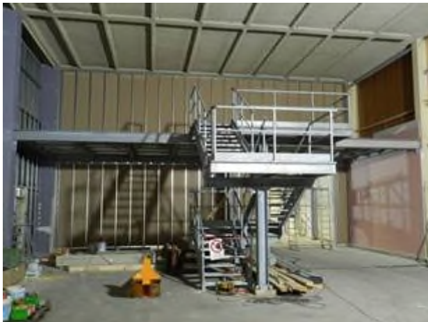
Figura 2-73 – Montaggio pareti laterali del soppalco
