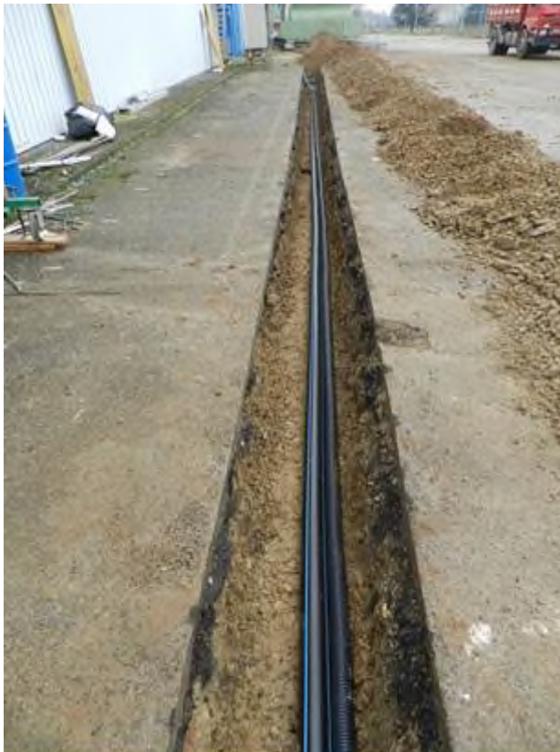
Figura 2-82 – Posa tubazioni interrate del sistema drenaggi
