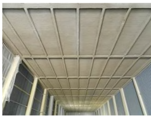
Figura 2-63 – Attività di posa dell'intonaco ignifugo
