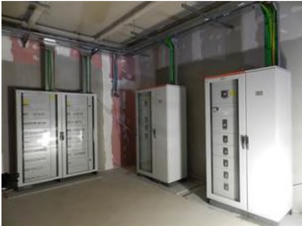
Figura 2-83 – Installazione Quadri elettrici e UPS
