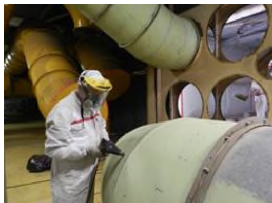
Figura 2-24 – Smantellamento tubazioni nel locale A221 dell'Edificio BLD2
