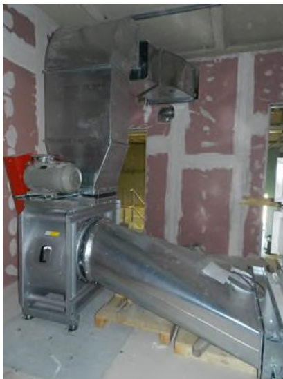
Figura 2-84 – Installazione ventilatore di estrazione e canister
