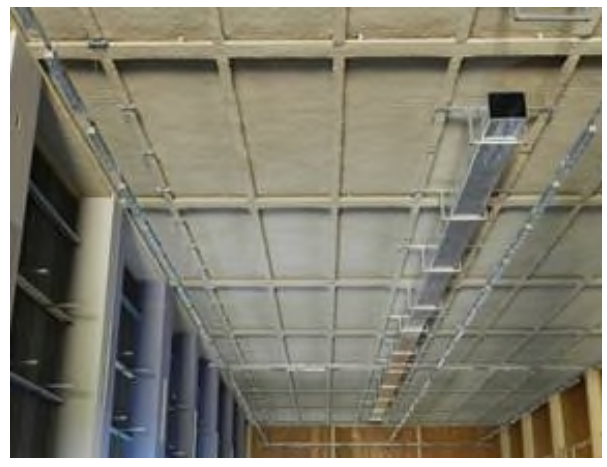
Figura 2-65 – Attività di posa staffaggi e condotta ventilazione sul soffitto B106
