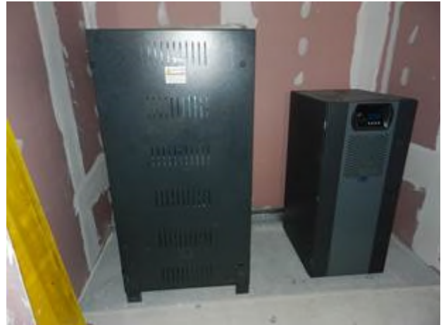
Figura 2-83 – Installazione Quadri elettrici e UPS
