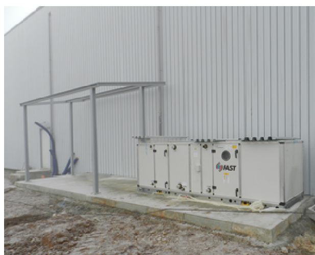
Figura 2-78 – Installazione UTA esterna su basamento in calcestruzzo
