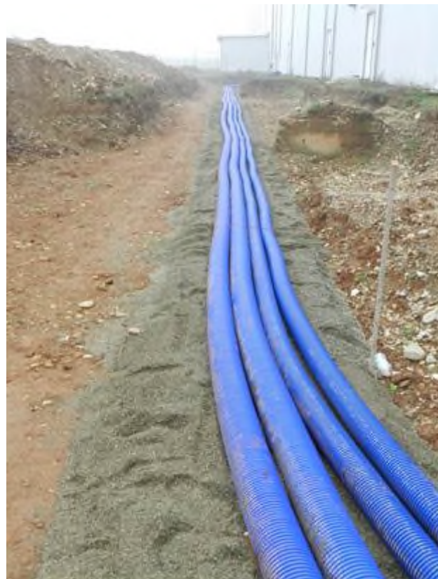
Figura 2-76 – Montaggio tubazioni interrate per fluidi termovettori
