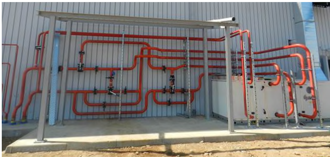
Figura 2-80 – Montaggio tubazioni per fluidi termovettori
