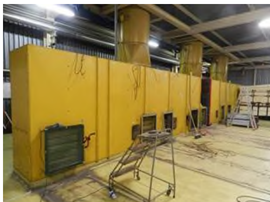
Figura 2-25 – Smantellamento filtrazione nel locale A221 dell'Edificio BLD2
