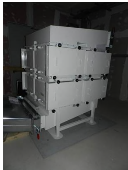
Figura 2-84 – Installazione ventilatore di estrazione e canister
