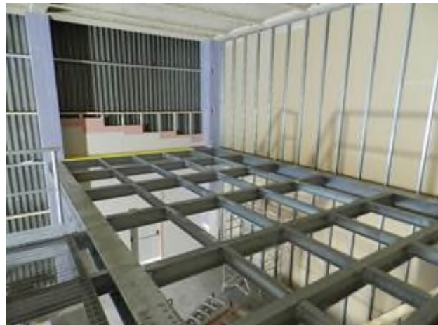
Figura 2-73 – Montaggio pareti laterali del soppalco
