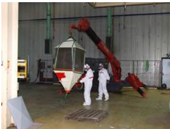
Figura 2-16 – Smontaggio filtri elettrostatici nell'area A124
