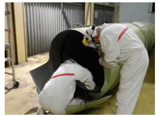
Figura 2-24 – Smantellamento tubazioni nel locale A221 dell'Edificio BLD2
