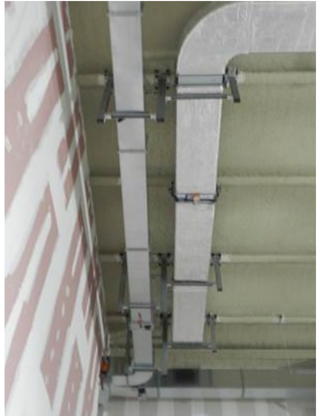
Figura 2-75 – Montaggio condotte di ventilazione
