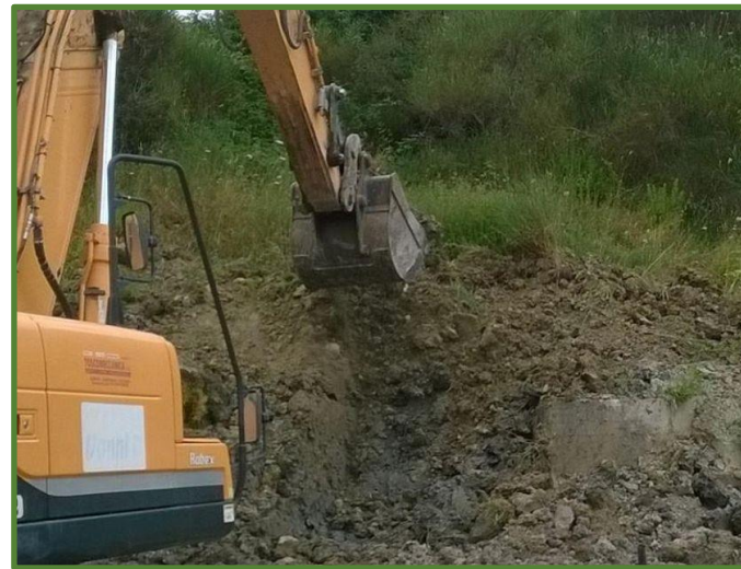
Ruspa durante un'opera di ripristino
