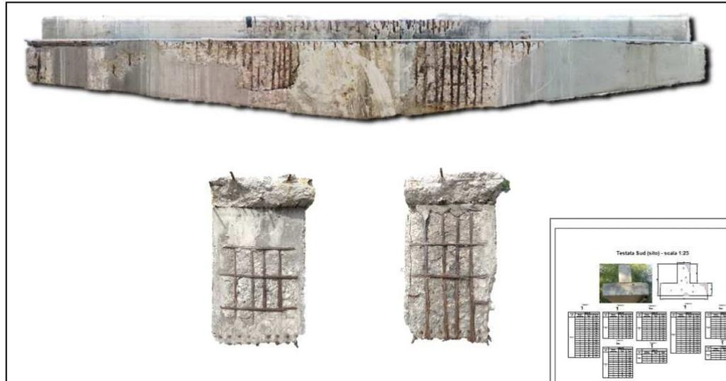
Mappatura del quadro fessurativo e delle aree delaminate
