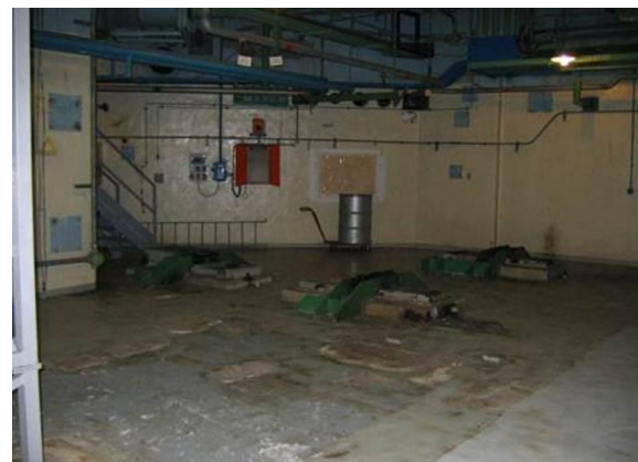
Locale scambiatori dopo lo smantellamento
