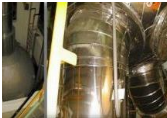
Smantellamento componenti non contaminati e rimozione coibenti pericolosi
