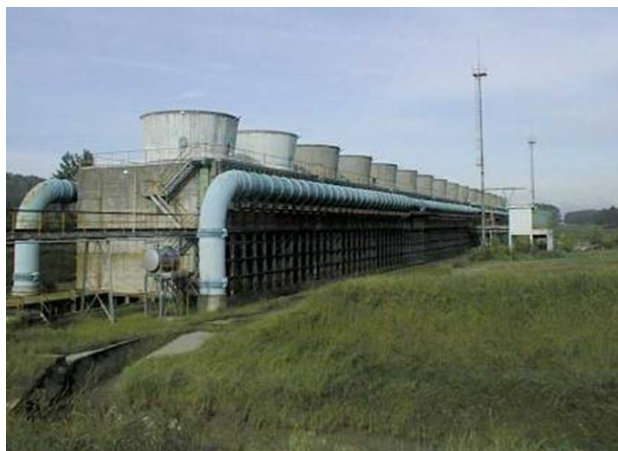
Torri di raffreddamento prima dello smantellamento
