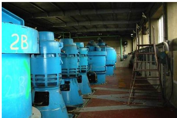
Opera di presa prima dello smantellamento
