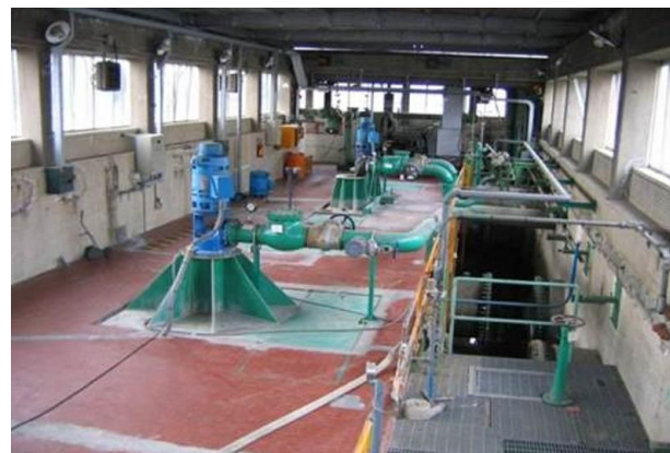
Opera di presa dopo lo smantellamento
