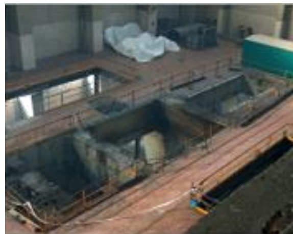
Smantellamento turbine e alternatori
