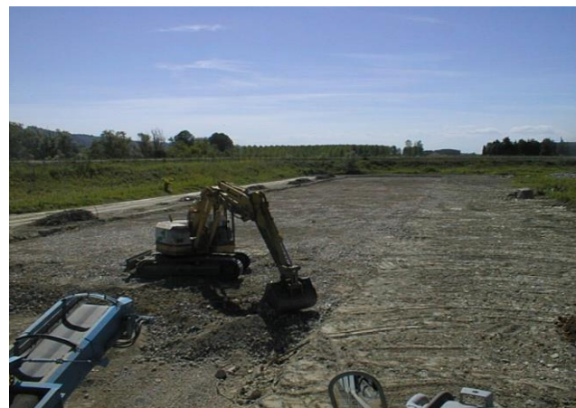
Smantellamento torri di raffreddamento
