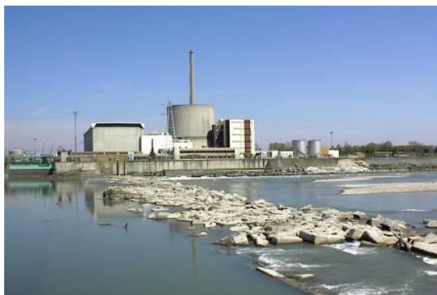
Traversa sul Po prima dello smantellamento
