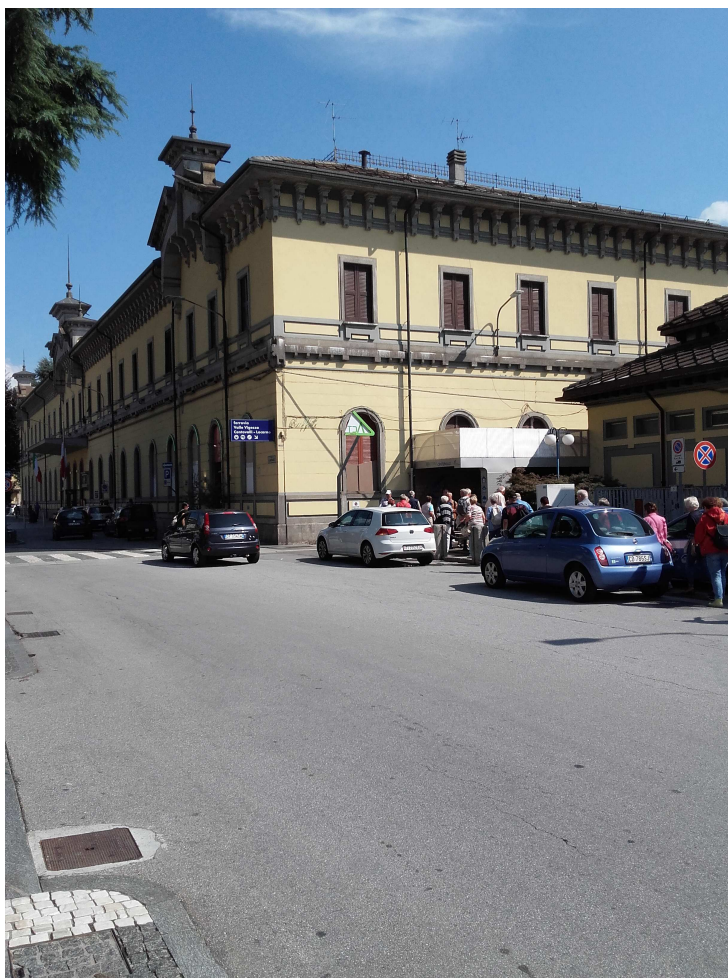
Foto 4 – veduta del fabbricato stazione ferroviaria da via Bonomelli
