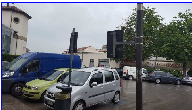
Porzione del parcheggio sud-est con vista del nuovo edificio movicentro con torretta ascensore
