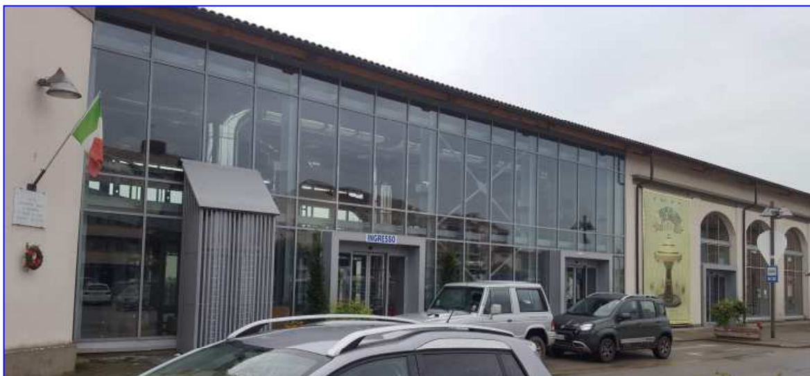
Vista edificio movicentro: a sinistra fabbricato B di nuova costruzione e di seguito l'edificio A (ex scarico merci) ristrutturato
