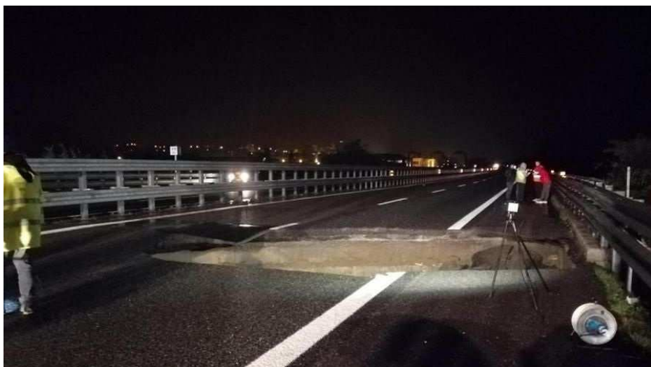
Viabilità autostradale danneggiata dall'evento: Autostrada A6 (Torino-Savona) e Autostrada A21 – Torino – Piacenza – Danni viabilità
