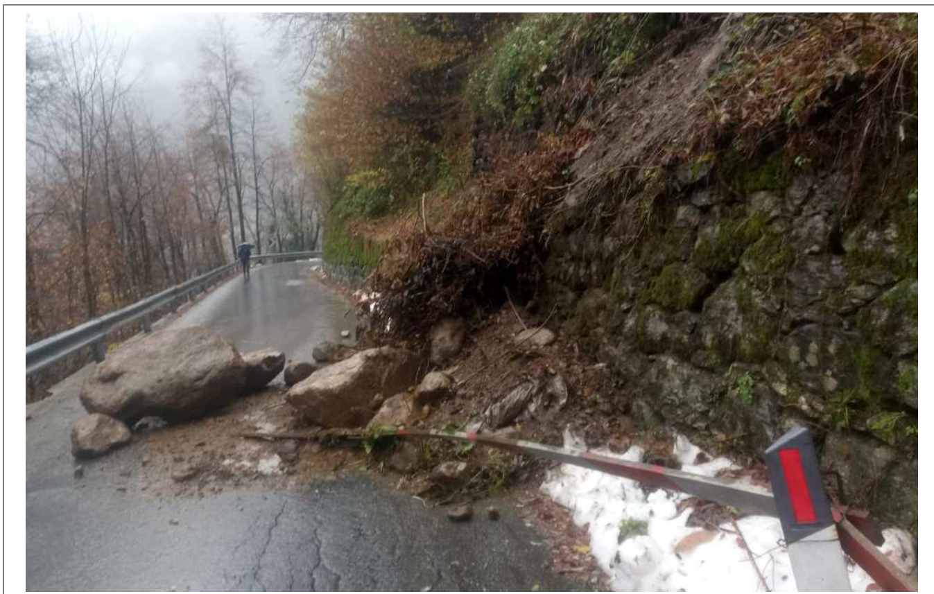
Smottamento su strada comunale a Bannio Anzino (VCO), dello scorso 23 novembre 2019
