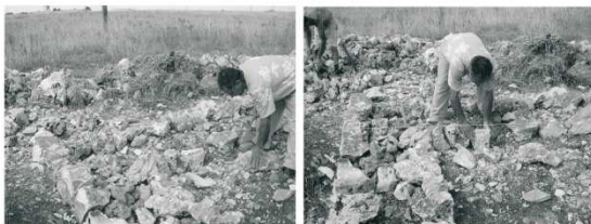
Fasi costruttive di un muro a secco. Da A. COSTANTINI, Salento. Paesaggio delle pietre , Galatina 2012.
