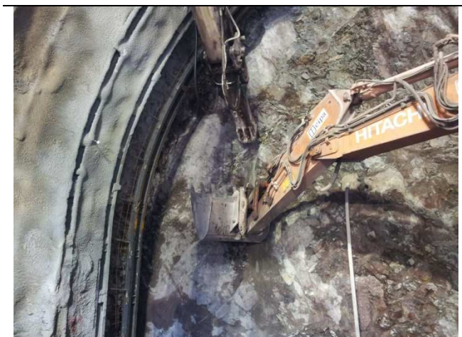
Figura 2 – Prelievo di un incremento dal fronte di scavo
