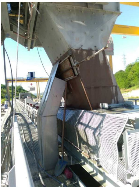
Figura 9 - Tramoggia con campionatore a deviazione di flusso
