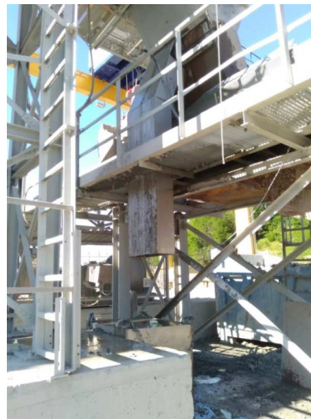
Figura 10 - Condotta di recapito degli incrementi di smarino in vasca di campionamento
