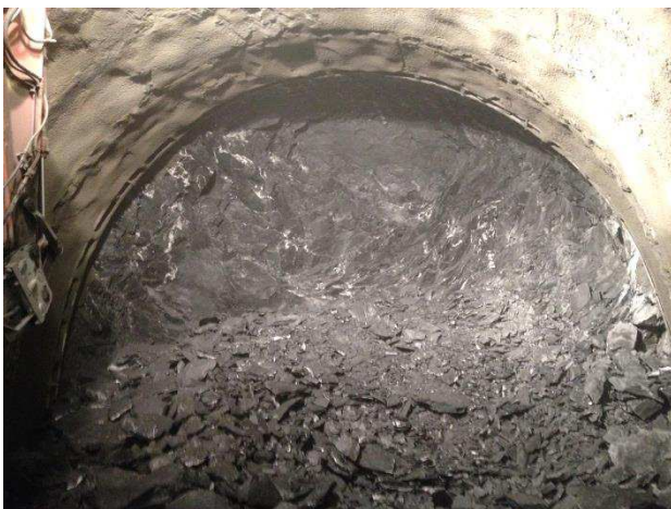
Figura 5 – Cumulo dell'abbattuto al piede del fronte
