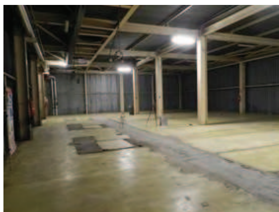
Figura 2-33 – Rimozione del linoleum nel locale A221
