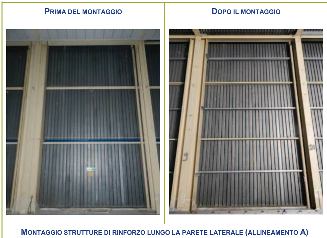
Figura 2-52 – Montaggio strutture di rinforzo lungo la parete laterale (Allineamento A)
