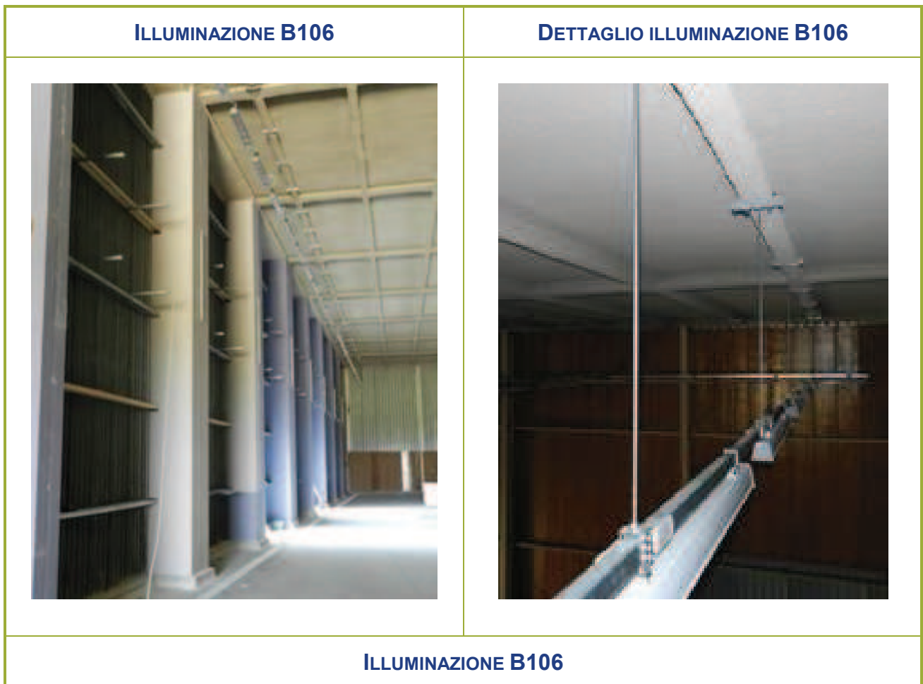
Figura 2-63 – Montaggio delle plafoniere per l'illuminazione del locale B106
