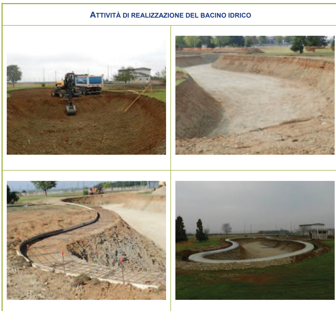
Figura 2-51 – Attività di realizzazione del bacino idrico
