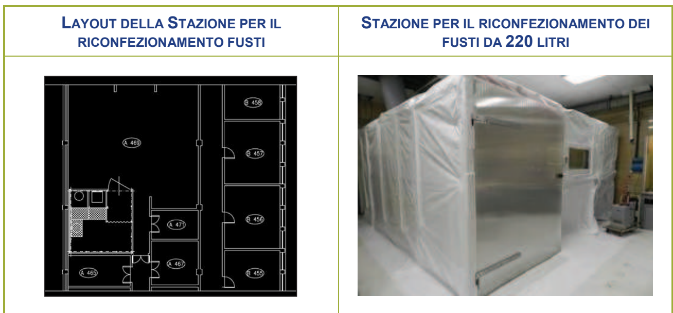
Figura 2-11 – Stazione per il riconfezionamento dei fusti di rifiuti con U-235 > 10 g
