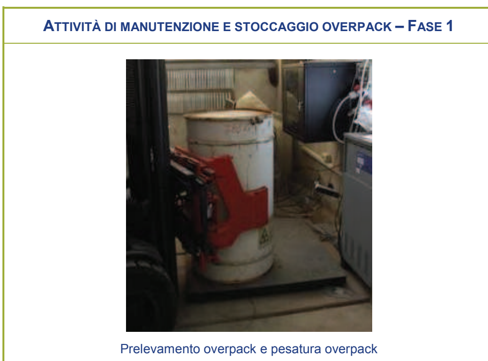
Figura 2-45 – Attività di manutenzione e stoccaggio overpack – Fase 1
