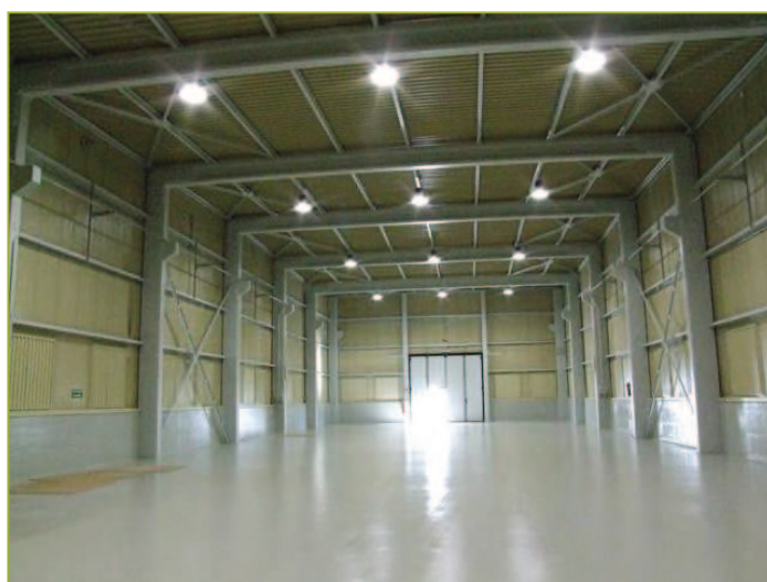
Figura 2-42 – Edificio BLD11 al termine delle attività di adeguamento
