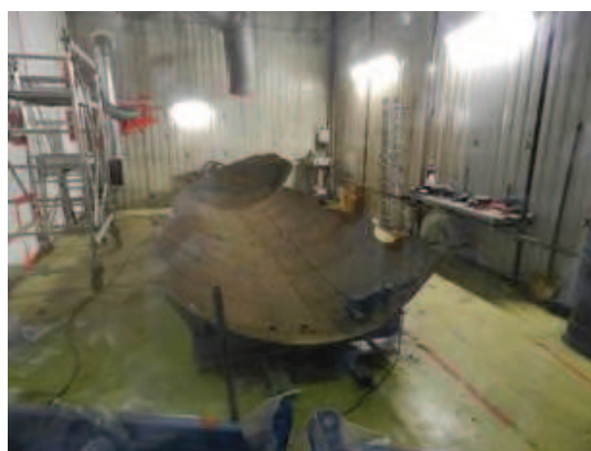
Figura 2-31 – Smantellamento del serbatoio SR6 nella capannina di taglio (A102)
