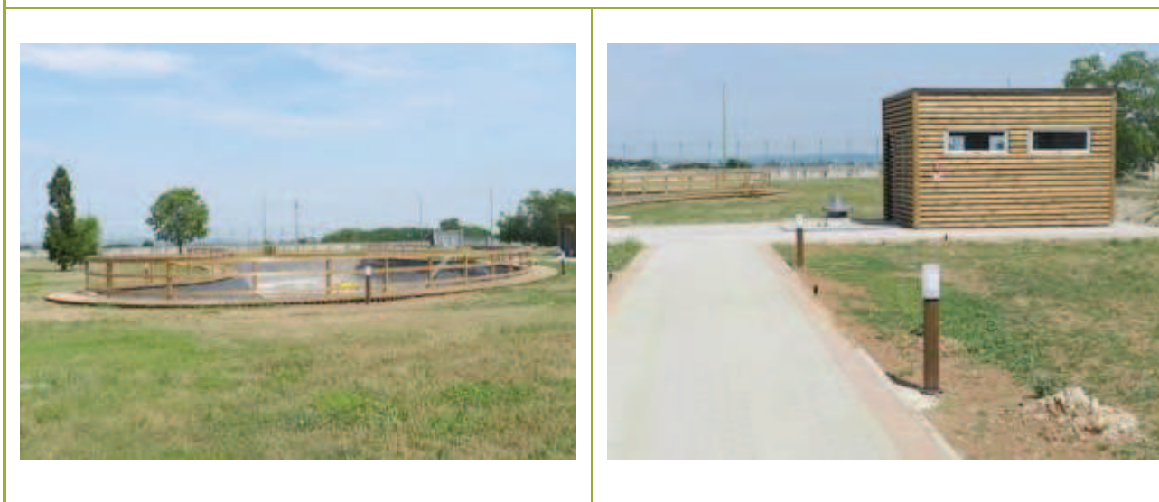
Figura 2-54 – Stato finale delle opere di realizzazione del bacino idrico e sistema di pressurizzazione
