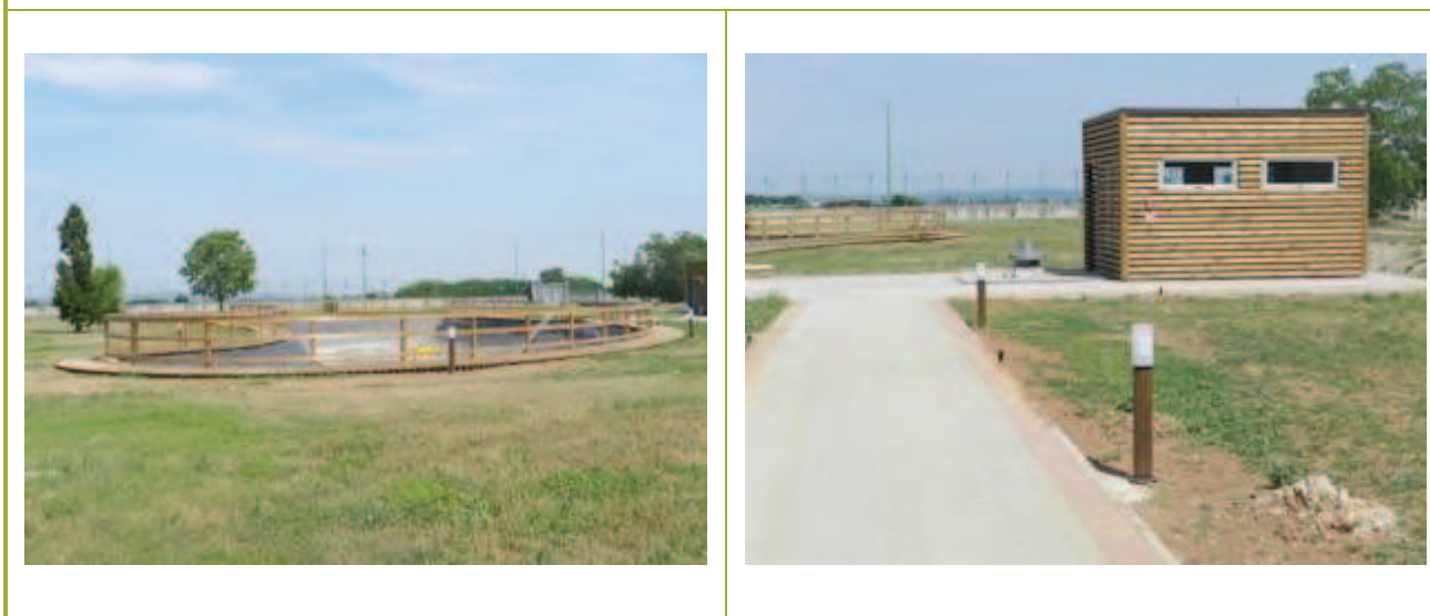
Figura 2-78 – Stato finale delle opere di realizzazione del bacino idrico e sistema di pressurizzazione
