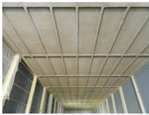
Figura 2-60 – Attività di posa dell'intonaco ignifugo
