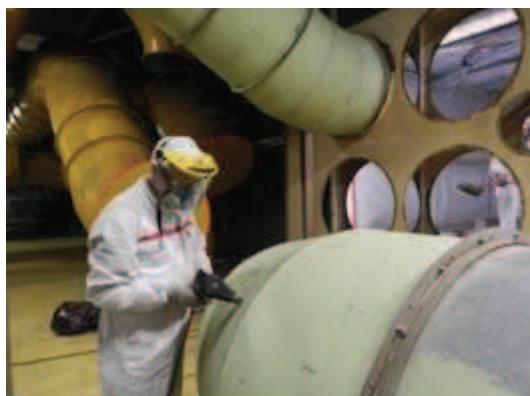
Figura 2-24 – Smantellamento tubazioni nel locale A221 dell'Edificio BLD2
