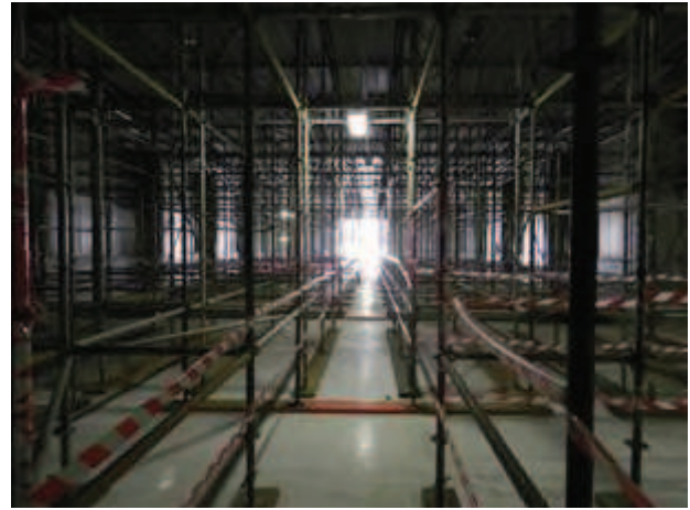
Fase I – Montaggio opere provvisorie (ponteggi)
