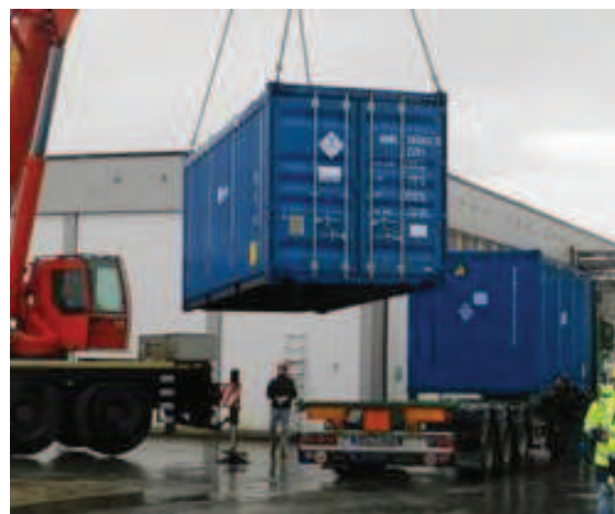
Figura 2-55 – Caricamento dei container IP-2 sul vettore di trasporto
