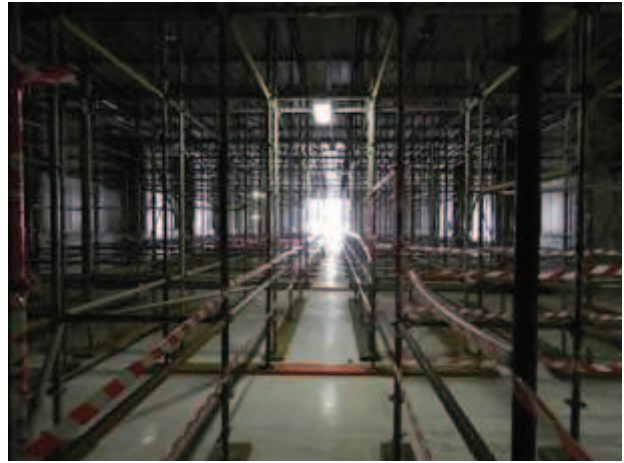
Fase I – Montaggio opere provvisorie (ponteggi)
