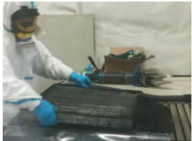
Figura 2-42 – Smantellamento prefiltri e filtri nell'area di taglio A104
