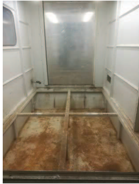
Figura 2-43 – Pulizia cabina di decontaminazione ad umido e recupero fanghi
