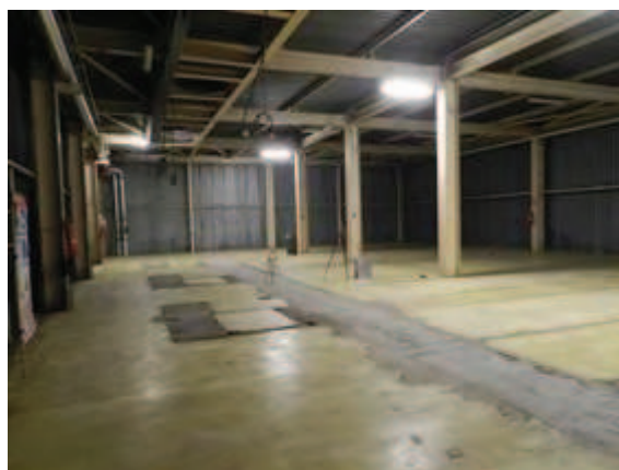
Figura 2-33 – Rimozione del linoleum nel locale A221
