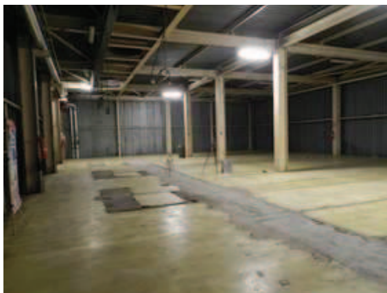
Figura 2-33 – Rimozione del linoleum nel locale A221
