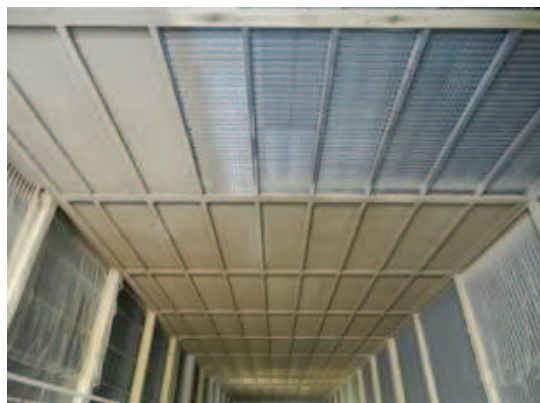
Figura 2-60 – Attività di posa dell'intonaco ignifugo
