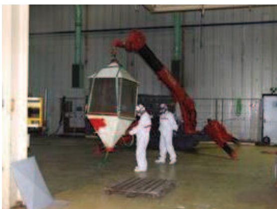
Figura 2-16 – Smontaggio filtri elettrostatici nell'area A124
