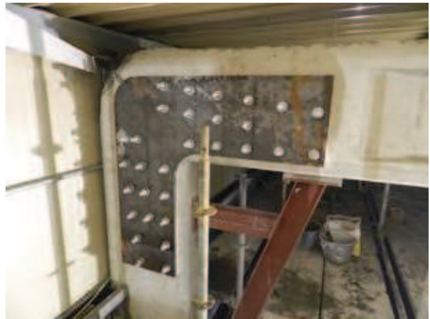
DOPO IL MONTAGGIO
