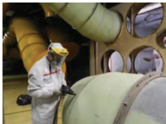
Figura 2-24 – Smantellamento tubazioni nel locale A221 dell'Edificio BLD2
