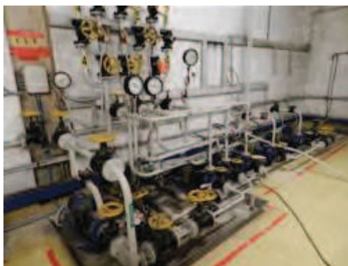
Figura 2-38 – Smantellamento del sistema di trasferimento dei liquidi radioattivi
