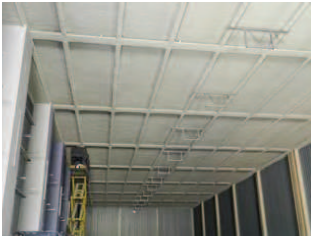
Figura 2-62 – Attività di posa staffaggi e condotta ventilazione sul soffitto B106
