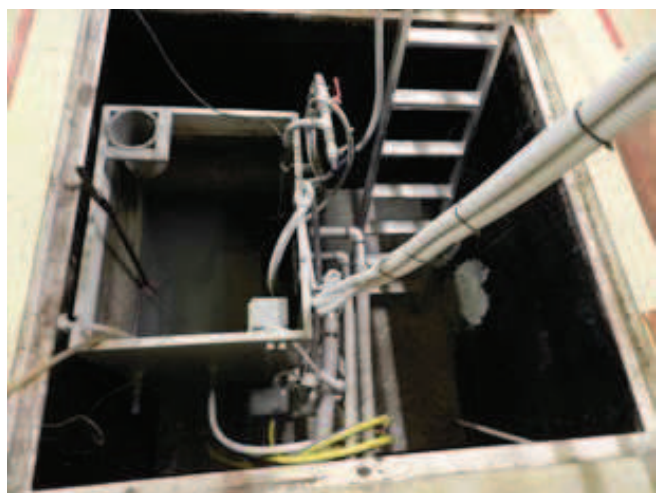
Figura 2-35 – Rimozione del serbatoio SR1 ed inserimento nuovo serbatoio
