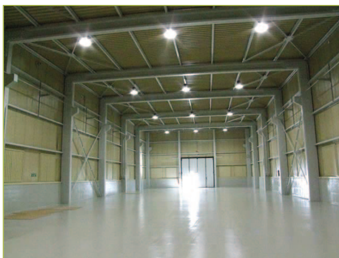
Figura 2-48 – Edificio BLD11 al termine delle attività di adeguamento
