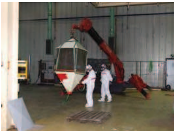
Figura 2-16 – Smontaggio filtri elettrostatici nell'area A124
