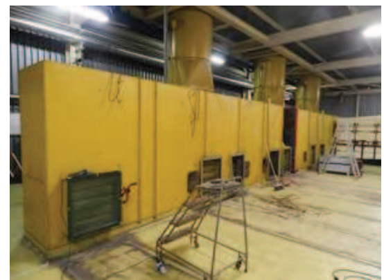
Figura 2-25 – Smantellamento filtrazione nel locale A221 dell'Edificio BLD2
