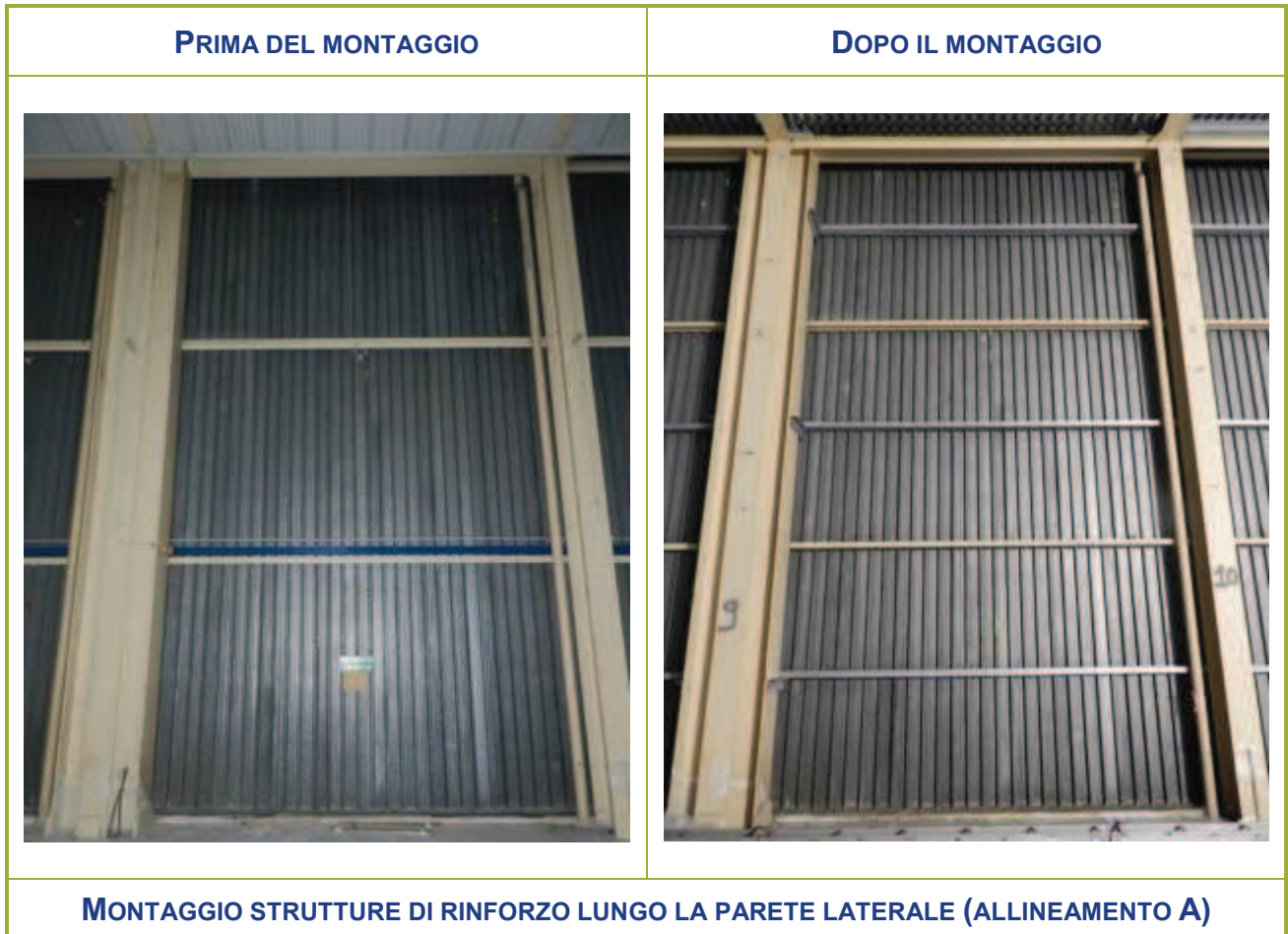
Figura 2-55 – Montaggio strutture di rinforzo lungo la parete laterale (Allineamento A)
