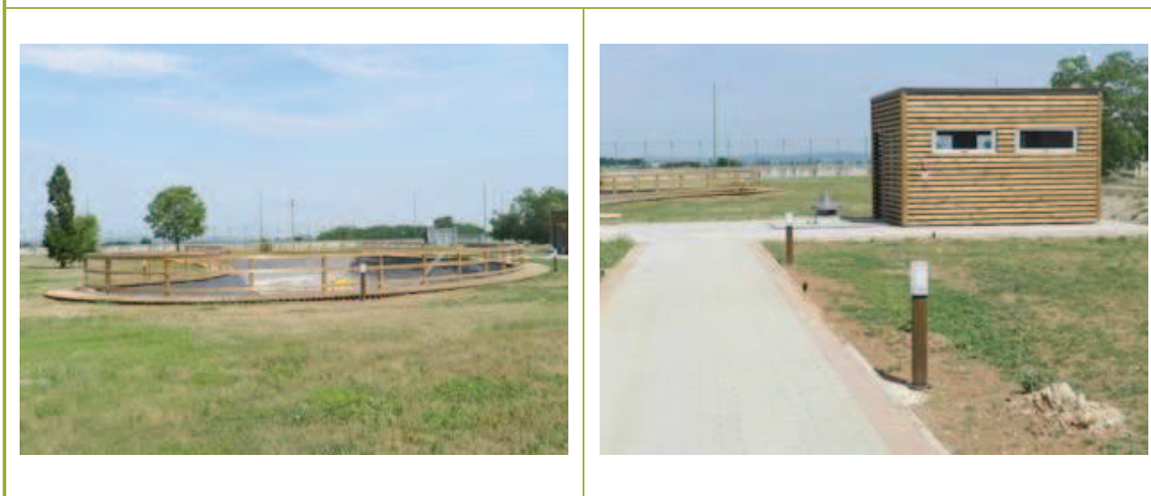
Figura 2-71 – Stato finale delle opere di realizzazione del bacino idrico e sistema di pressurizzazione
