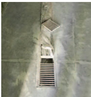
Figura 2-56 – Attività di montaggio delle canaline del sistema drenaggi all'interno del B106
