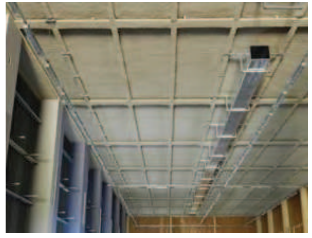
Figura 2-62 – Attività di posa staffaggi e condotta ventilazione sul soffitto B106
