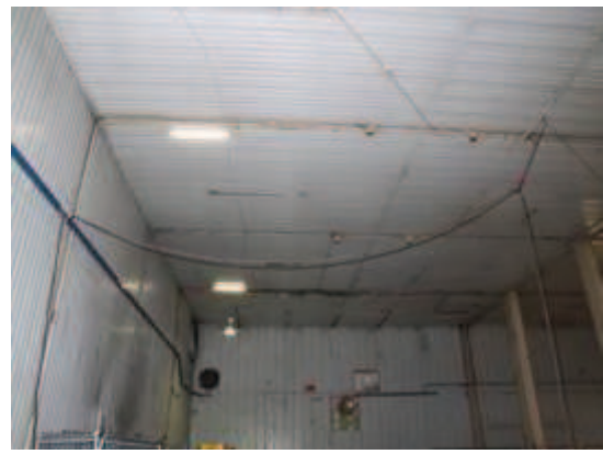
Figura 2-18 – Smantellamento mandata e ricircolo in area A110 (tubazioni verdi e grigie)
