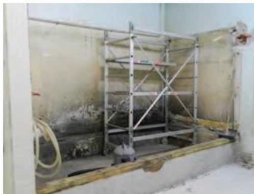
Figura 2-39 – Smantellamento della vasca di decontaminazione
