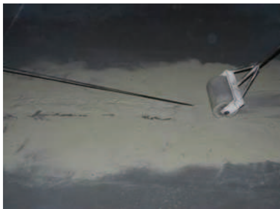
Figura 2-58 – Attività di realizzazione basamento locale B106 (2)
