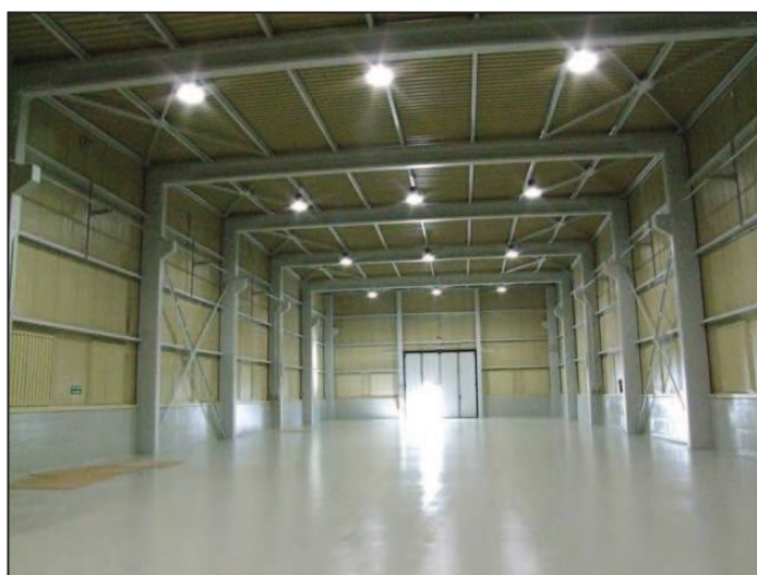
Figura 2-51 – Edificio BLD11 al termine delle attività di adeguamento
