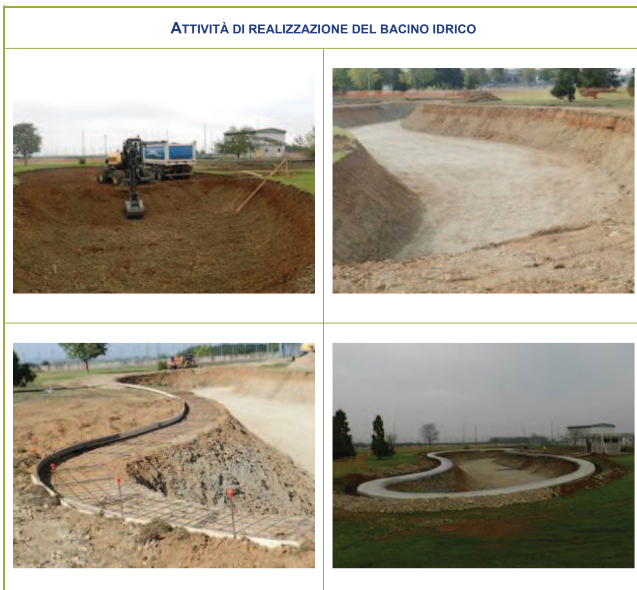
Figura 2-57 – Attività di realizzazione del bacino idrico
