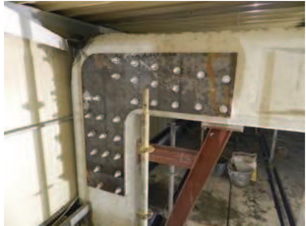
DOPO IL MONTAGGIO
