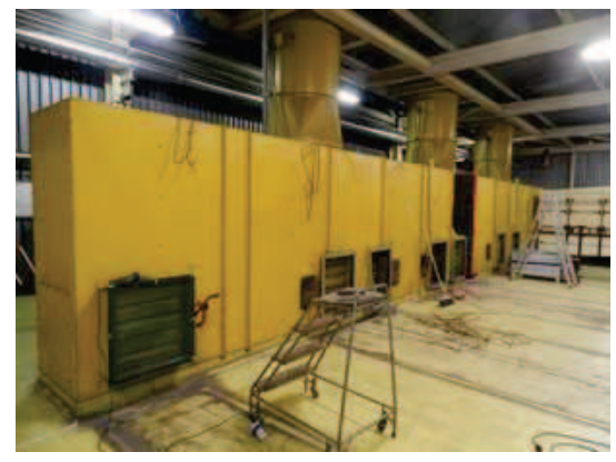
Figura 2-25 – Smantellamento filtrazione nel locale A221 dell'Edificio BLD2
