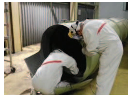
Figura 2-24 – Smantellamento tubazioni nel locale A221 dell'Edificio BLD2
