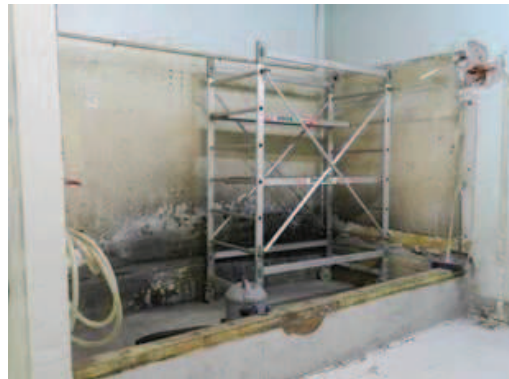
Figura 2-39 – Smantellamento della vasca di decontaminazione
