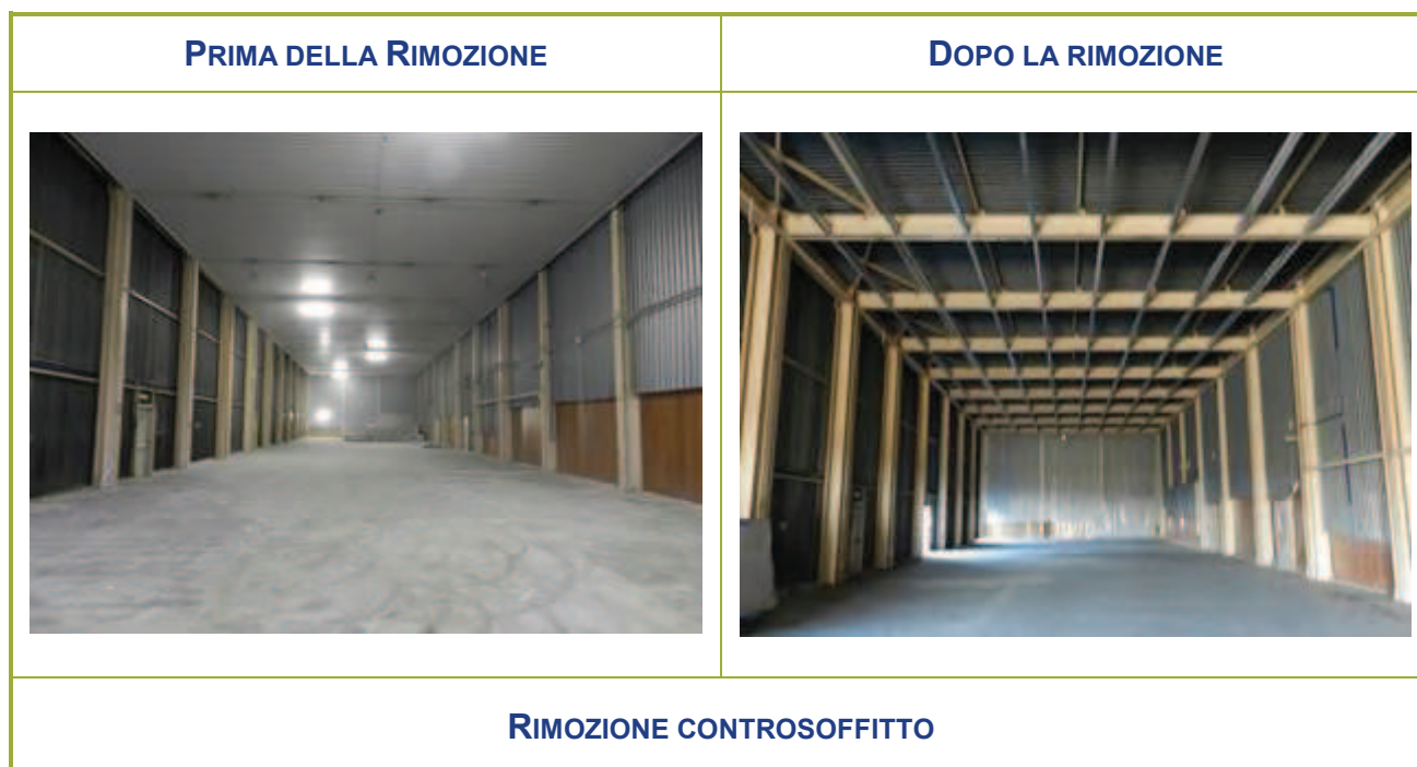
Figura 2-53 – Attività di rimozione del controsoffitto del locale B106
