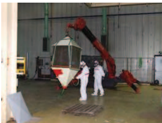
Figura 2-16 – Smontaggio filtri elettrostatici nell'area A124
