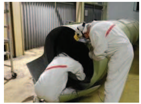
Figura 2-24 – Smantellamento tubazioni nel locale A221 dell'Edificio BLD2
