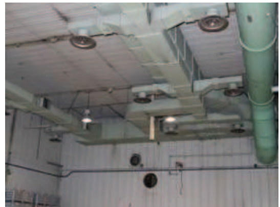
Figura 2-17 – Smantellamento impianto di espulsione nel locale A109 (tubazioni gialle)
