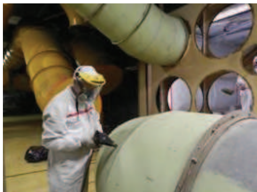
Figura 2-24 – Smantellamento tubazioni nel locale A221 dell'Edificio BLD2
