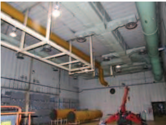
Figura 2-17 – Smantellamento impianto di espulsione nel locale A109 (tubazioni gialle)
