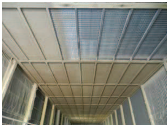
Figura 2-57 – Attività di posa dell'intonaco ignifugo
