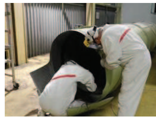
Figura 2-24 – Smantellamento tubazioni nel locale A221 dell'Edificio BLD2
