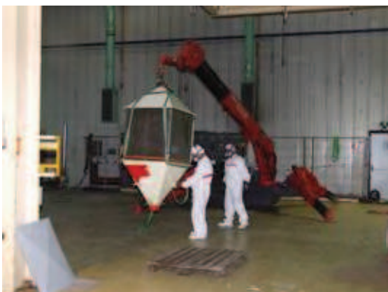
Figura 2-16 – Smontaggio filtri elettrostatici nell'area A124
