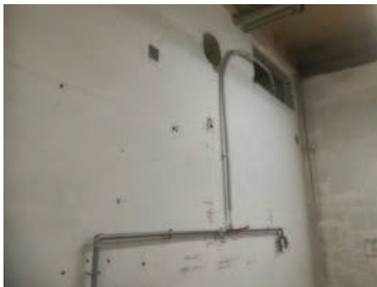
Figura 2-44 – Predisposizione tubazione scarico effluenti liquidi di cantiere
