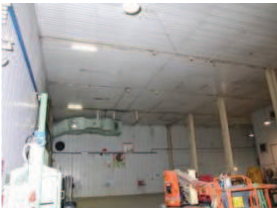
Figura 2-18 – Smantellamento mandata e ricircolo in area A110 (tubazioni verdi e grigie)
