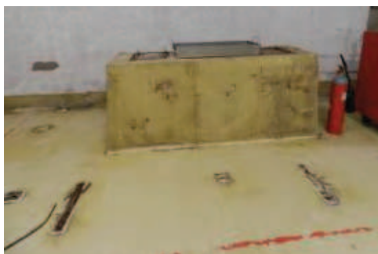
Figura 2-37 – Rimozione del serbatoio SR3
