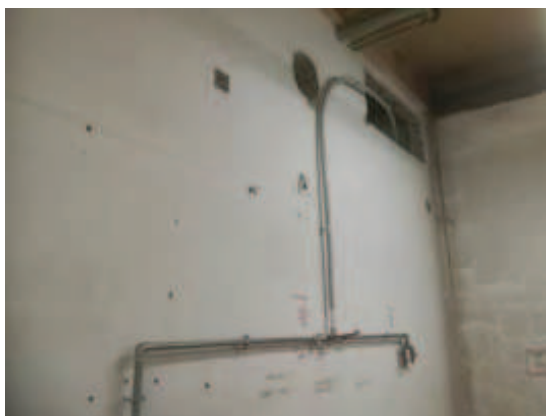
Figura 2-47 – Predisposizione tubazione scarico effluenti liquidi di cantiere
