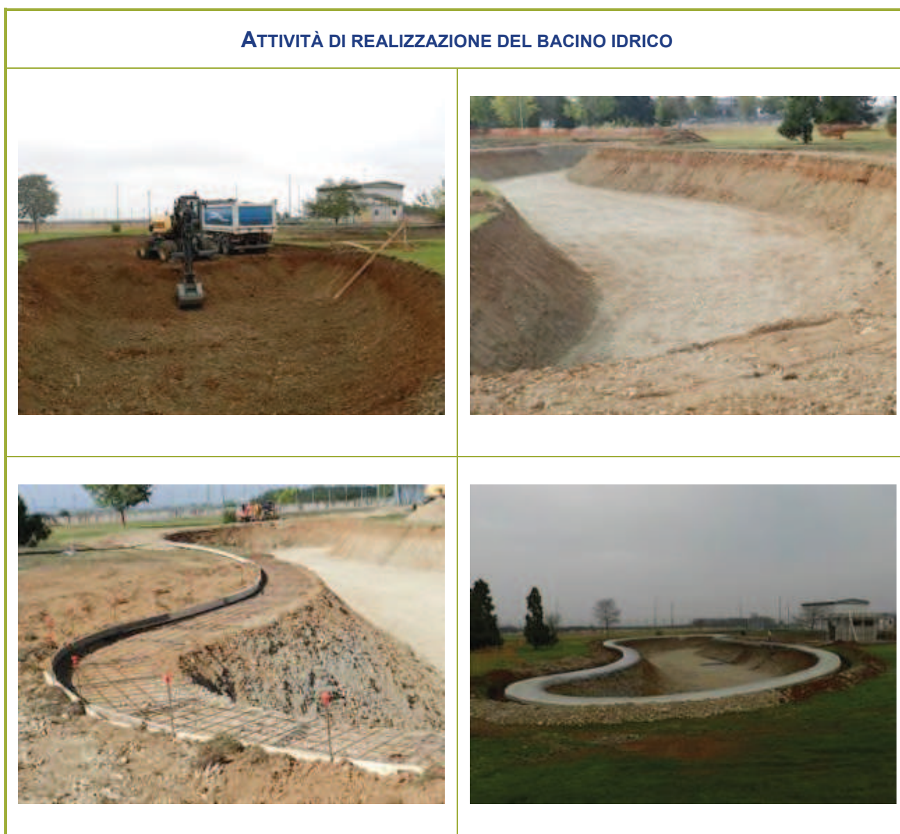
Figura 2-52 – Attività di realizzazione del bacino idrico
