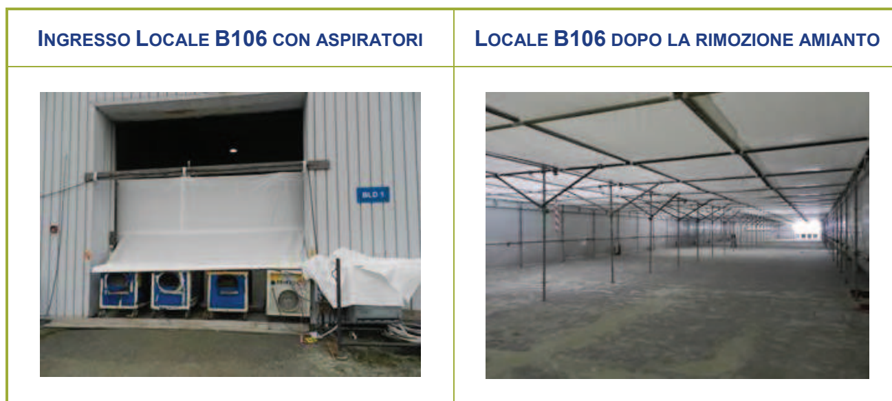
Figura 2-52 – Attività di rimozione amianto dalla pavimentazione del locale B106
