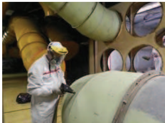
Figura 2-24 – Smantellamento tubazioni nel locale A221 dell'Edificio BLD2
