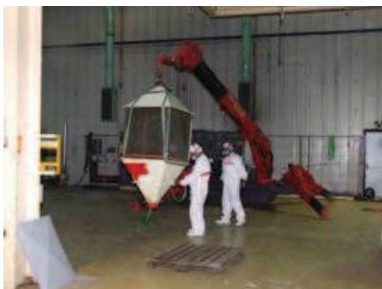
Figura 2-16 – Smontaggio filtri elettrostatici nell'area A124
