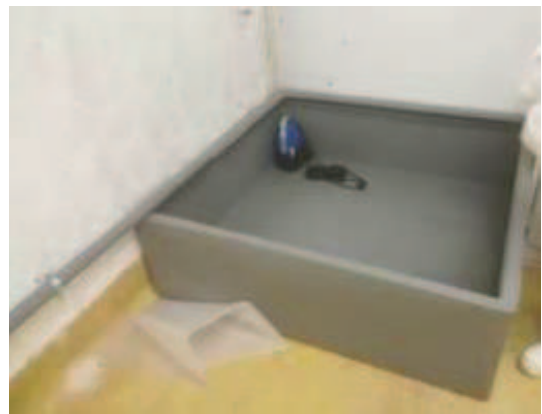
Figura 2-44 – Predisposizione tubazione scarico effluenti liquidi di cantiere
