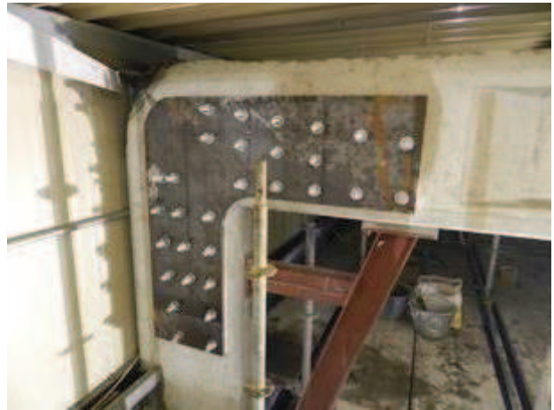
DOPO IL MONTAGGIO
