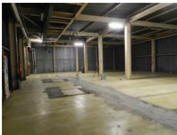
Figura 2-33 – Rimozione del linoleum nel locale A221
