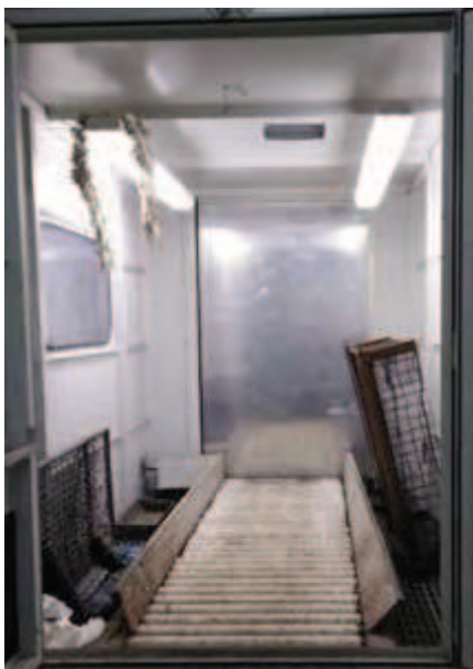
Figura 2-46 – Pulizia cabina di decontaminazione ad umido e recupero fanghi
