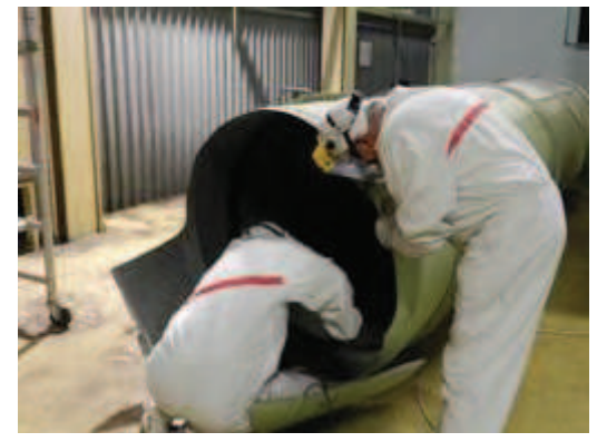
Figura 2-24 – Smantellamento tubazioni nel locale A221 dell'Edificio BLD2
