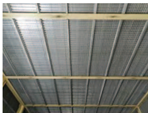
Figura 2-59 – Attività di montaggio della rete per successiva posa dell'intonaco ignifugo
