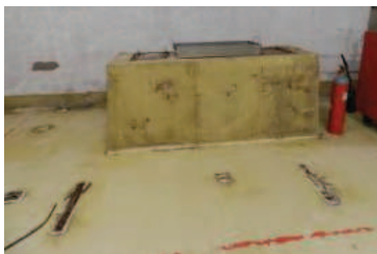
Figura 2-37 – Rimozione del serbatoio SR3
