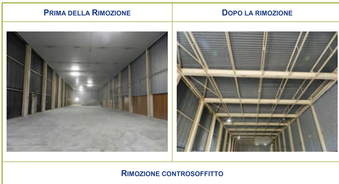
Figura 2-44 – Attività di rimozione del controsoffitto del locale B106
