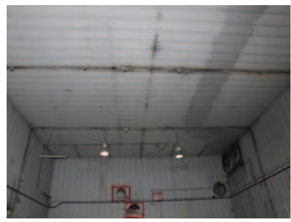
Figura 2-19 – Smantellamento mandata e ricircolo nel locale A109 (tubazioni verdi e grigie)
