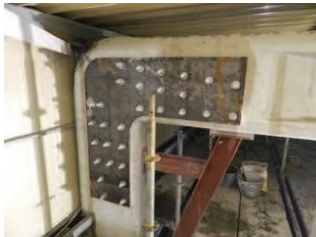
DOPO IL MONTAGGIO
