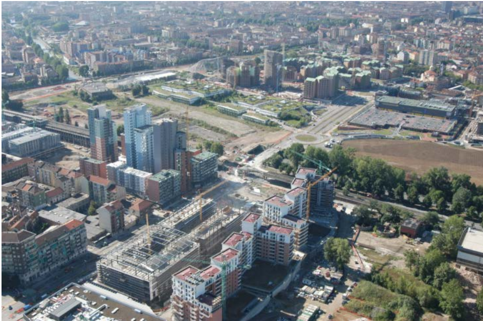
Figura 2 - Quartiere Dora, Spina 3, vista area complessiva
