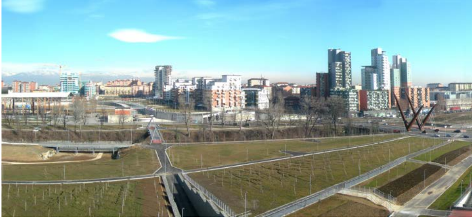
Figura 1 - Quartiere Dora, Spina 3, vista panoramica verso nord
