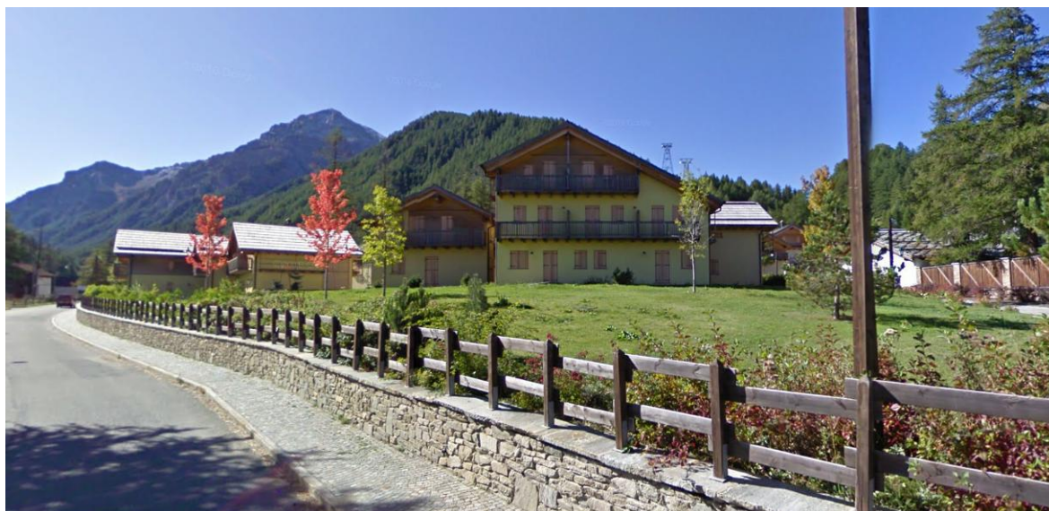
Edifici esistenti visti dall'attuale strada di accesso alla Val Troncea (©2017Google)
