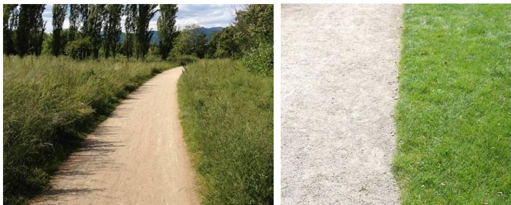
Esempi di realizzazioni di viali in stabilizzato sciolto additivato
