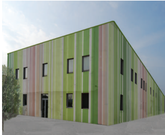
Quinta laterale su fronte campagna con orditura più articolata dei pannelli colorati
