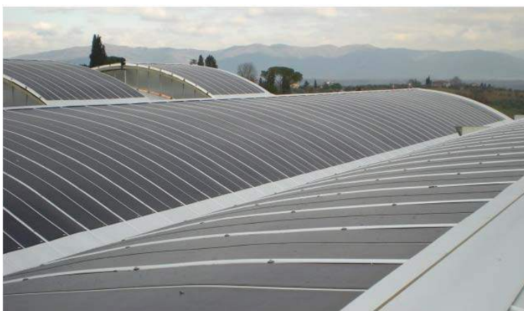
Pannelli fotovoltaici integrati nella sezione delle coperture
