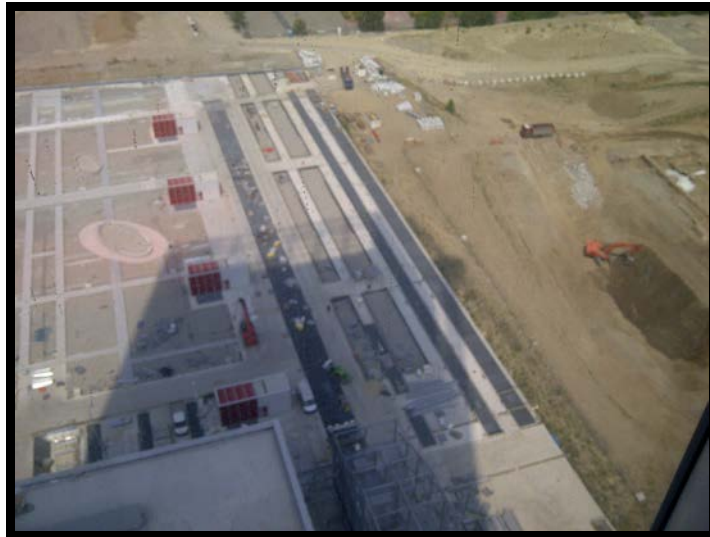
Foto area di cantiere ante-opera (Lotto 1)
