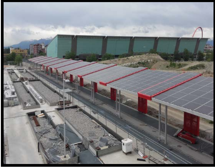
Foto area di cantiere post-opera (Lotto 1)
