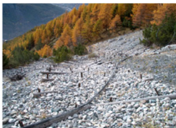
Foto 3-4. Interventi di manutenzione del reticolo delle acque
