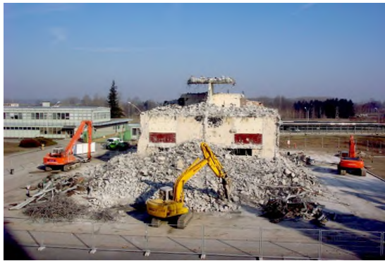
Smantellamento ciclo termico dell'edificio turbina
