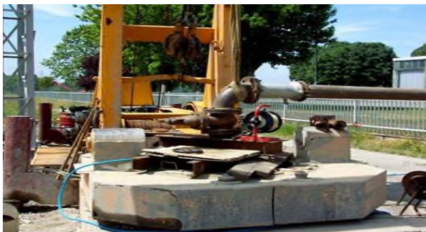
Realizzazione di nuovi pozzi di prelievo dalla falda
