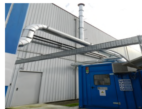
Impianto ausiliario di ventilazione
