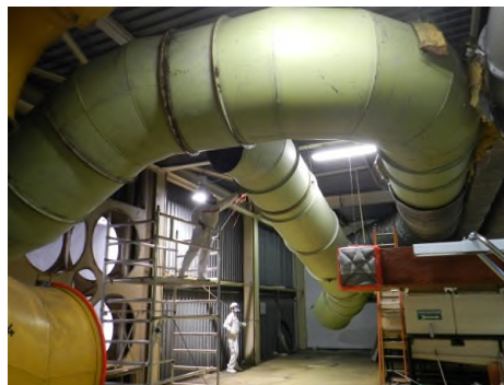
Smantellamento dell'impianto di ventilazione
