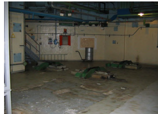
Rimozione componenti non contaminati (es. smantellamento locale scambiatori, ...)
