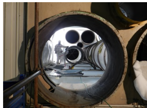
Smantellamento dell'impianto di ventilazione
