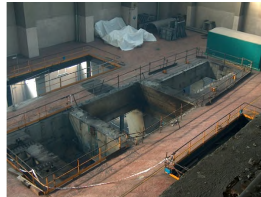
Smantellamento ciclo termico dell'edificio turbina
