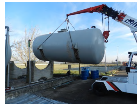
Smantellamento di un serbatoio dell'impianto di trattamento liquidi reflui
