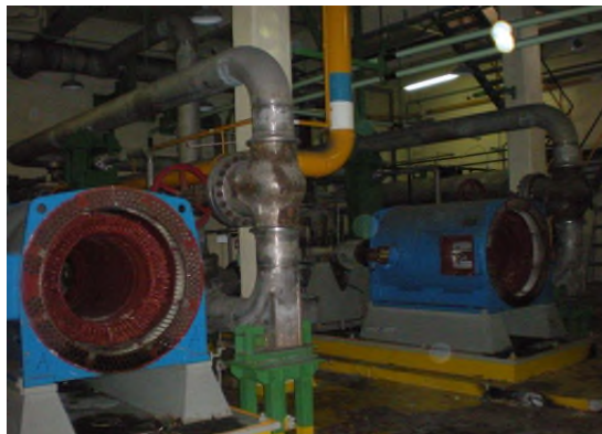
Rimozione componenti non contaminati (es. smantellamento locale scambiatori, ...)
