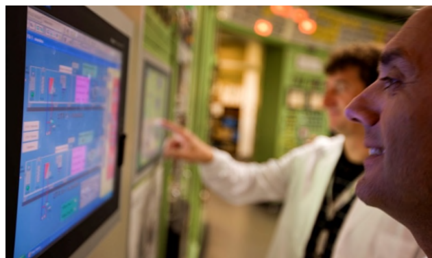
Messa in esercizio del sistema di ventilazione dell'edificio reattore
