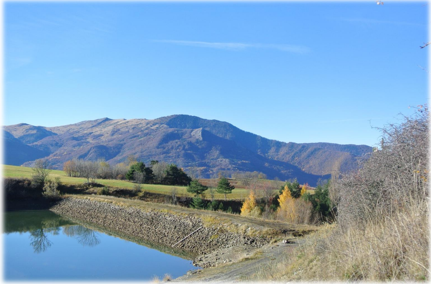
Barrage des B... (France, Gap)
