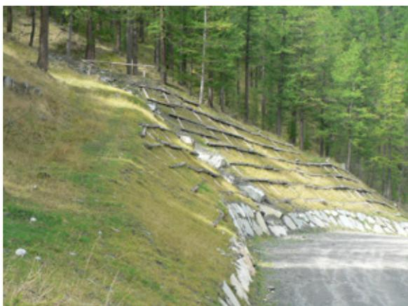
**Foto 6** La stabilizzazione di superfici molto acclivi, quale è il caso delle scarpate stradali, può avvenire attraverso l'impiego della tecnica delle grate vive (Val Troncea, presso Pragelato – TO).
