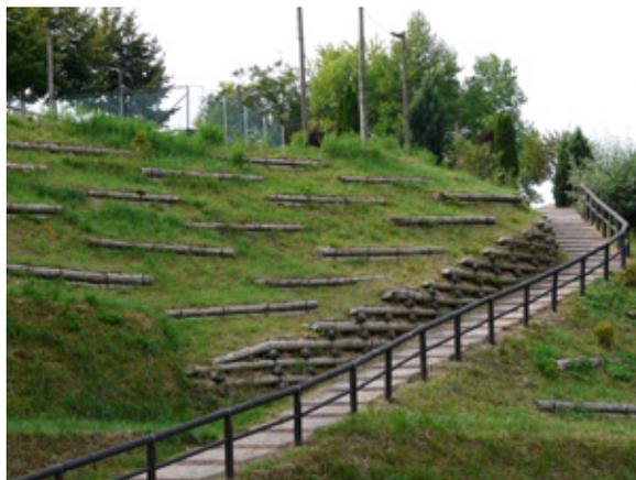
**Foto 5 La stabilizzazione delle coltri più superficiali di terreno può essere effettuata disponendo sui versanti linee continue o sfalsate di palificate semplici ( Comune di Strona - BI).**
