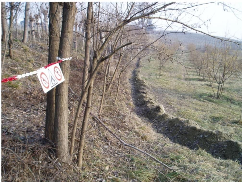
Figura 73. Scarpata di raccordo fra due porzioni di terreno, con fosso di guardia alla base.
