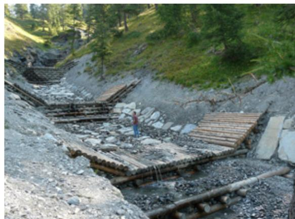
**Foto 7** L'erosione del fondo alveo di corsi d'acqua a regime variabile, caratterizzati da velocità di deflusso elevate e da capacità di trasporto di materiale solido, può essere mitigata attraverso la messa in opera di sistemi di correzione della quota di fondo alveo, quali briglie e soglie in legname e pietra (Sestriere, TO).
