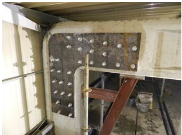
DOPO IL MONTAGGIO
