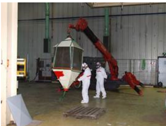
Figura 2-9 – Smontaggio filtri elettrostatici nell'area A124
