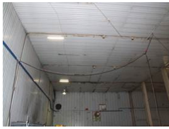
Figura 2-11 – Smantellamento mandata e ricircolo in area A110 (tubazioni verdi e grigie)
