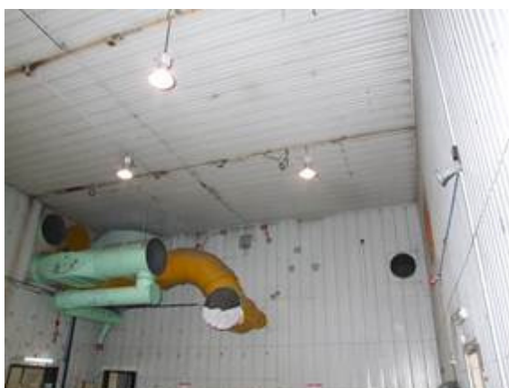
Figura 2-13 – Smantellamento impianto di ventilazione nel locale A108
