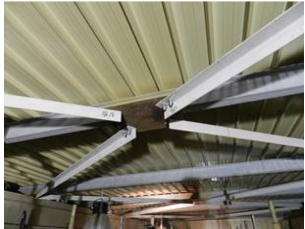
DOPO IL MONTAGGIO
