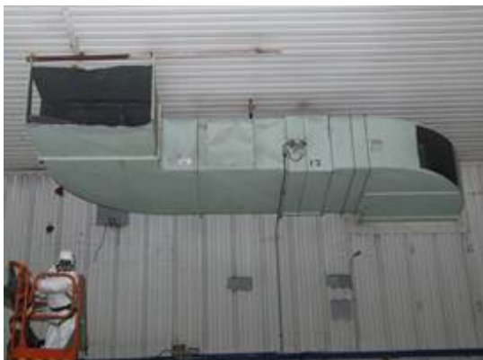
Figura 2-14 – Smantellamento impianto di ventilazione nelle aree A102, A103, A104, A105 e A107
