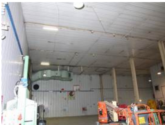
Figura 2-11 – Smantellamento mandata e ricircolo in area A110 (tubazioni verdi e grigie)
