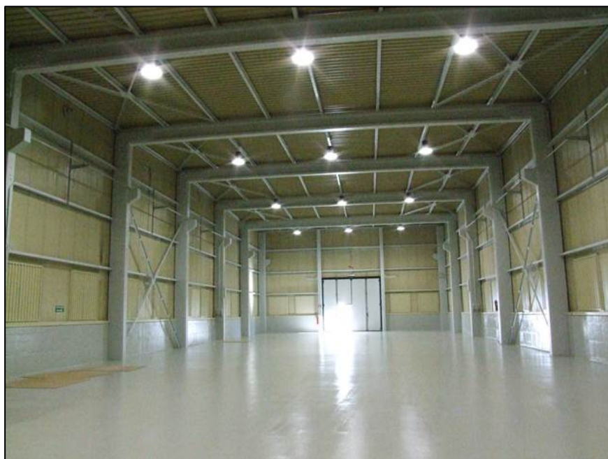
Figura 2-16 – Edificio BLD11 al termine delle attività di adeguamento
