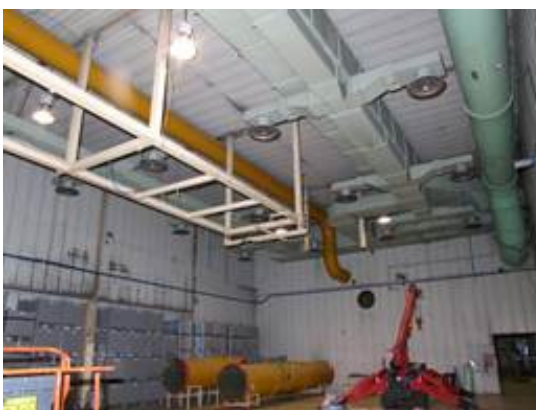
Figura 2-10 – Smantellamento impianto di espulsione nel locale A109 (tubazioni gialle)
