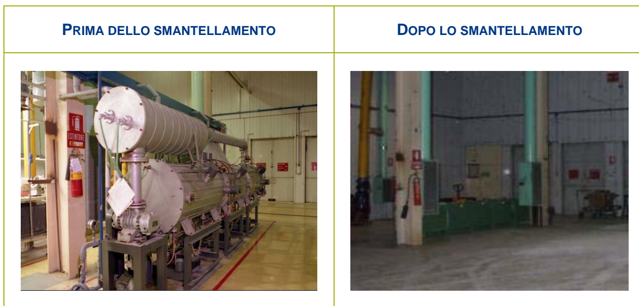
Figura 2-10 - Smantellamento forno di degasaggio (locale A110)
