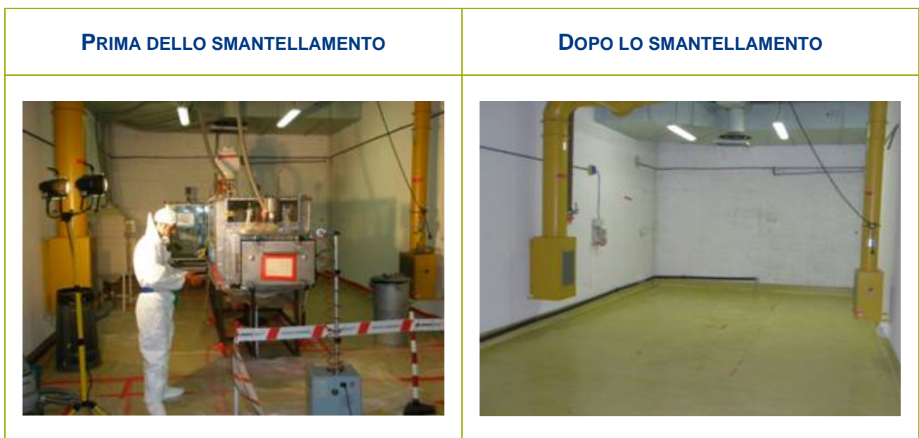
Figura 2-5 - Smantellamento scatola a guanti per il recupero dell'uranio dai filtri (locale A220)
