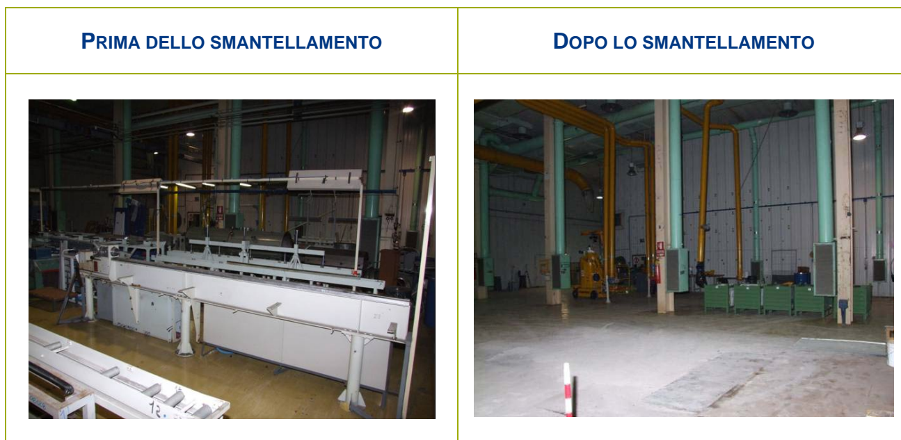
Figura 2-9 - Smantellamento banco di saldatura barre connettrici (locale A110)
