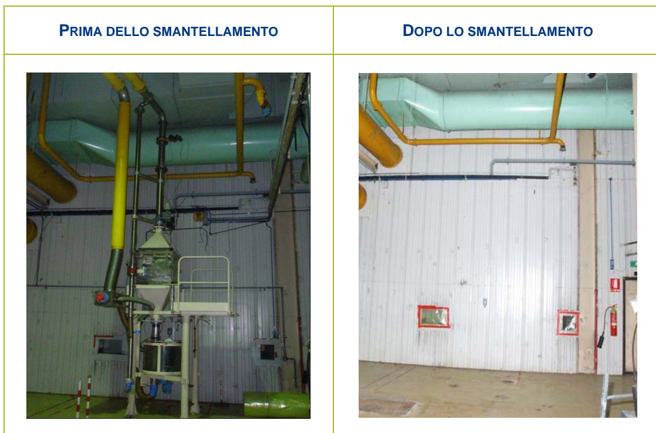
Figura 2-16 - Smantellamento filtro “Apitron” (locale A124)
