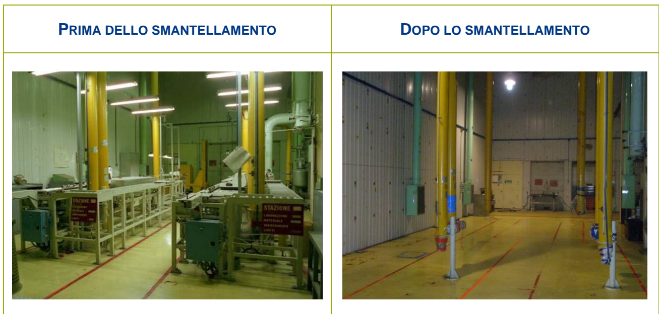
Figura 2-8 - Smantellamento banchi di caricamento pastiglie e banchi di saldatura secondo tappo (locale A110)
