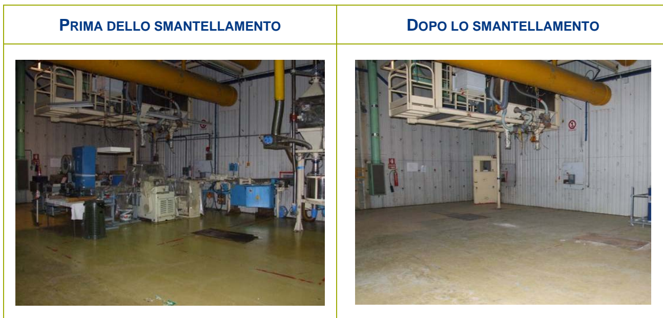
Figura 2-11 - Smantellamento rettifiche senza centro (loCALE A124)
