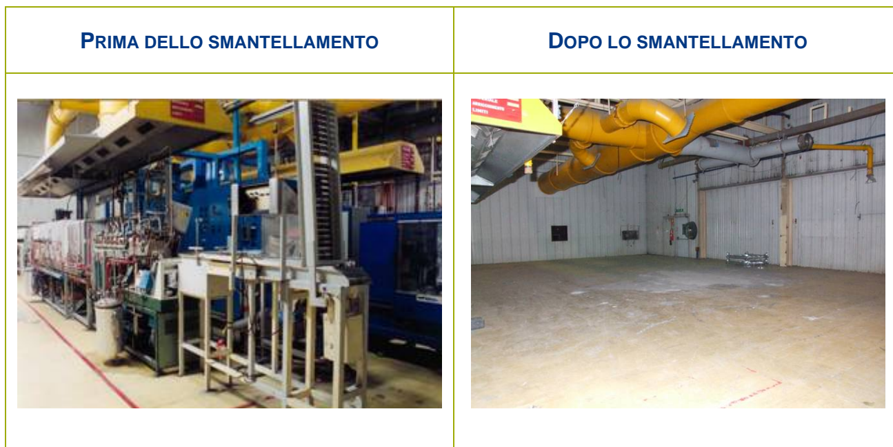
Figura 2-13 - Smantellamento forni di sinterizzazione (locale A109)
