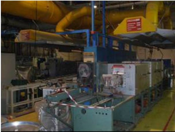
Smantellamento forni di sinterizzazione (locale A109)
