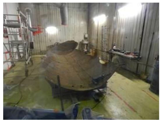
Figura 2-31 – Smantellamento del serbatoio SR6 nella capannina di taglio (A102)
