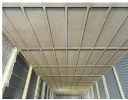
Figura 2-57 – Attività di posa dell'intonaco ignifugo
