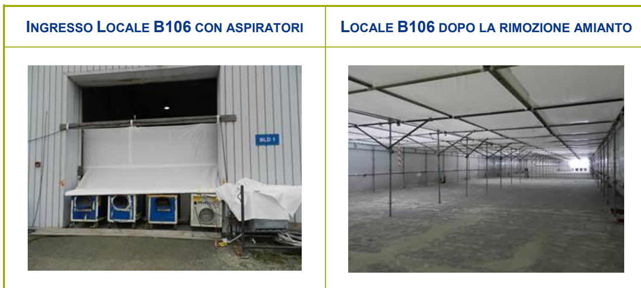
Figura 2-49 – Attività di rimozione amianto dalla pavimentazione del locale B106
