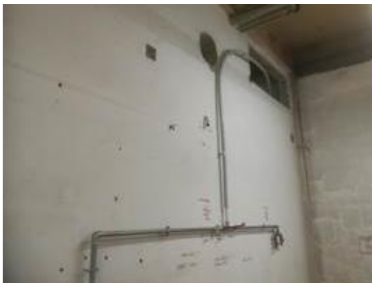
Figura 2-44 – Predisposizione tubazione scarico effluenti liquidi di cantiere
