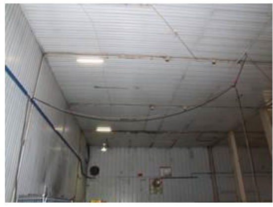
Figura 2-18 – Smantellamento mandata e ricircolo in area A110 (tubazioni verdi e grigie)
