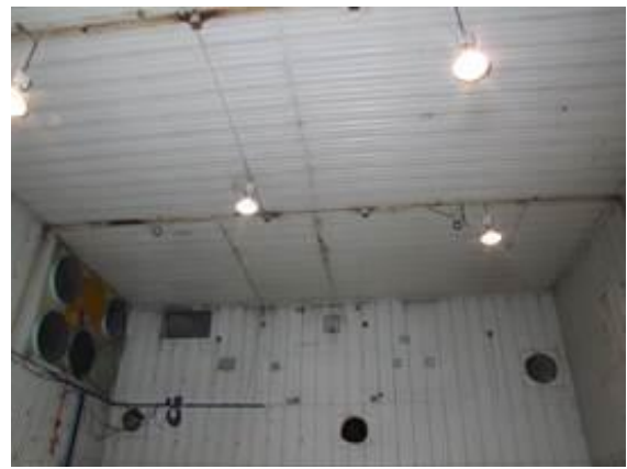
Figura 2-20 – Smantellamento impianto di ventilazione nel locale A108
