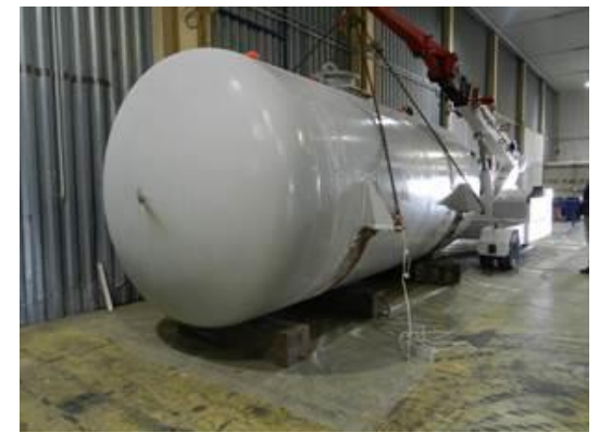
Figura 2-30 – Rimozione del serbatoio SR6 e posizionamento nel locale B106
