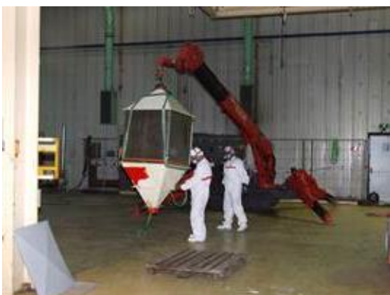
Figura 2-16 – Smontaggio filtri elettrostatici nell'area A124
