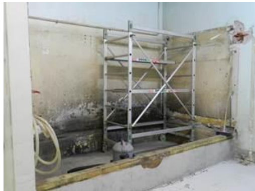
Figura 2-39 – Smantellamento della vasca di decontaminazione
