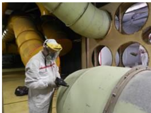
Figura 2-24 – Smantellamento tubazioni nel locale A221 dell'Edificio BLD2
