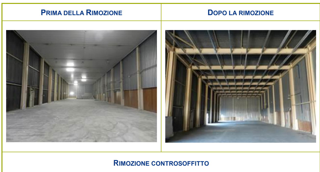
Figura 2-50 – Attività di rimozione del controsoffitto del locale B106
