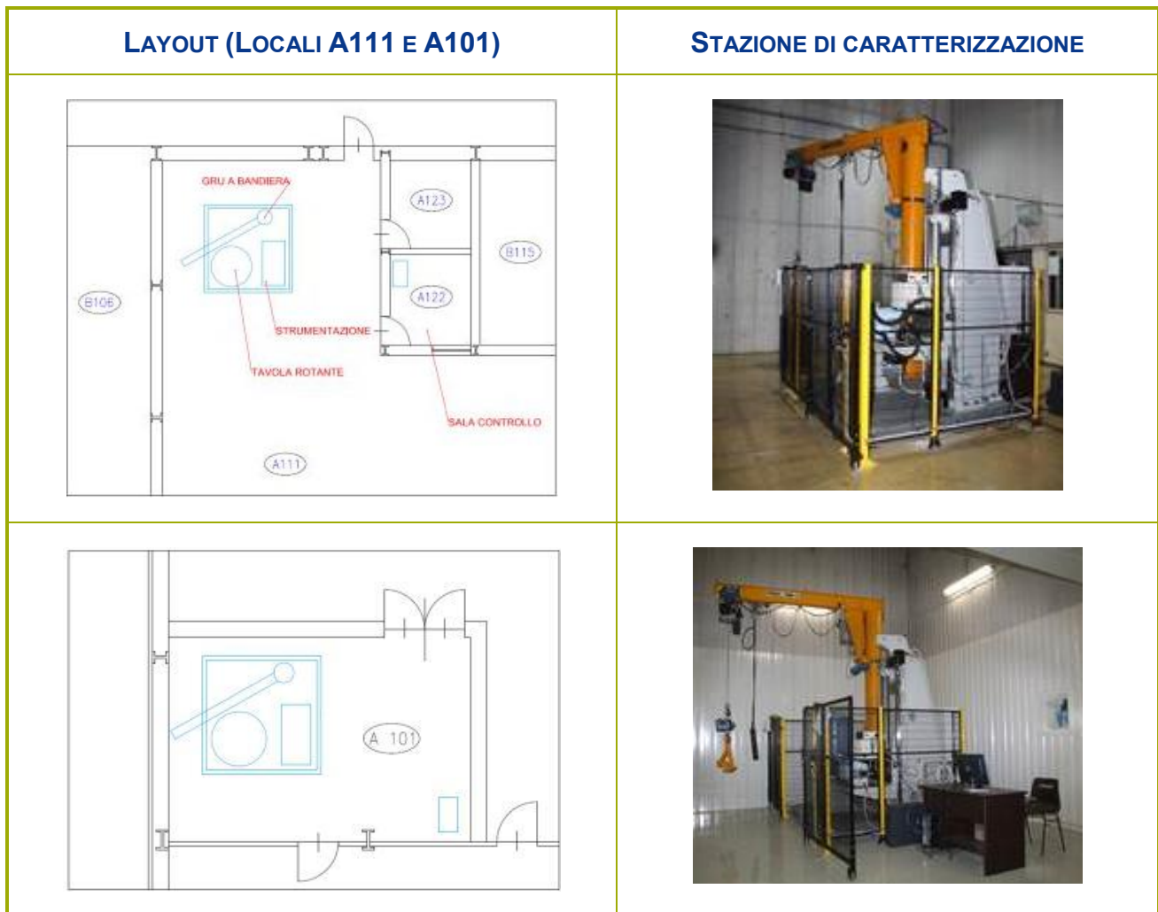
Figura 2-9 – Stazione per la caratterizzazione dei fusti di rifiuti radioattivi (locali A111 e A101)
