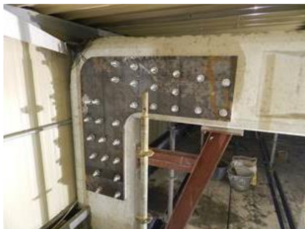
DOPO IL MONTAGGIO
