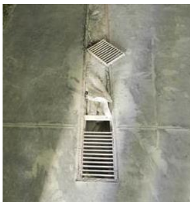
Figura 2-53 – Attività di montaggio delle canaline del sistema drenaggi all'interno del B106
