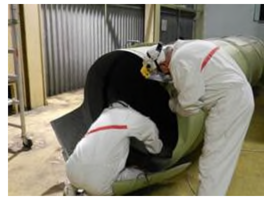
Figura 2-24 – Smantellamento tubazioni nel locale A221 dell'Edificio BLD2
