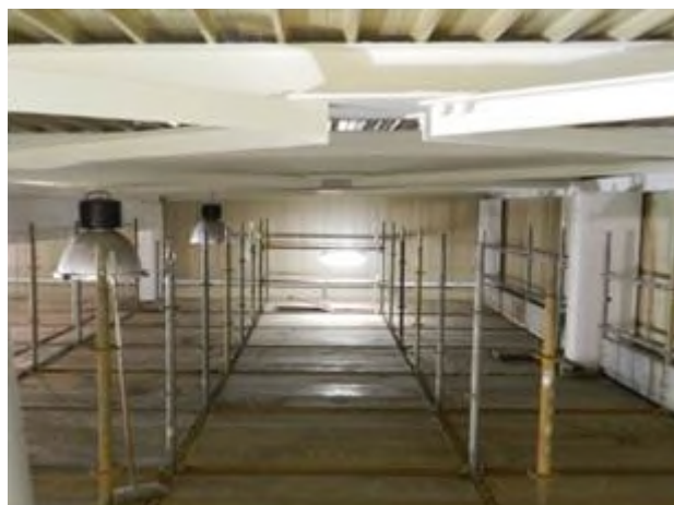
Fase III – Verniciatura intumescente per protezione antincendio delle travature
