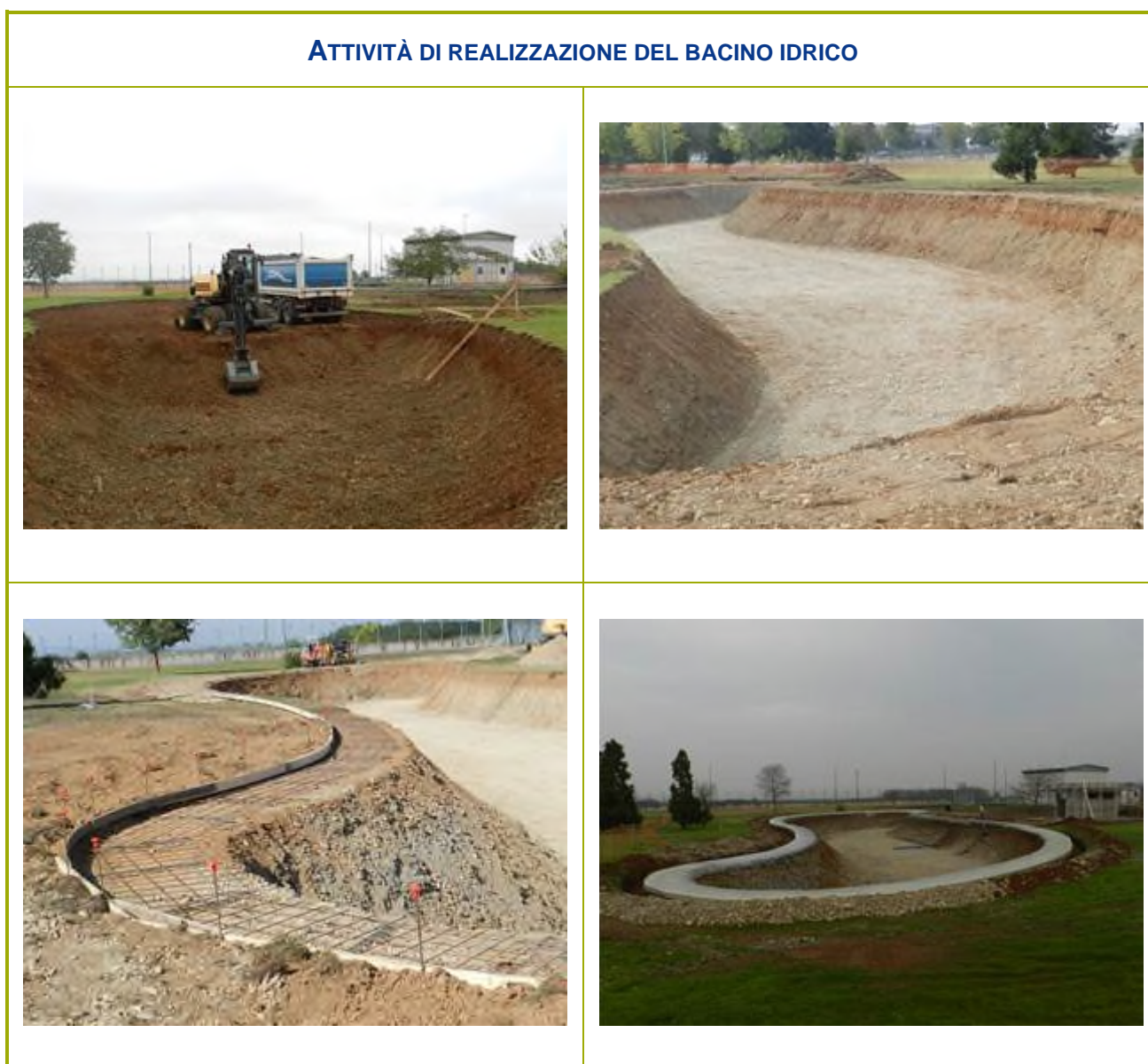
Figura 2-51 – Attività di realizzazione del bacino idrico
