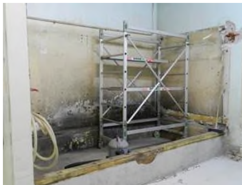
Figura 2-39 – Smantellamento della vasca di decontaminazione
