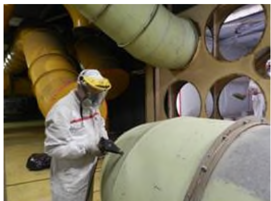
Figura 2-24 – Smantellamento tubazioni nel locale A221 dell'Edificio BLD2
