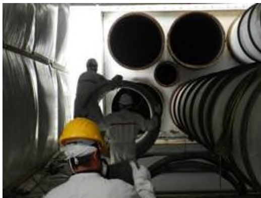
Figura 2-23 – Smantellamento delle condotte di ventilazione poste sopra al corridoio di passaggio che unisce l'Edificio BLD1 con l'Edificio BLD2
