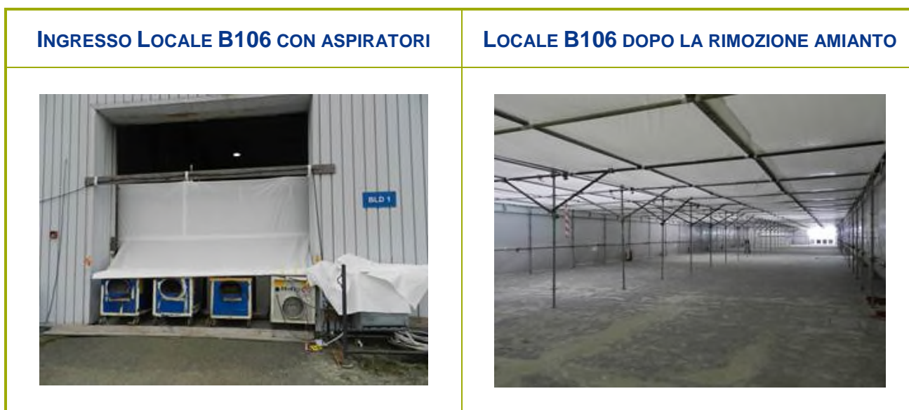
Figura 2-43 – Attività di rimozione amianto dalla pavimentazione del locale B106
