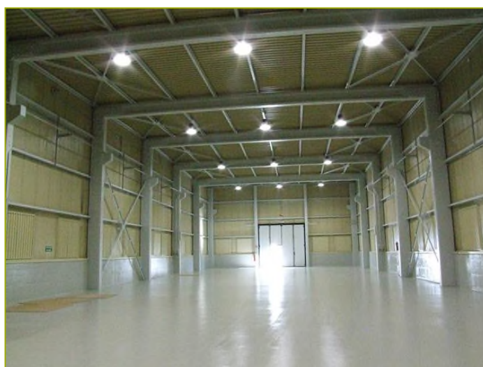
Figura 2-42 – Edificio BLD11 al termine delle attività di adeguamento
