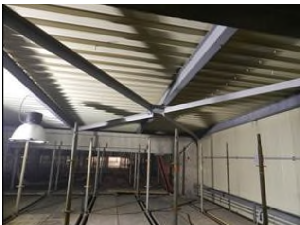
Fase III – Verniciatura intumescente per protezione antincendio delle travature
