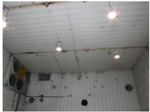
Figura 2-20 – Smantellamento impianto di ventilazione nel locale A108
