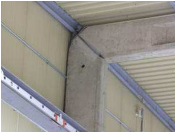
PRIMA DEL MONTAGGIO
