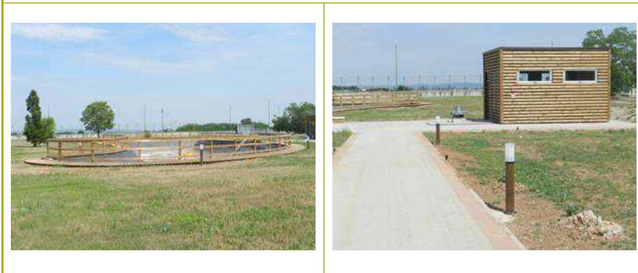
Figura 2-53 – Stato finale delle opere di realizzazione del bacino idrico e sistema di pressurizzazione
