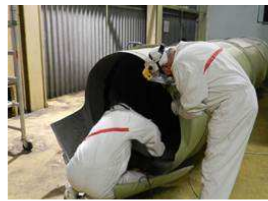
Figura 2-24 – Smantellamento tubazioni nel locale A221 dell'Edificio BLD2
