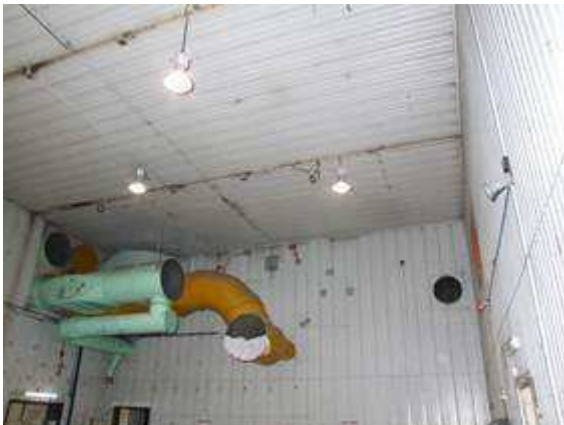
Figura 2-20 – Smantellamento impianto di ventilazione nel locale A108
