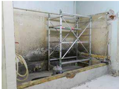
Figura 2-39 – Smantellamento della vasca di decontaminazione
