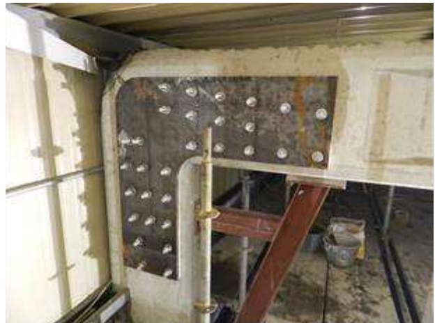
DOPO IL MONTAGGIO
