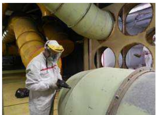
Figura 2-24 – Smantellamento tubazioni nel locale A221 dell'Edificio BLD2
