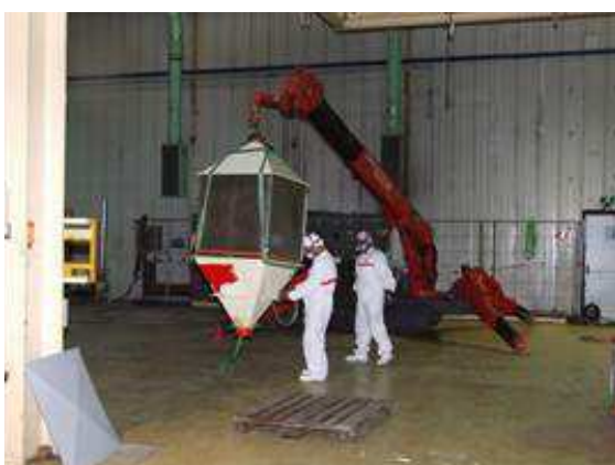
Figura 2-16 – Smontaggio filtri elettrostatici nell'area A124
