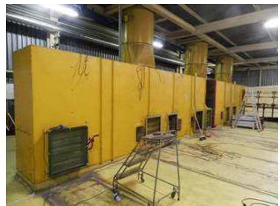
Figura 2-25 – Smantellamento filtrazione nel locale A221 dell'Edificio BLD2
