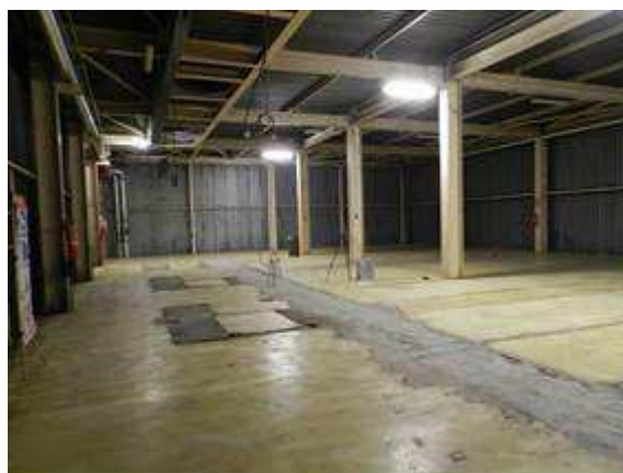
Figura 2-33 – Rimozione del linoleum nel locale A221
