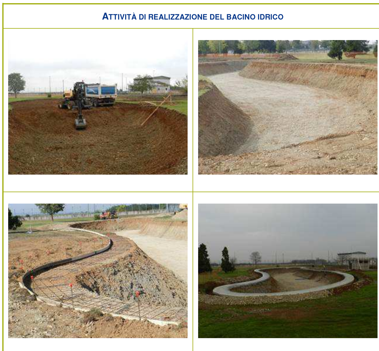
Figura 2-51 – Attività di realizzazione del bacino idrico
